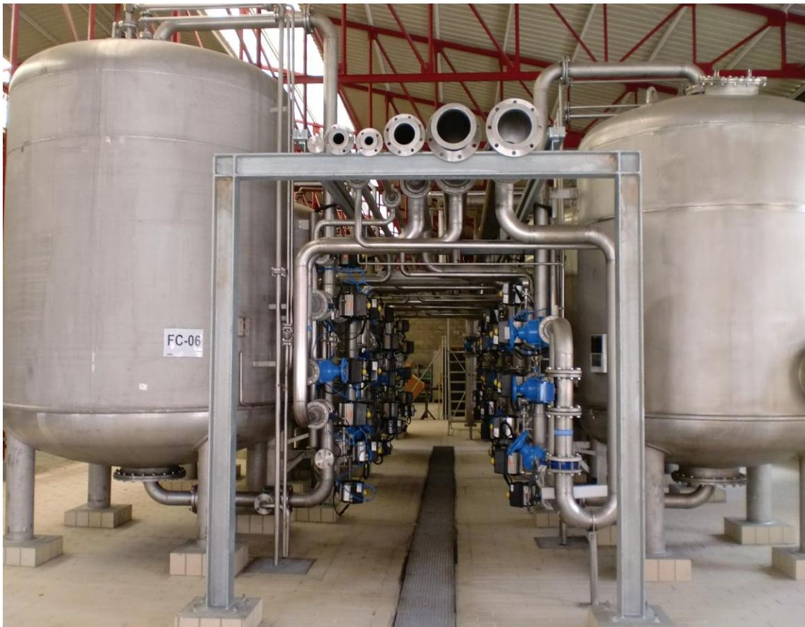
Figura 12. Filtros carbón (por cortesía de Heineken España S.A)
