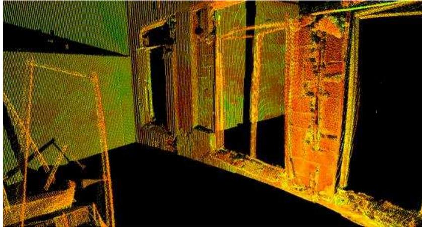
*Figura 14. Zona de máxima afección por parte del incendio.*
