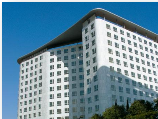
Figura 3. Edificio y oficinas
