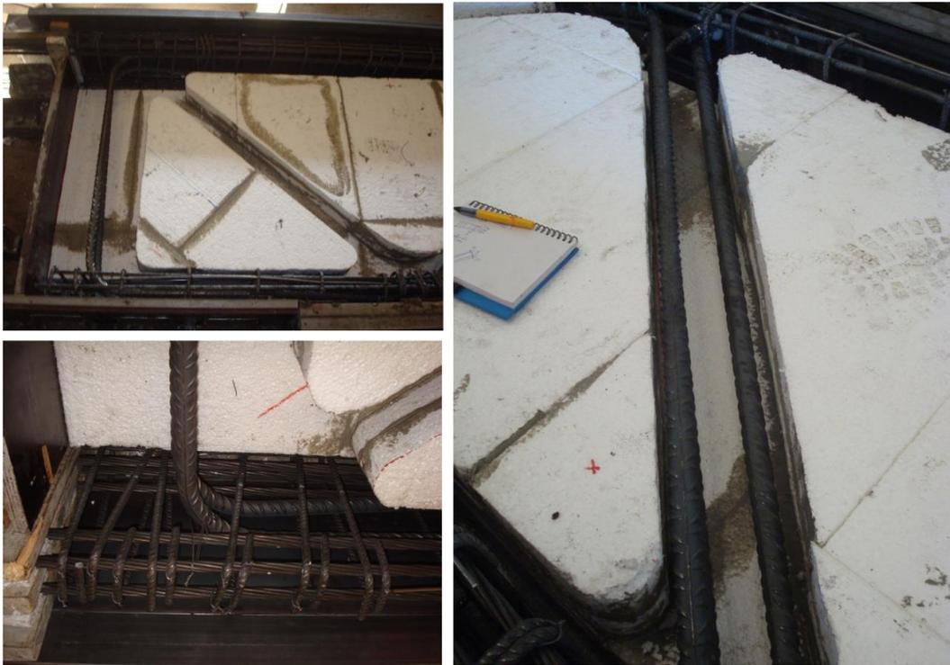
*Figura 4.6.- Detalle del armado en la zona de apoyos (izquierda); detalle de armado de la diagonal traccionada (derecha)*
