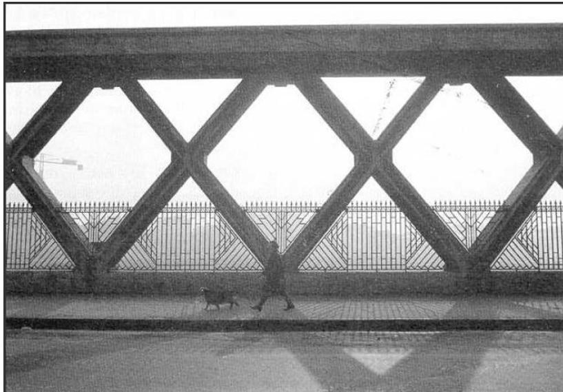
*Figura 3.39.- Pont de la Rue Lafayette. Detalle de la celosía de hormigón armado [Monleón 2005]*
