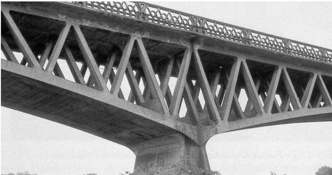
*Figura 3.42.- Puente del Boutiron, detalle de la triangulación y la articulación sobre las pilas [Monleón 2005]*
