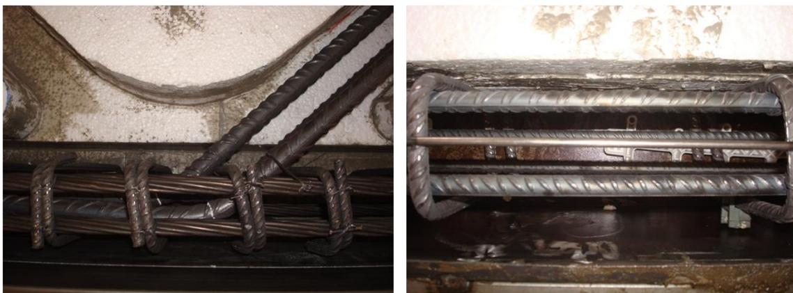
*Figura 4.7.- Detalle de un nudo en el cordón inferior (izquierda); detalle de la colocación de la armadura en el cordón superior (derecha)*
