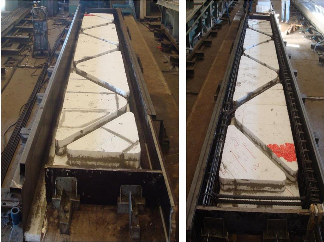
*Figura 4.9.- Molde antes y después de la colocación de la ferralla*
