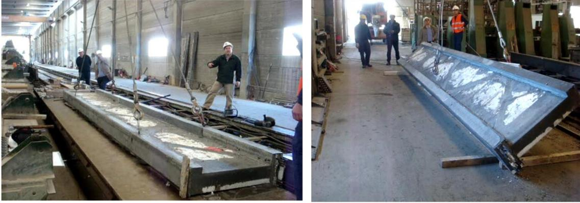
Figura 4.11.-. Extracción del molde y elevación hasta posición vertical de la celosía
