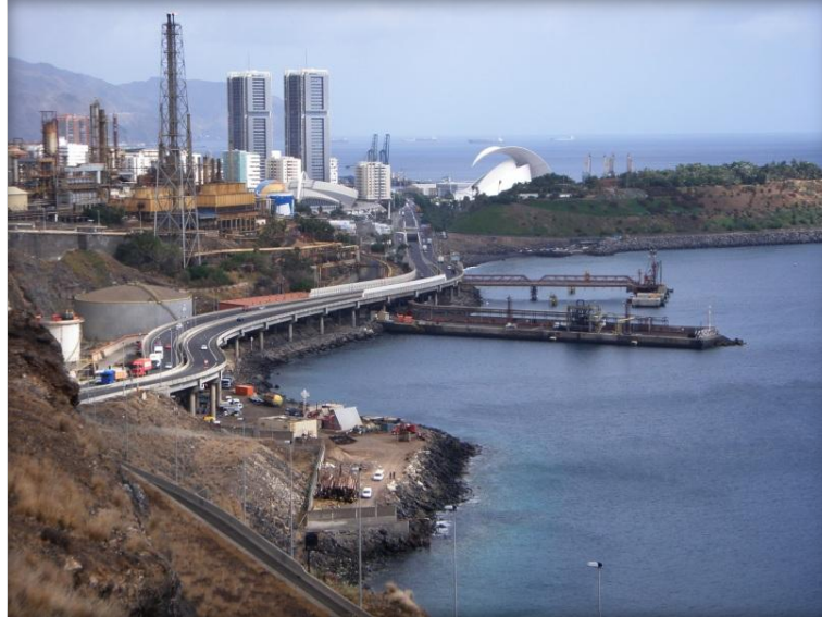
Imagen 7.3 “Instalaciones de la refinería Cepsa, junto a la zona de estudio”
