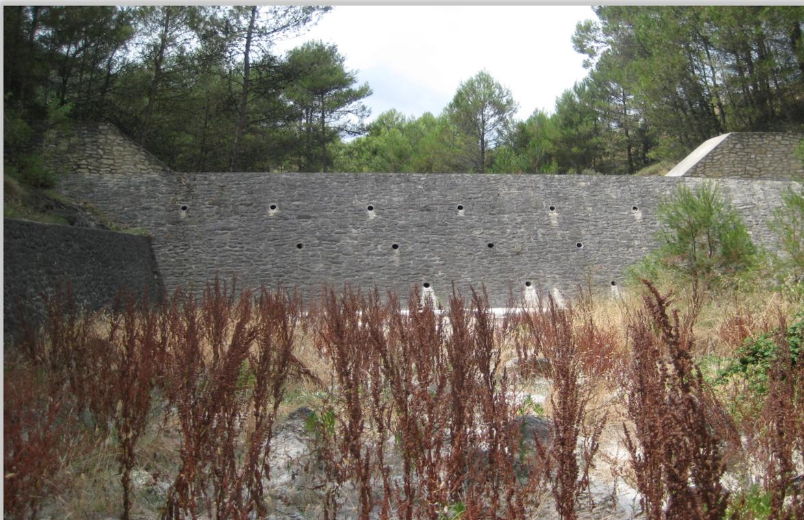
**Imagen 7. Hidrotecnia de corrección y protección lateral del cauce a su paso por Alcoy**
