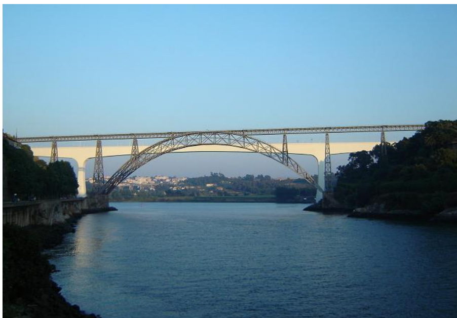
Fig. 4.44. Imagen del puente de entramado metálico María Pía, sobre el Duero en Oporto. (D.P.)
