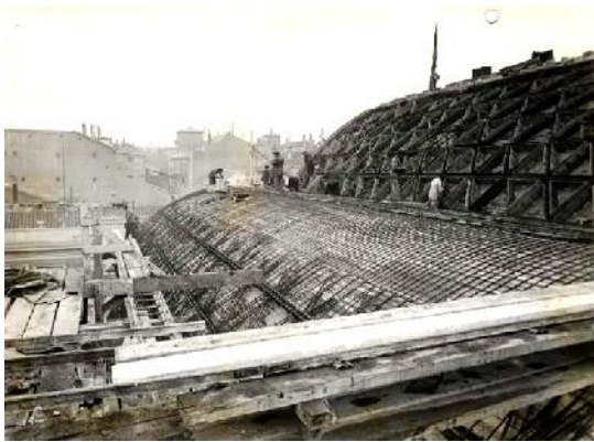
Encofrados y disposición de armaduras con el entramado de nervios triangulares.
