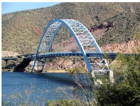
Fig. 1.5. Puente sobre el Lago Roosevelt en Arizona, en el que el peso del tablero y los vehículos es transmitido a los arcos metálicos por tendones también de acero. Edificio de la Empresa Arrow International en Reading, Pennsylvania, con la estructura de las plantas, colgada mediante perfiles metálicos.(Fot. De S. Rosenthal).
