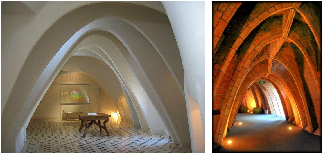
Fig. 6.4. Arcos catenarios de los desvanes de la casa Batlló y Milá de Barcelona. El esquema de planos paralelos con arcos catenarios, se repite sistemáticamente en la arquitectura de Gaudí. (Michael Stallbaum. D.P.)
