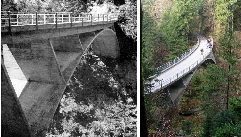
Fig. 6.80. Imágenes del puente Schwandbach, de trazado curvo. Especialmente significativo es el mínimo espesor tanto del arco como de los montantes.
