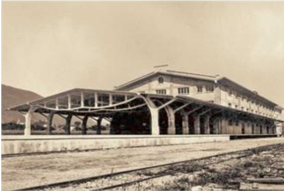
Fig. 6.85. Imagen de los pórticos de la nave abierta de almacenamiento exterior de los Almacenes Generales de Chiasso. (Fot. D.P.)
