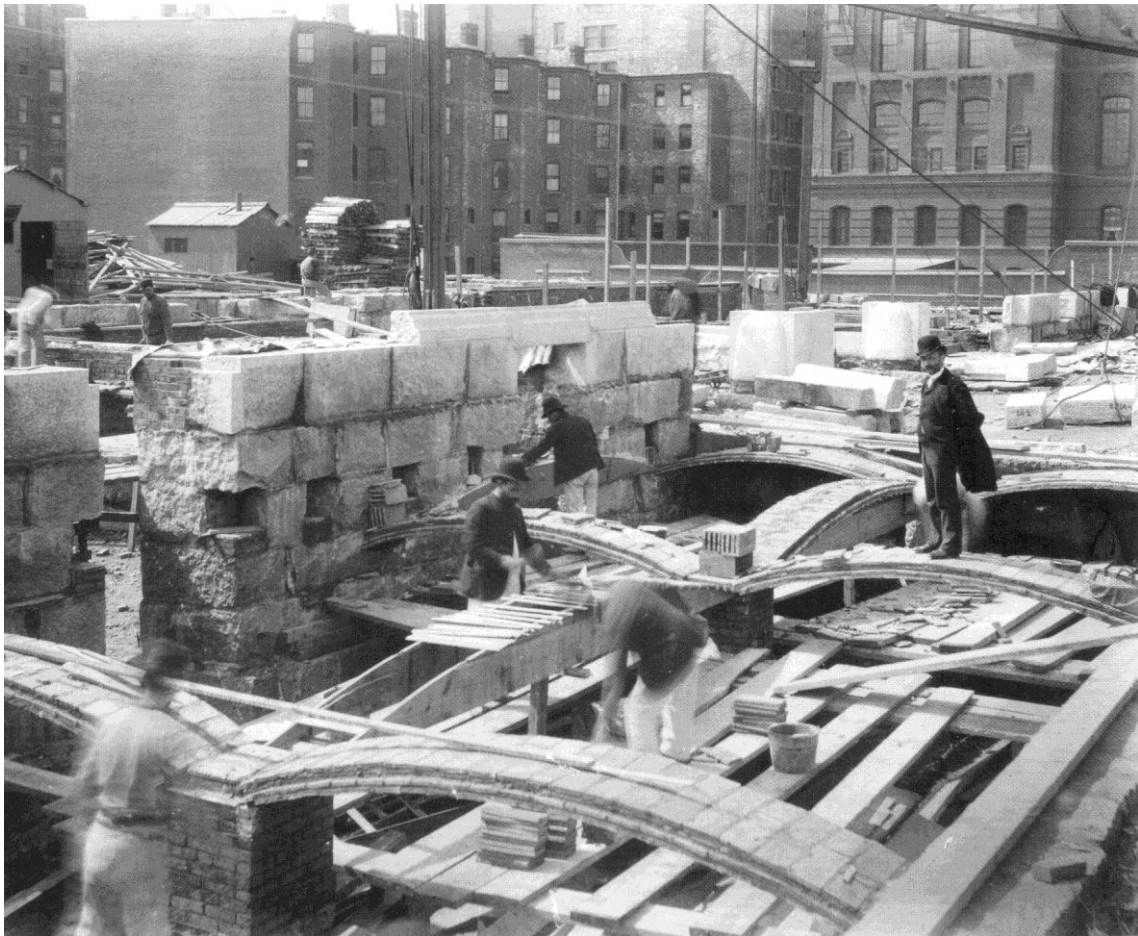
Fig. 6.46. Prueba de carga con 100.000 libras (45 Tn) sobre un arco de 12 pies (3.66m). Otras pruebas sobre una escalera tabicada realizada en 1903 (Guastavino. Collins Collection, Avery Library) y en la última aparece el propio Guastavino padre, subido sobre la clave de uno de los arcos formeros de las bóvedas de la Biblioteca Pública de Boston, de los arquitectos McKim, Mead y White. (Naturalmente estaba bien seguro de la estabilidad de los arcos que construía) (Print Department de la Boston Public Library).
