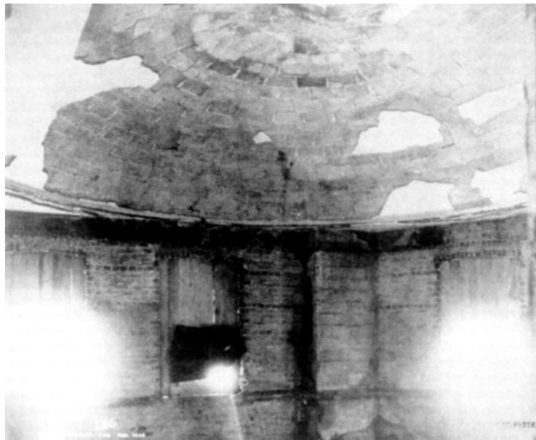
Fig. 6.47. Fotografía tomada tras el gran incendio que asoló Paterson, New Jersey, en 1902. En ella aparece una de las bóvedas tabicadas de los Guastavino, que había resistido con suficiencia, el fuego, manteniéndose estable, frente al fracaso estructural de las estructuras metálicas. (Guastavino. Collins Collection, Avery Library).
