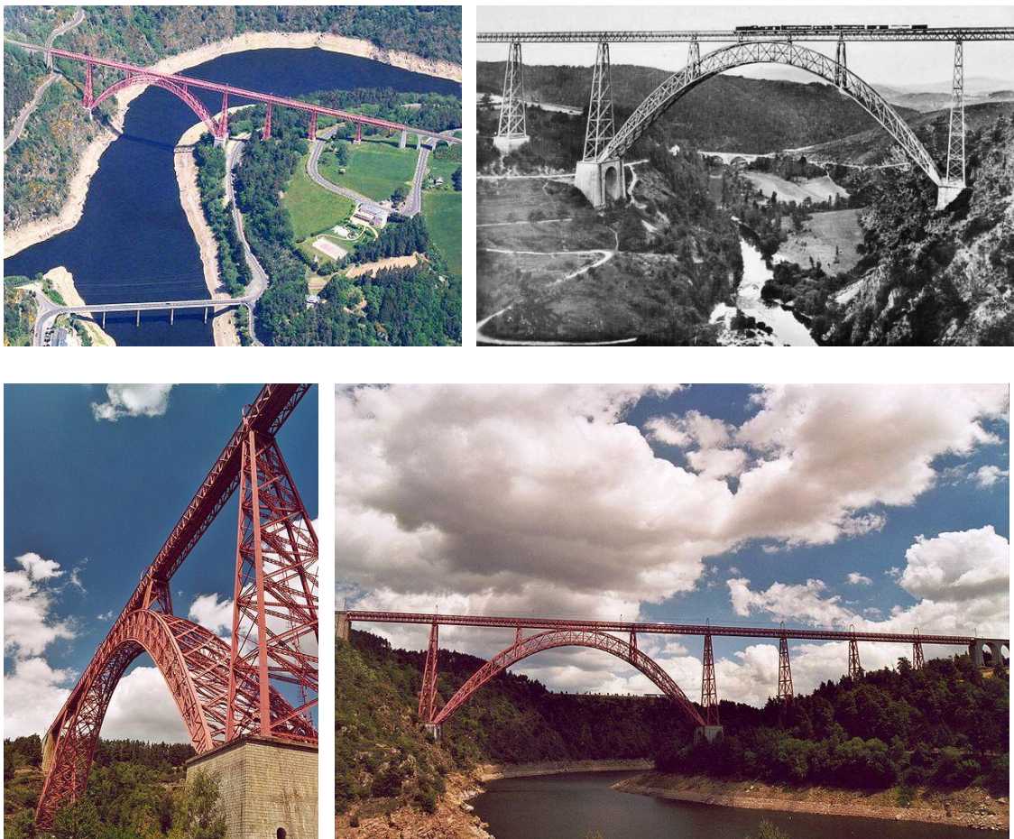
Fig. 6.19. Fotografías actuales y antiguas del Viaducto de Garabit sobre el Truyère. (Graeme Churchard. et al. http://highestbridges.com ).
