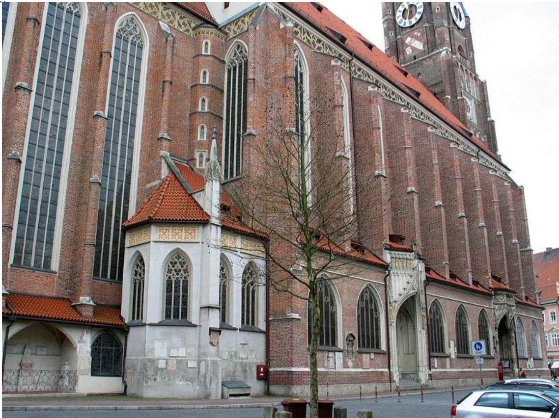
Fig. 3.73. Vista aérea de la iglesia de San Martín de Landshut. Donde se aprecia la enorme altura de la torre así como las proporciones de la cubierta de las naves. Vista lateral con el detalle de los contrafuertes.
