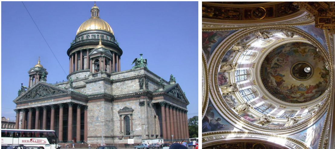
Fig. 3.88. Catedral de san Isaac en San Petersburgo. En ella Lamé y Clapeyron utilizaron polígono de fuerzas y funicular de las cargas para el diseño de la cúpula. El ingeniero español Agustín de Betancourt diseñó el mecanismo para el transporte e izado de las columnas.
