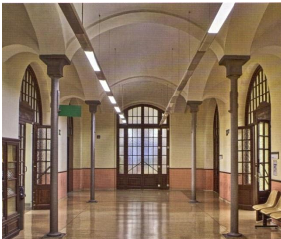
Fig. 6.40. Interiores de la Fábrica de hilados y tejidos de algodón, Batlló Hermanos. Barcelona. Bóvedas tabicadas sobre pilares de fundición. Apoyo mediante vigas de madera intermedias y tirantes metálicos. (Fot. M. Freeman)
