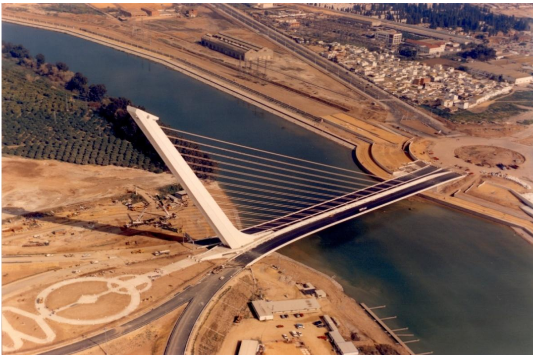
Fig. 6.65. Fotografías, nocturna y a vista de pájaro del Puente del Alamillo de Sevilla, del arquitecto Santiago Calatrava 1992.
