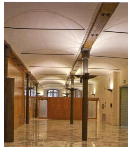
Fig. 6.40. Interiores de la Fábrica de hilados y tejidos de algodón, Batlló Hermanos. Barcelona. Bóvedas tabicadas sobre pilares de fundición. Apoyo mediante vigas de madera intermedias y tirantes metálicos. (Fot. M. Freeman)
