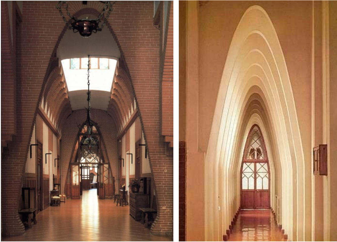
Fig. 6.3. Corredor de la planta baja y pasillo superior del colegio de las Teresianas. Arcos con la forma antifunicular y ménsulas seriadas que aguantan el pasillo del piso superior. (González y Casals, 2002: 58)
