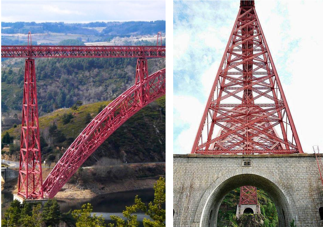
Fig. 6.20. Fotografías de detalle de las pilastras metálicas del Viaducto de Garabit sobre el Truyère. (Graeme Churchard, et al. http://highestbridges.com ).
