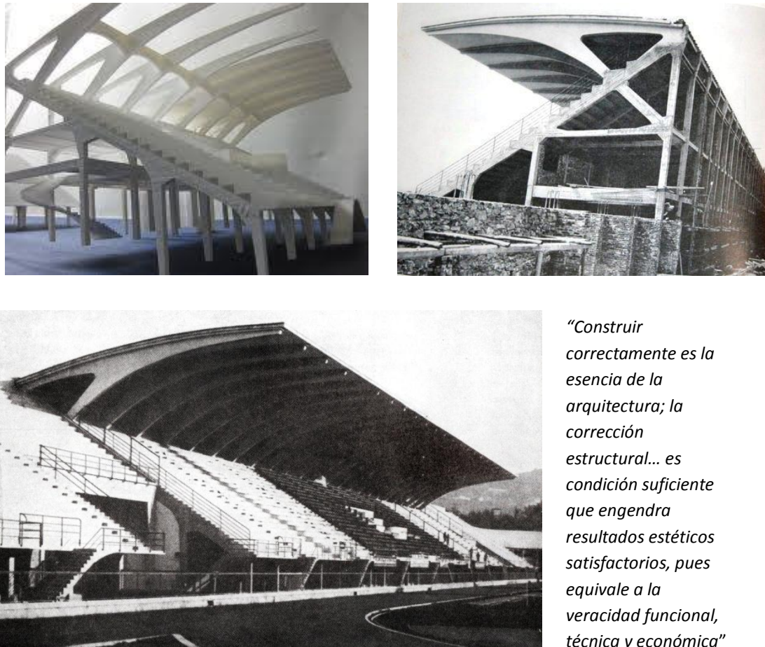
Fig. 6.62. Fotografías de una maqueta y de la realidad en construcción y construida de la grada y la marquesina del Estadio Comunale di Firenze, en las que se muestra la “idea” de la estructura sustentante de la marquesina integrada con la estructura del graderío. La frase es de su libro Costruire correttamente . (Pier Luigi Nervi, Structures . F. W. Dodge Corporation: New York 1956).
