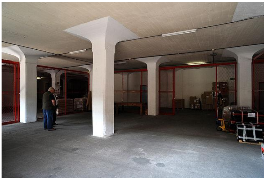
Fig. 6.88. Superposición de de las líneas estructurales del edificio principal de los Almacenes (en segundo plano) y de los pórticos exteriores. Sistema constructivo de losa de hormigón de espesor constante y capiteles fungiformes. (Zastavni, 2008b: 248) (Fot. Ticin)
