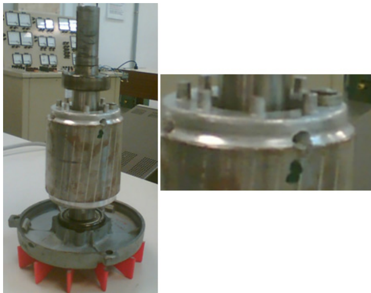
Fig. 7. 1 Izquierda: Rotor de jaula de ardilla con una barra rota. Derecha: detalle de la rotura de barra realizada perforando la barra con un taladro a la altura de la unión con el anillo de cortocircuito.
