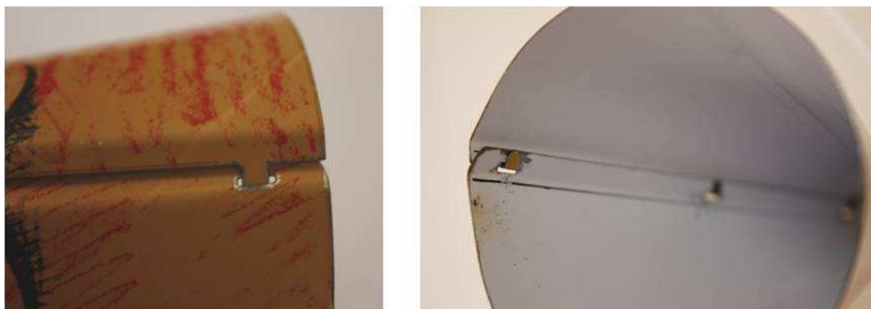
Fig. 4.3.21.- Vista exterior e interior del sistema de enganche “engafat”
