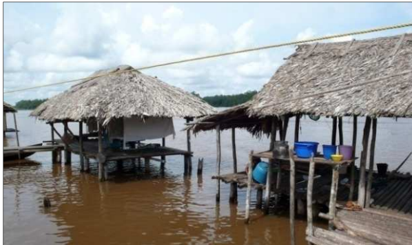
Figura 4: Palafito con ausencia de paredes Fuente: Parfan 2009
