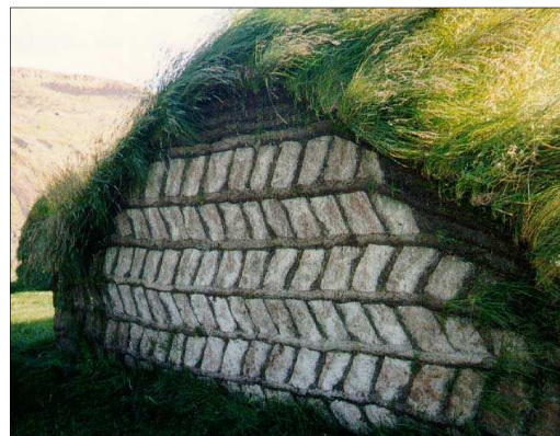
Figura 83: Muro con bloques de turba en "espina de arenque"
