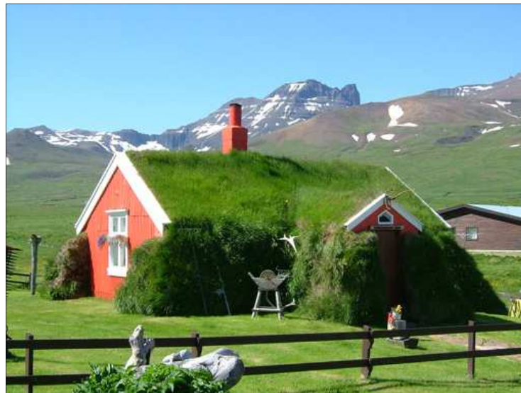
Figura 89: Construcción actual con cubierta y laterales de turba
