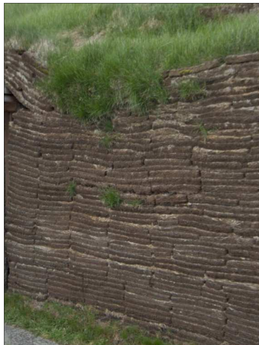
Figura 82: Fachada de turba de una vivienda
