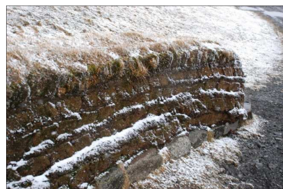
Figura 84: Detalle de arranque de muros de turba sobre base de piedra volcánica
