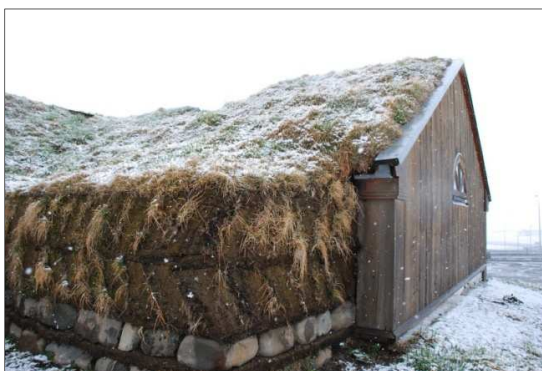
Figura 84: Detalle de arranque de muros de turba sobre base de piedra volcánica
