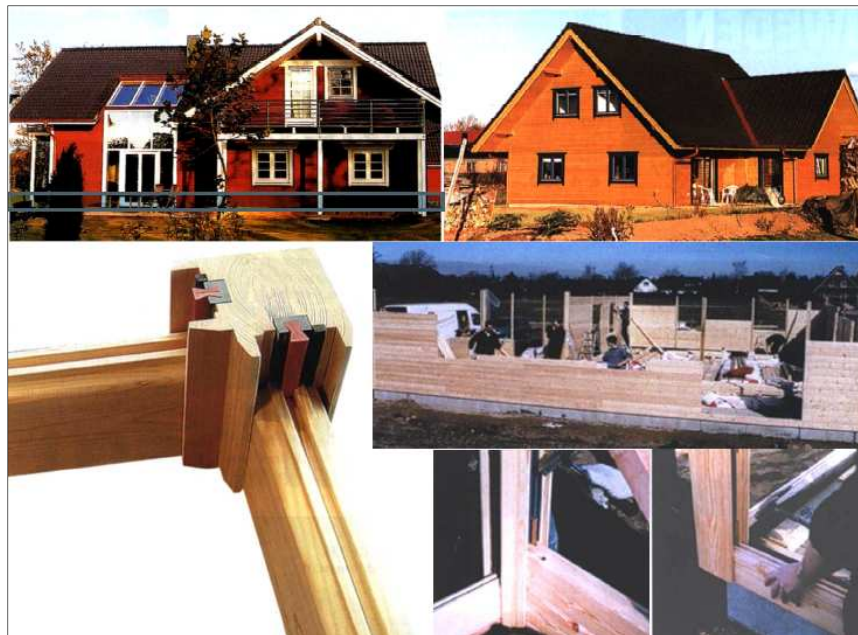
Figura 78: Sistema constructivo de madera laminada en “Bloque” Ensayos de ejecución para las ciudades de Mikkeli y Sodankylä (Finlandia)
