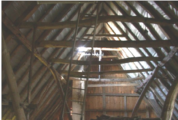
Figura 34: Estructura original de la cubierta
