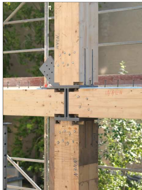
Figura 44: Detalle de nudo viga-pilar Fuente: www.kaden-klingbeil.de
