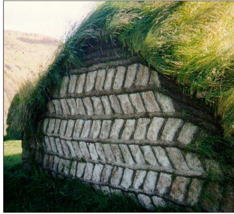
Muro de bloques en "espinas de arenque" Fuente: http://www.skagafjordur.is/displayer.asp?cat_id=1287
