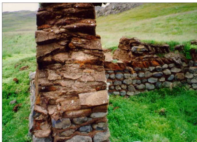
Figura 81: Detalle del espesor de un muro de turba sobre base de piedra
