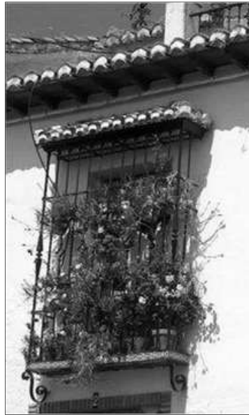
Figura 25: Tejado sobre ventana en vivienda andaluza.
