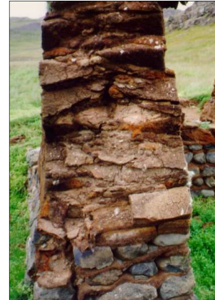
Muro sobre base de piedra
