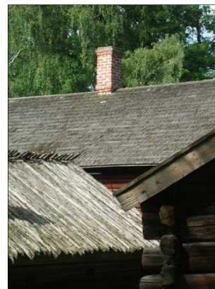
Chimenea de ladrillo sobre tejado de paja
