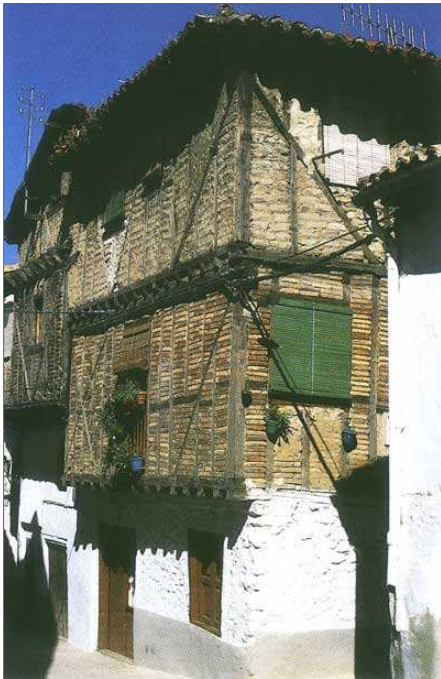
Figura 16: Vivienda con estructura entramada (Hervás)
