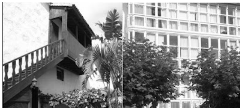
Figura 26: Galerías abiertas y acristaladas.
