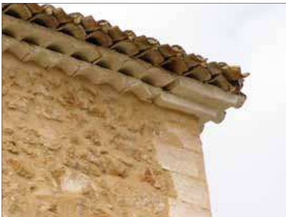
Figura 17: Alero con triple hilada de teja árabe. La Pesquera (Cuenca)
