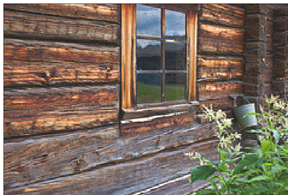
Figura 67: Hueco en fachada (cerramiento con junta horizontal)
