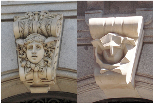
Fig 3.2- Imagen de un ornamento original del Banco de España en Madrid (izquierda) y de una reinterpretación (de Rafael Moneo) esculpida en piedra con tecnología de control numérico a partir de diseños CAD tridimensionales.
