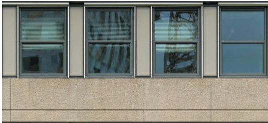
Fig 3.23- El mapeado se basa en imágenes frontales con los bordes corregidos para que no se marquen los solapamientos.
