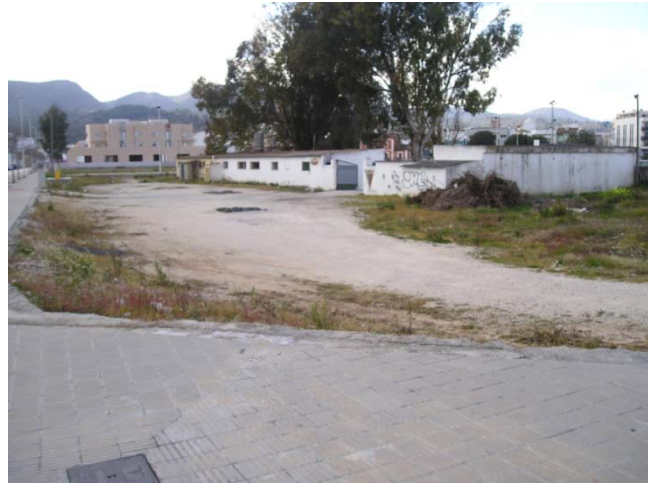
Foto de l'estat actual en que es troba el terreny en la zona d'aparcament
