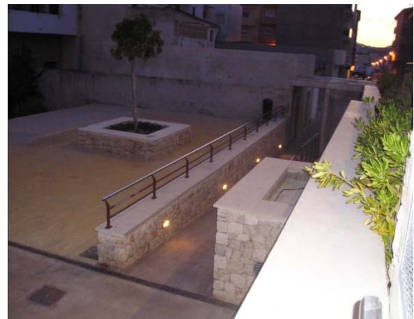
Foto del parc de Teulada on s'observa el mur de mamposteria amb focus encastrats en l'interior
