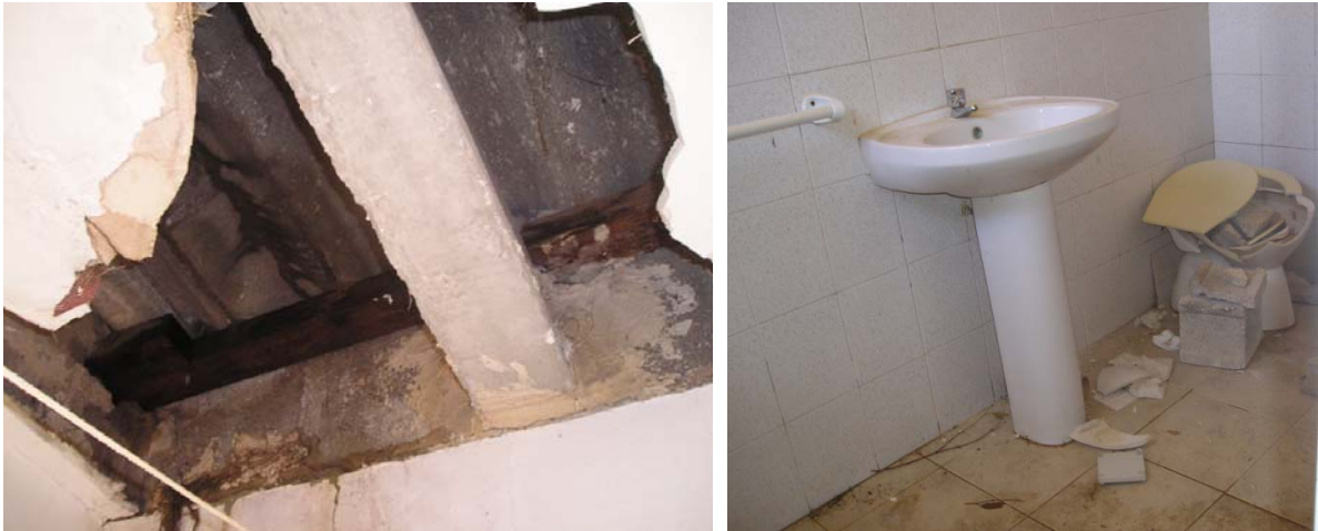
Fotos on es comprova el mal estat en que es troba l'interior de l'edificació, amb els aparells sanitaris i el fals sostre trencats
