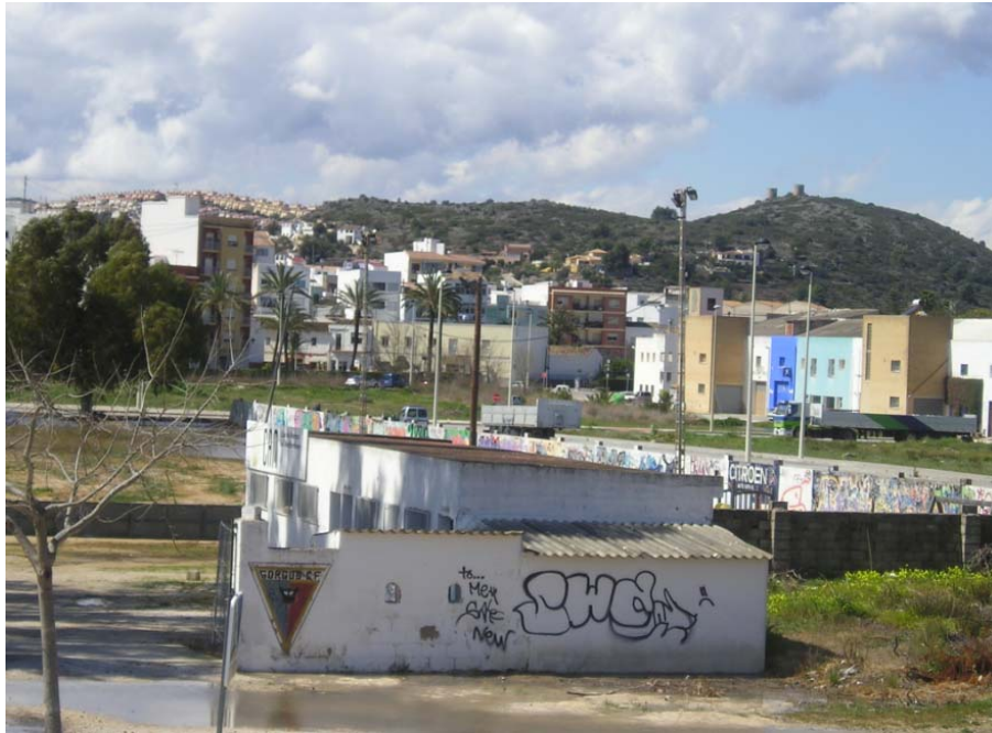
Vista de l'edifici B
