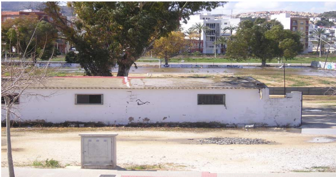
Foto de l'altra edificació a intervindrà on es pot observar el sostre d'uralita del que estàvem fent referència. Ja es pot observar amb claredat les dimensions del terreny a intervindre, i s'observa en la part baixa de la foto la vorera del carrer que passa per ací amb una caixa de subministrament de llum.
