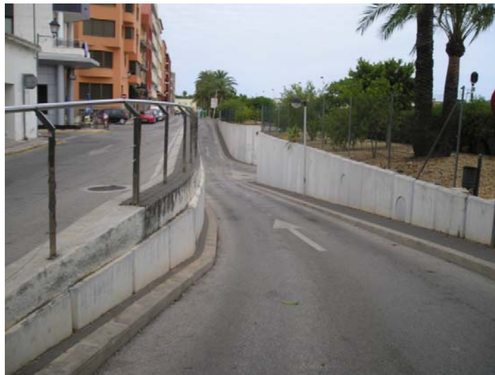
En la foto s'observa el pas subterrani que es fa per poder passar per baix de les vies i no tindre que travessar-les.
