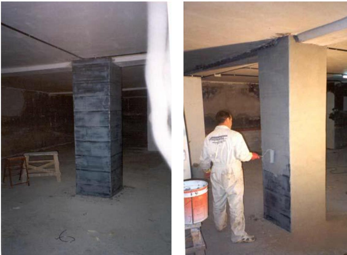
Figura 6.21 Espolvoreado de arena de cuarzo y revestimiento del refuerzo
