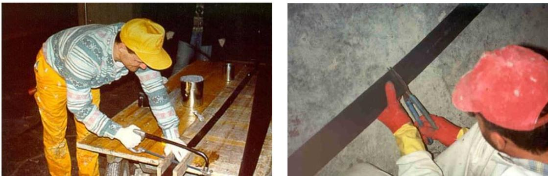
Figura 6.1 Corte del laminado, con sierra y tijeras especiales
