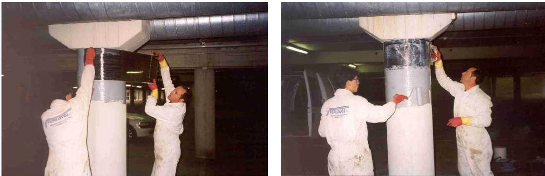
Figura 6.20 Colocación del tejido y su impregnación en la resina
