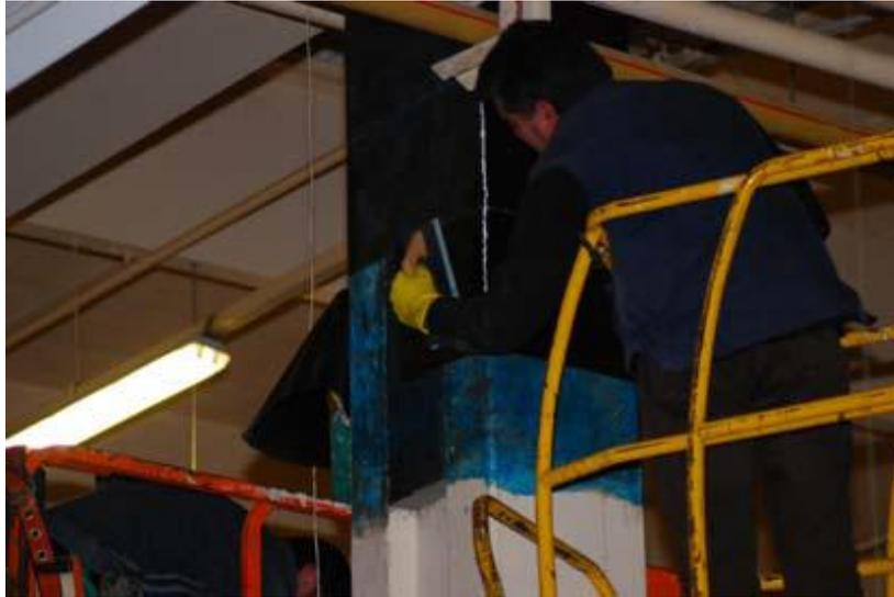
Figuras 2.20 Imágenes de refuerzo por Confinamiento mediante Tejido de CFRP
