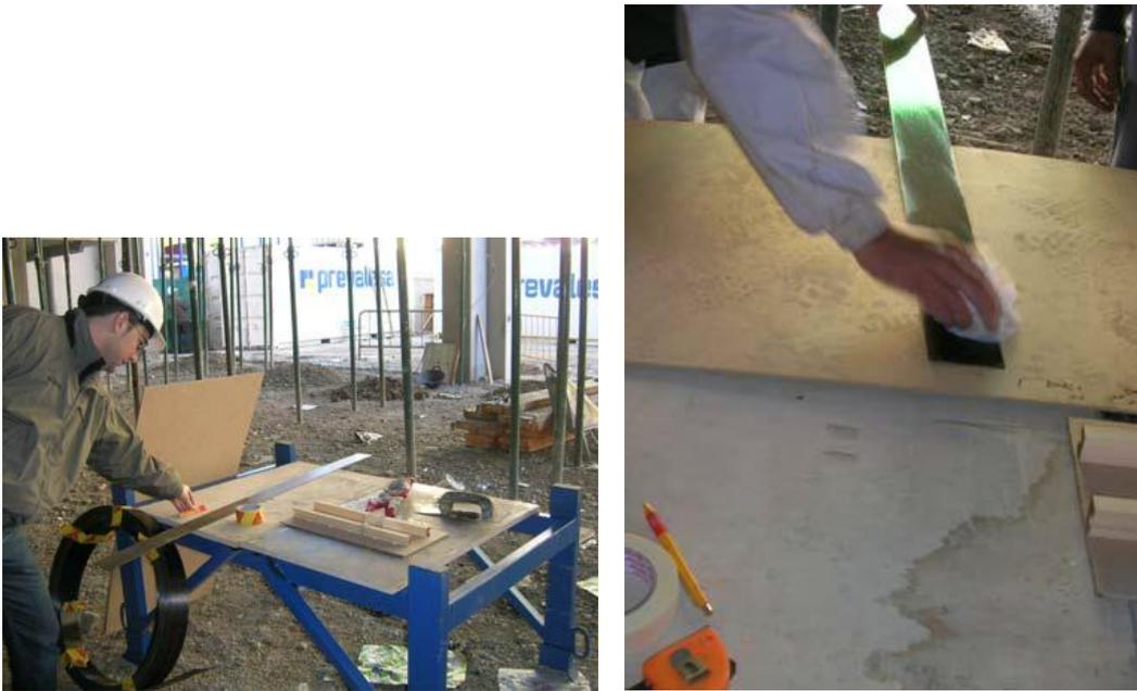
Figura 6.4 Colocación del laminado en la mesa de trabajo y limpieza con disolvente
