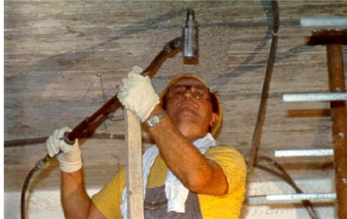
Figura 6.17 Preparación de la superficie mediante abujardado mecánico
