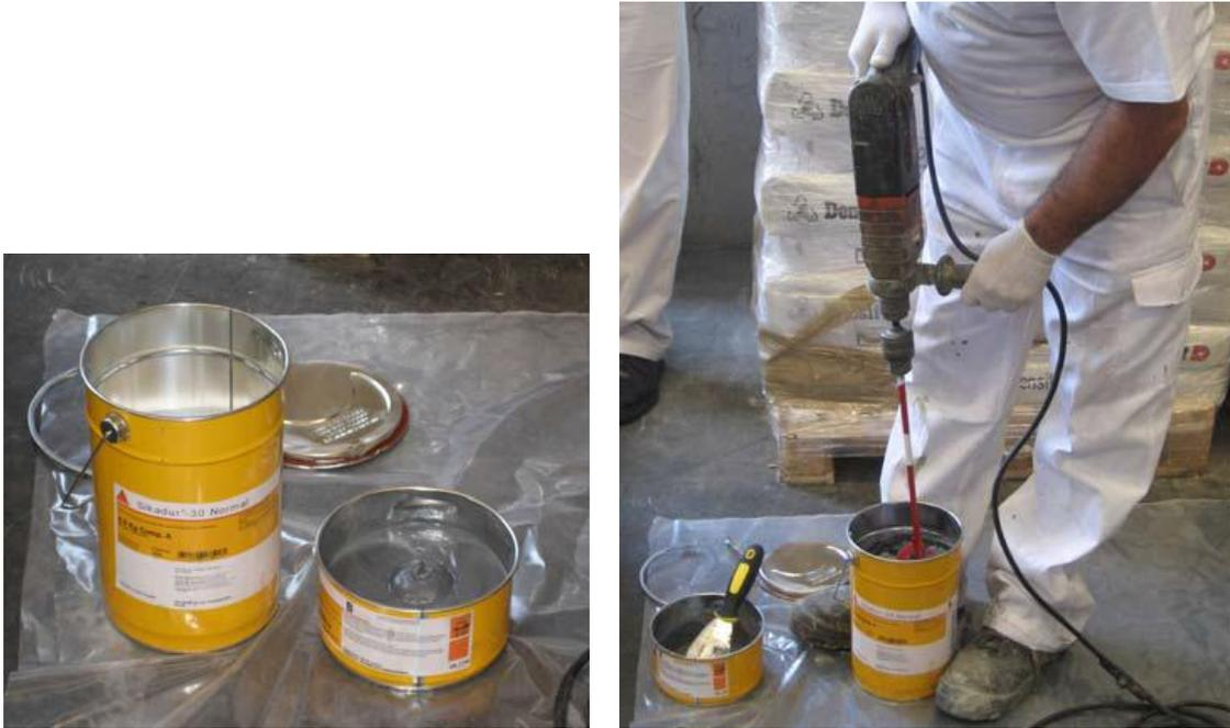
Figura 6.3 Presentación resina epoxi y mezcla de los dos componentes
