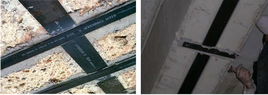
Figura 6.8 Cruce de laminados en forjado y viga
