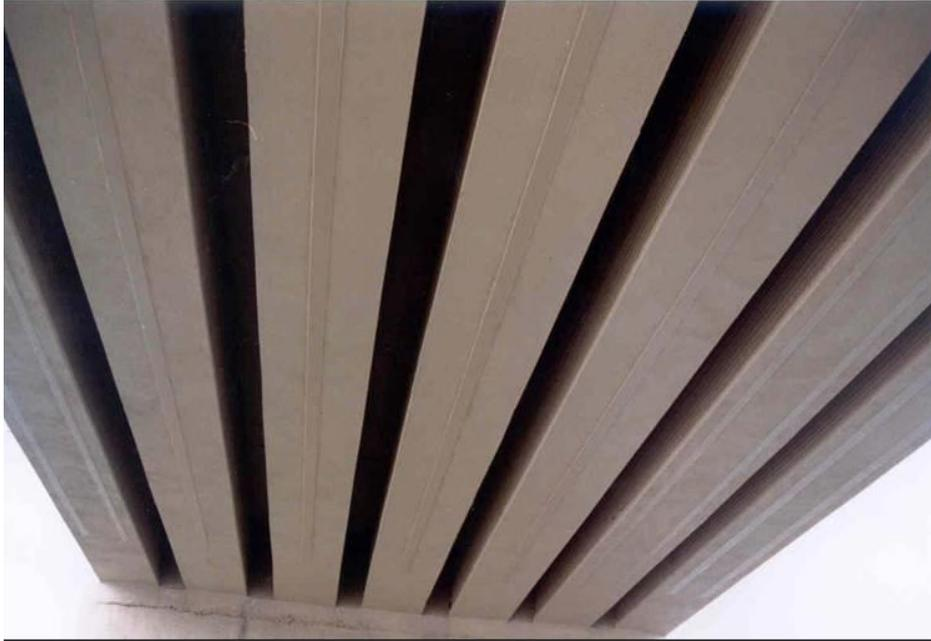
Figura 6.9 Detalle del recubrimiento de los laminados con pintura
