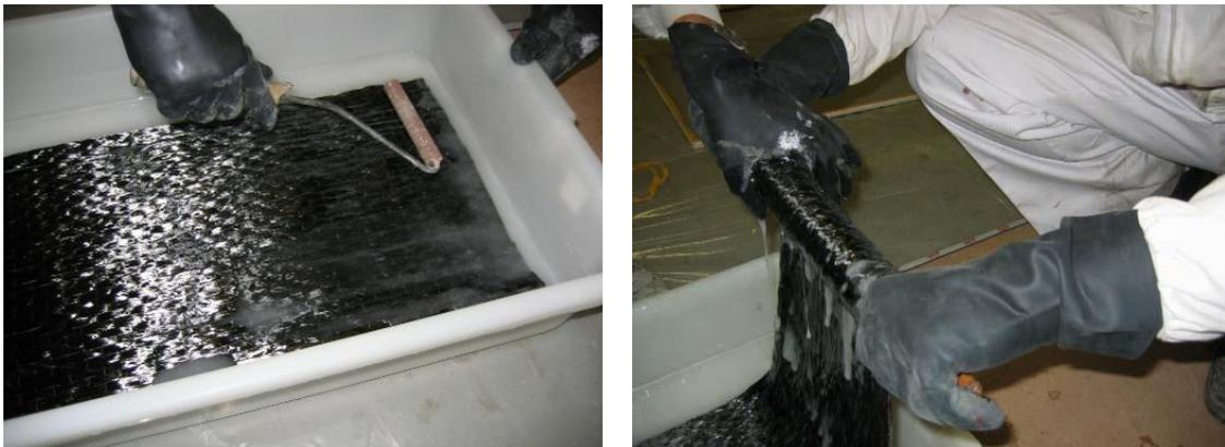
Figura 6.22 Impregnación del tejido en resina y enrollado en los listones de madera
