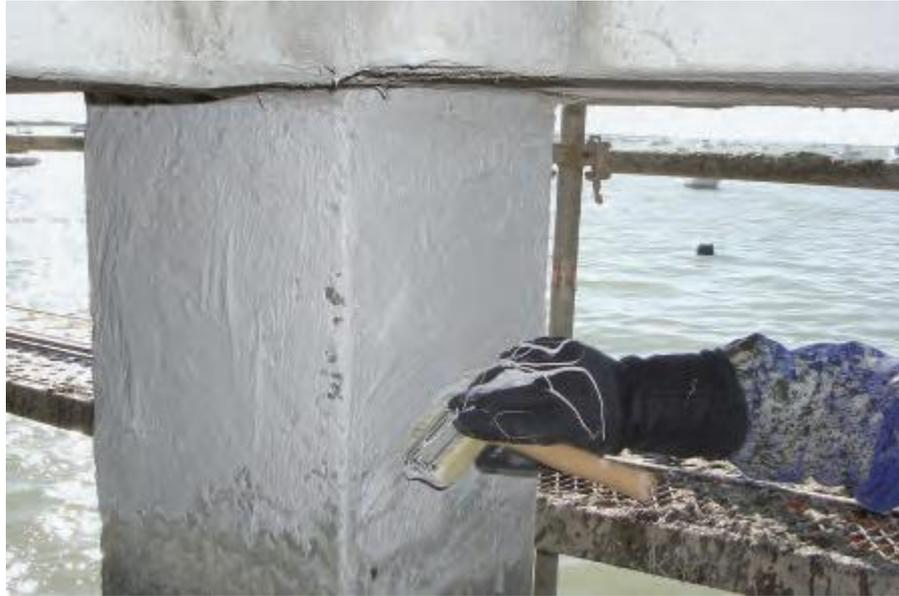
Figuras 2.14 Homogeneización de resina bicomponente y aplicación en soporte
