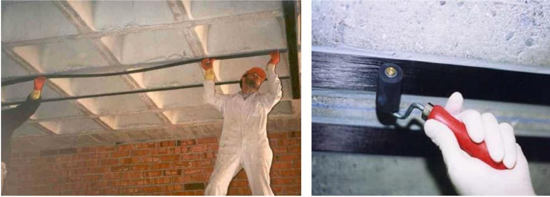
Figura 6.7 Colocación del laminado sobre soporte y presionando con uso de rodillo
