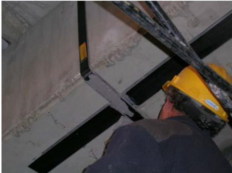
Fig. 6.16 Detalle de la aplicación de resina epoxi sobre el primer angular colocado
