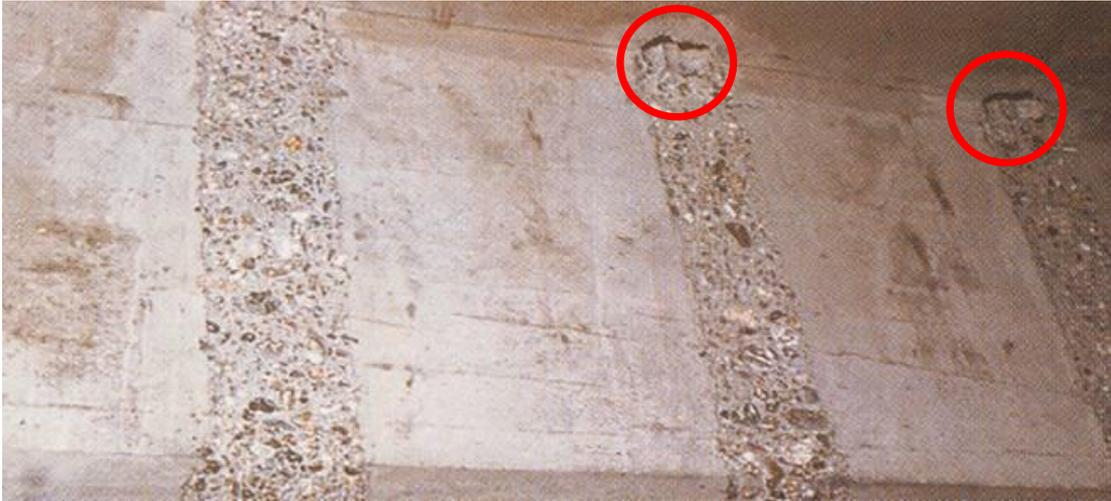
Fig. 6.10 Detalle de las zonas ya preparadas para los angulares y los agujeros para anclaje
