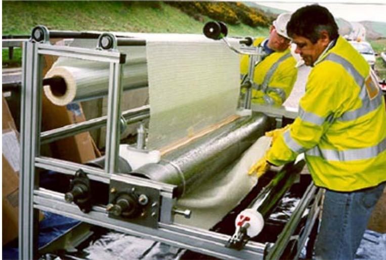
Figura 6.23 Impregnación del tejido mediante el saturador
