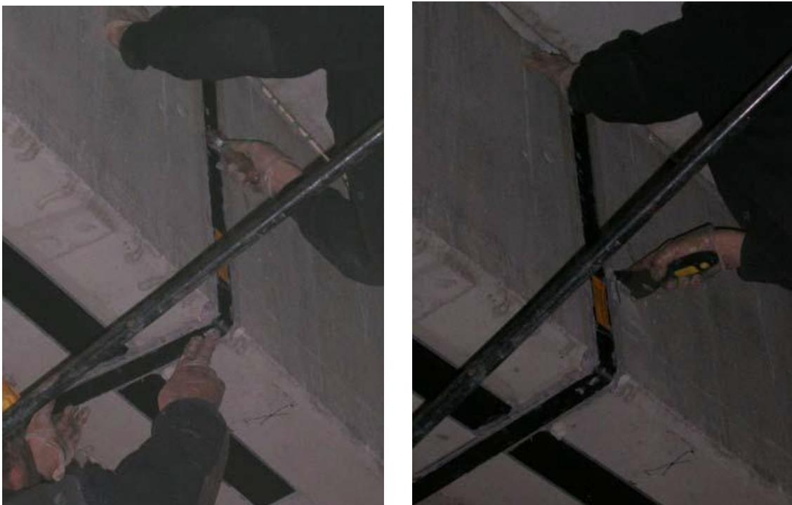
Fig. 6.15 Presión con el rodillo sobre el angular y posterior retirada del sobrante de resina
