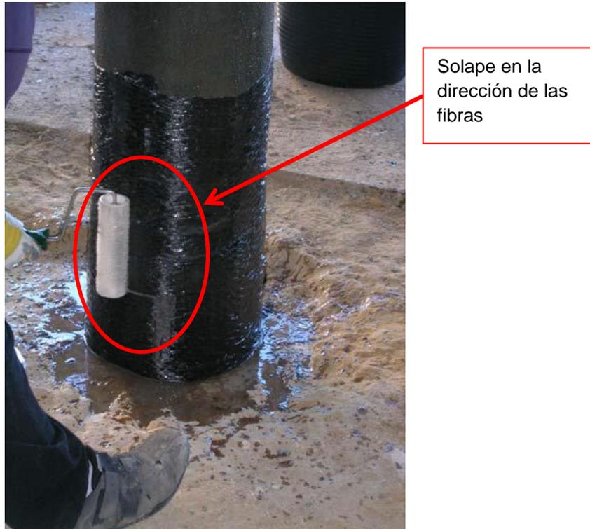
Figura 6.19 Detalle del solape en la dirección de las fibras
