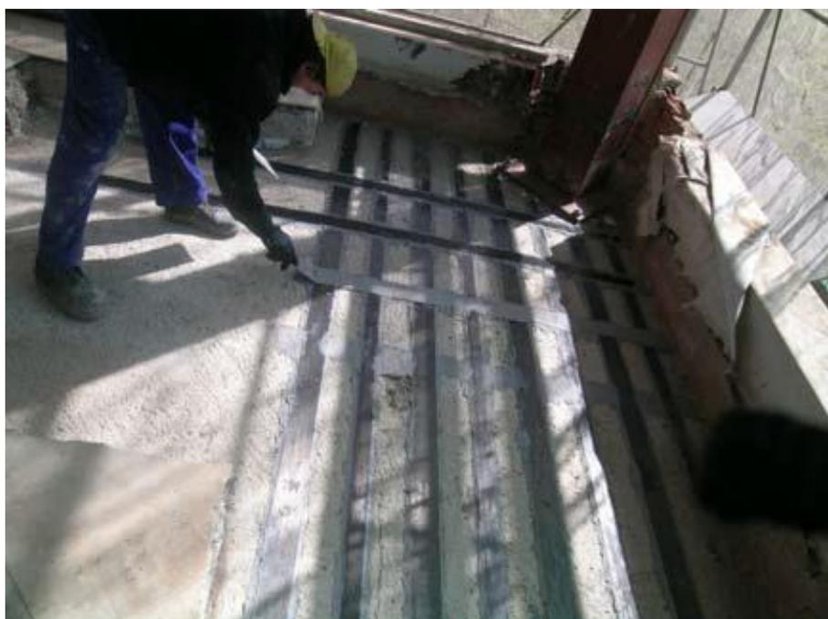
Figuras 2.17 Imágenes de refuerzo a Flexión mediante Laminados CFRP
