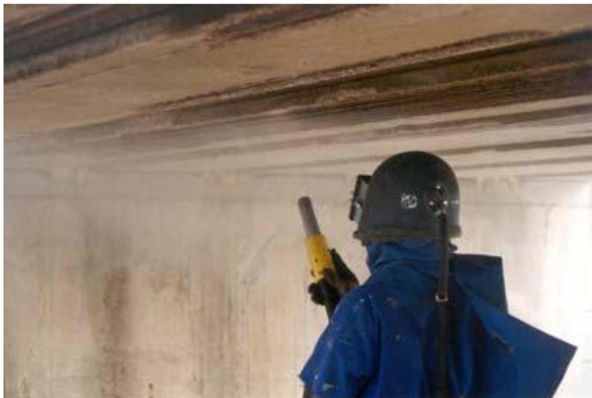
Figura 6.2 Preparación de la superficie mediante chorro de arena
