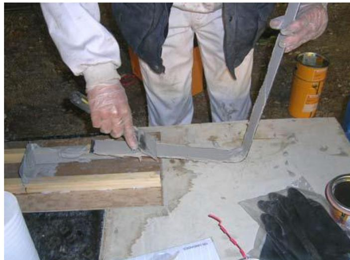
Fig. 6.13 Aplicación de resina en el angular
