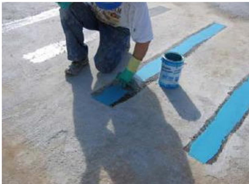
Figura 6.5 Colocación del adhesivo epoxi sobre la superficie
