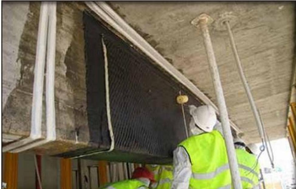
Figuras 2.18 Imágenes de refuerzo a Cortante mediante Laminado y Tejido de CFRP
