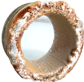
Fig. 1.27.- Tubería de amianto cemento (fibrocemento) DN-125.
