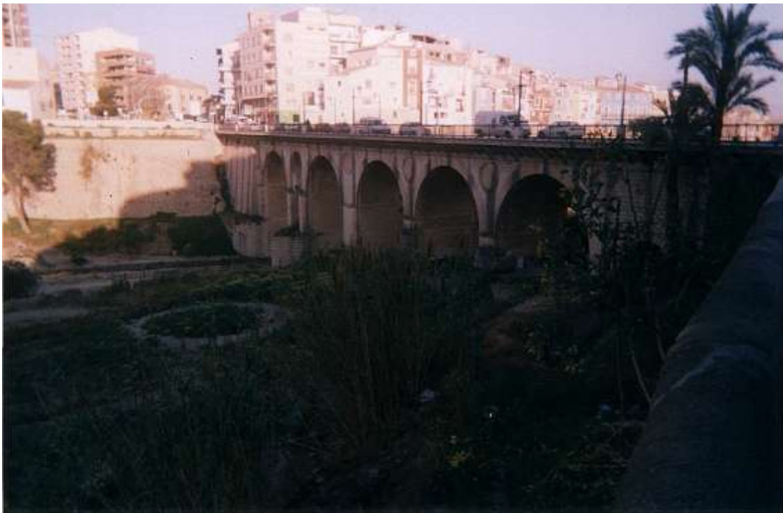
Fotografía 11 Puente de carretera CN-332- PK aproximado 4842 m.
