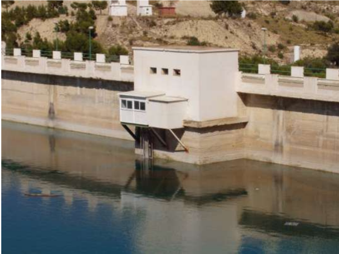
Fotografía 5. Caseta de control
