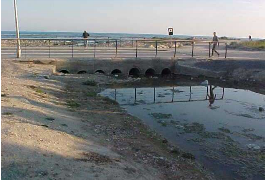
Fotografía 12 Paso final sobre el río Amadorio – PK aproximado 5070 m.
