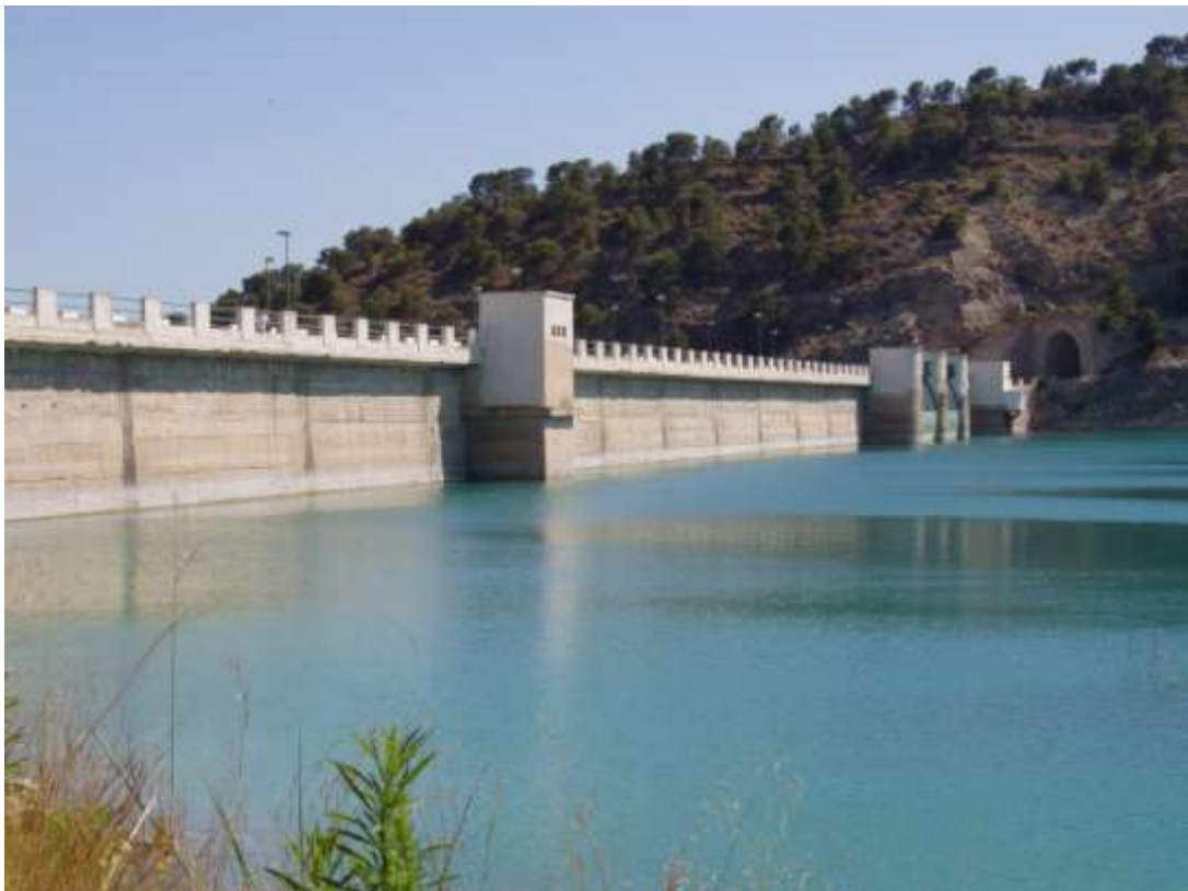
Fotografía 2. Vista general de la presa aguas arriba (II)
