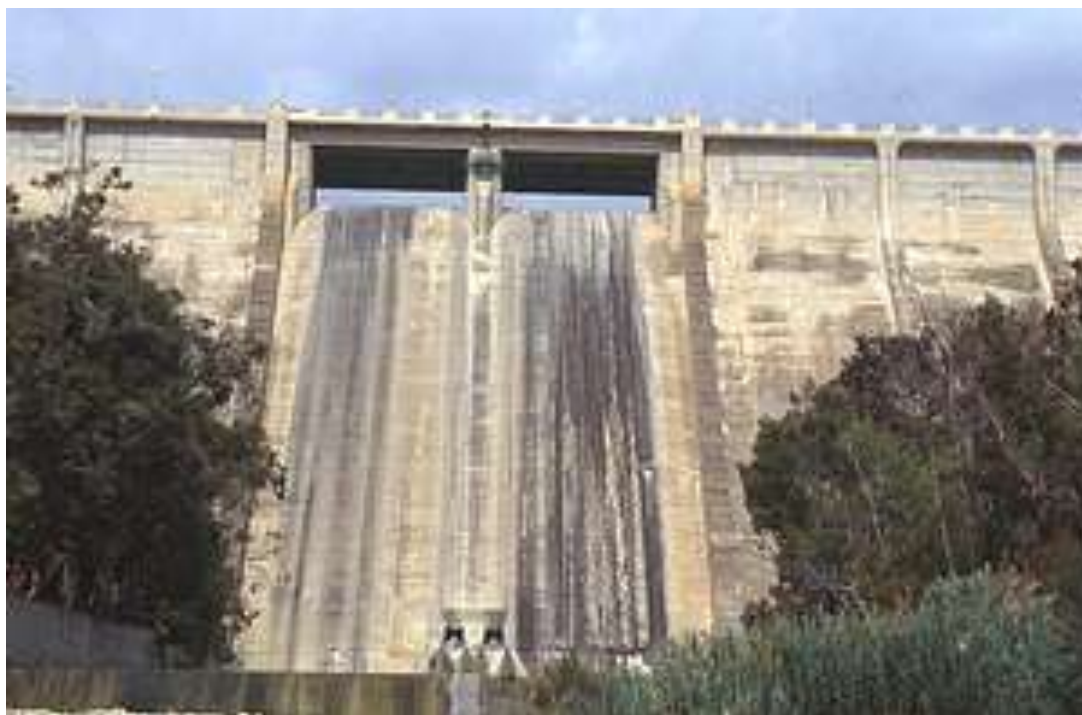
Fotografía 3. Vista general de la presa aguas abajo
