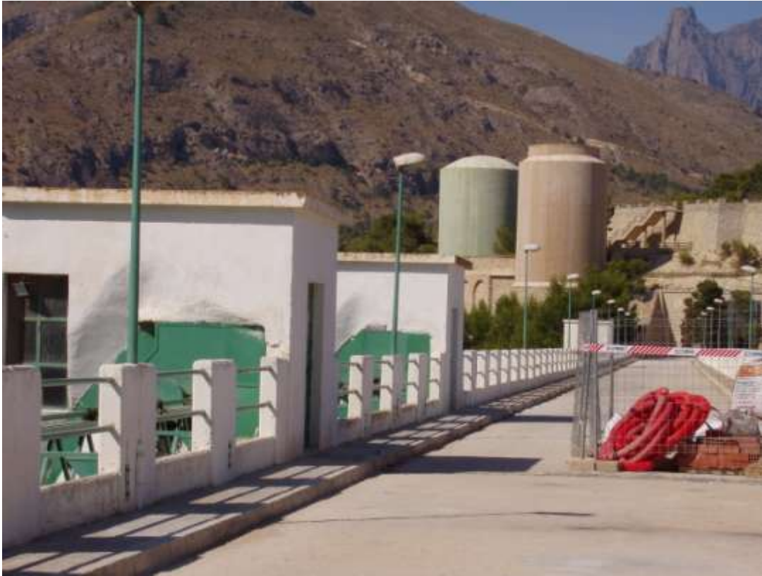
Fotografía 7. Carretera de coronación de la presa
