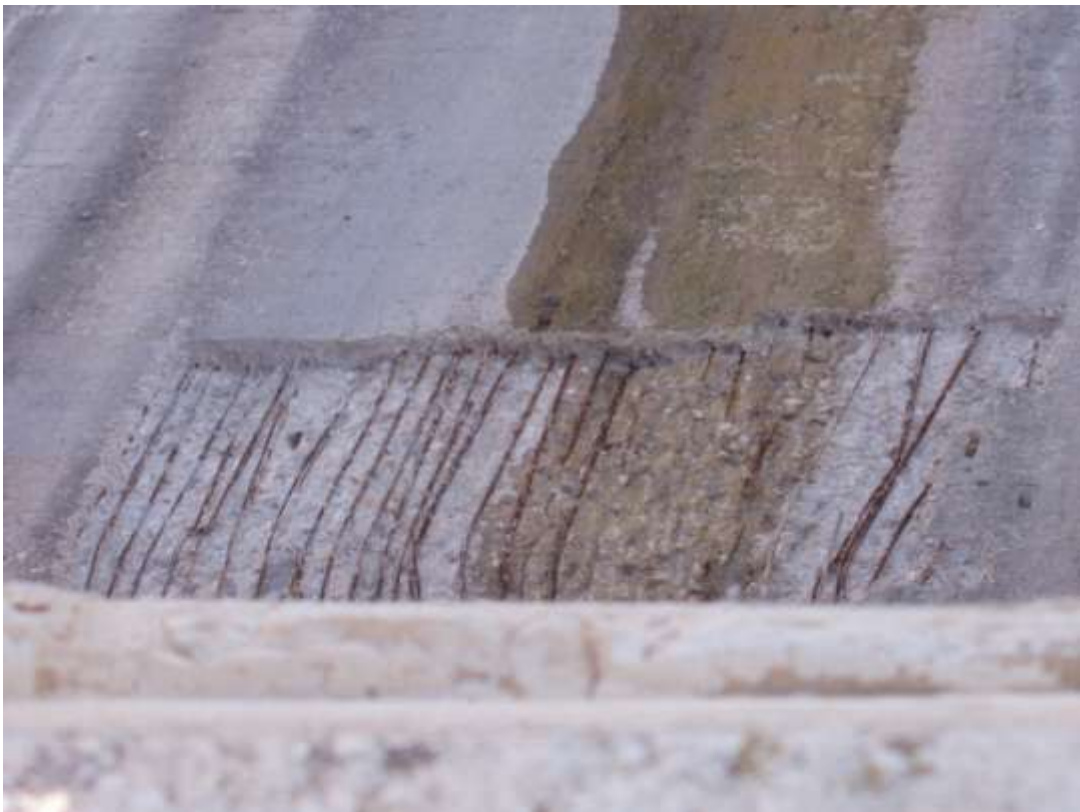
Fotografía 8. Detalle del estado del hormigón en la rápida de la presa
