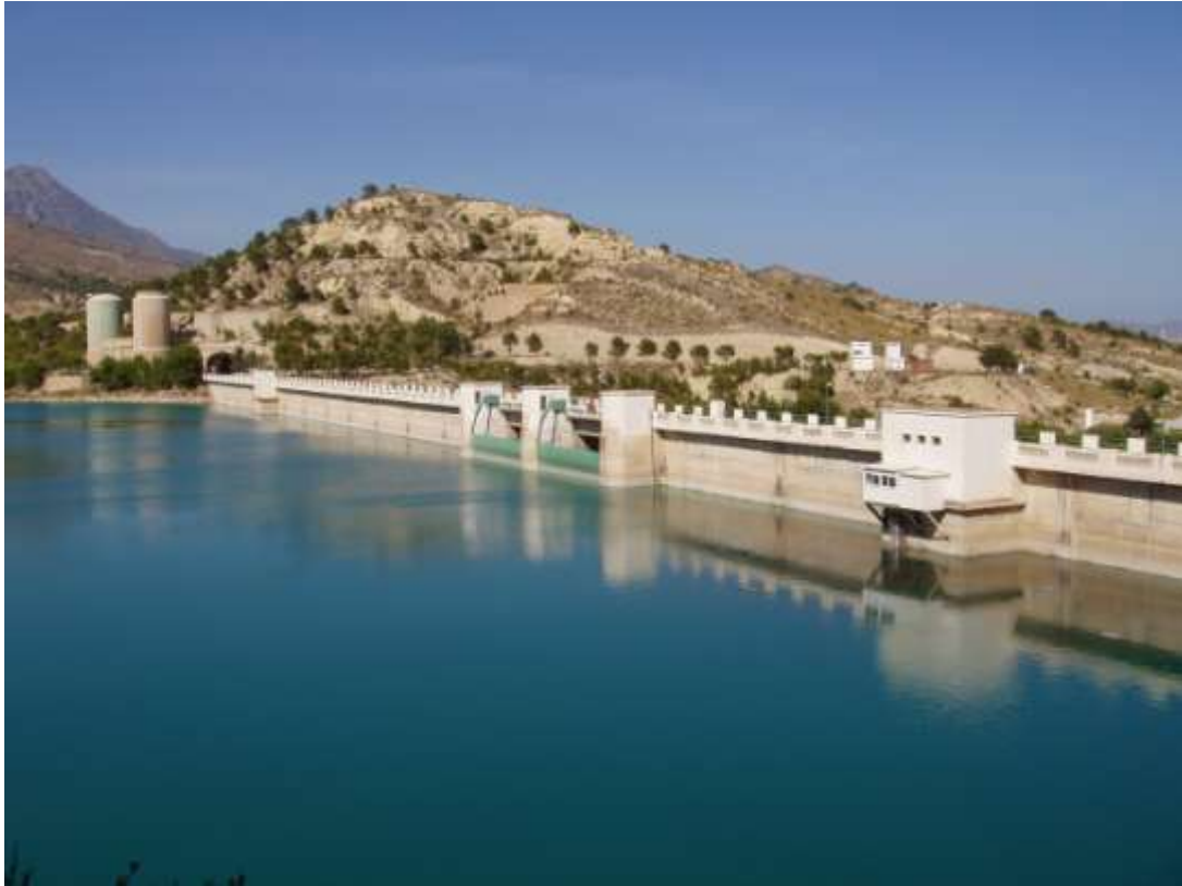
Fotografía 1. Vista general de la presa aguas arriba (I)
