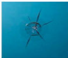
Imagen 2.4: Impacto ojo de buey con microfisuras
