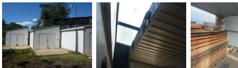
Figura 8: Secaderos solares con ventilación forzada
