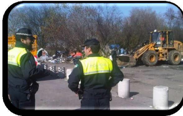
Ilustración 4 Policía Local junto empresa obras en calzada.
