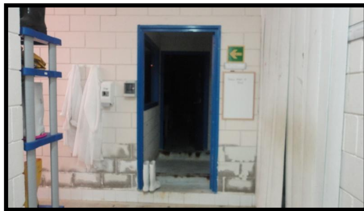
Figura 30. Entrada a la sala de patologías, se observa el pediluvio de obra que debe superarse para entrar.
