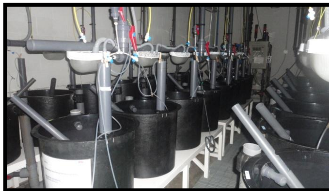
Figura 8. Módulo 14, destinado a la incubación de huevos de peces.
