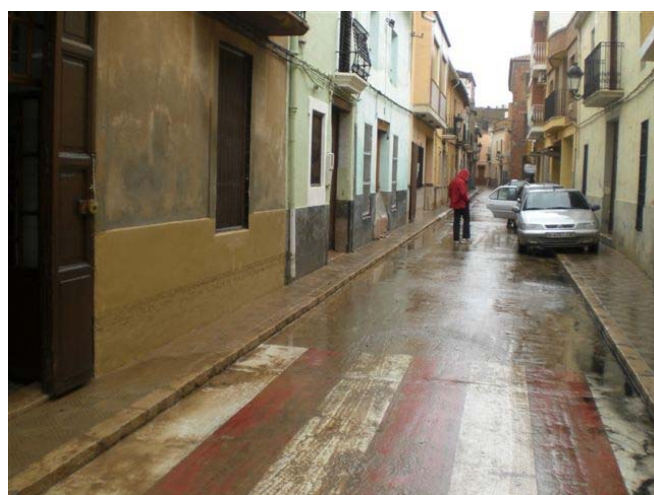
Figura 8.2. Calle Pilota, Benaguasil, tras las lluvias ocurridas el 12 de octubre de 2008. Fuente: Policía Local de Benaguasil.
