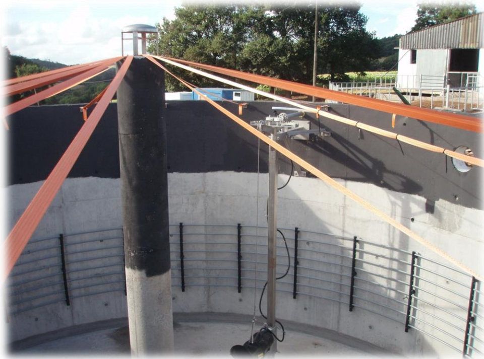
Figura 16. Digestor en construcción de la explotación.
