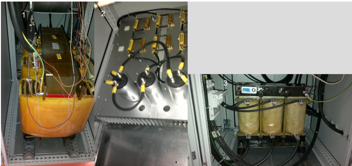
Figura 108: Componentes del filtro LCL
