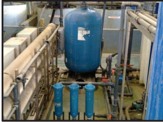
Figura 17: Filtro de sílex-antracita (parte posterior) y filtros 300 micras (parte anterior)
