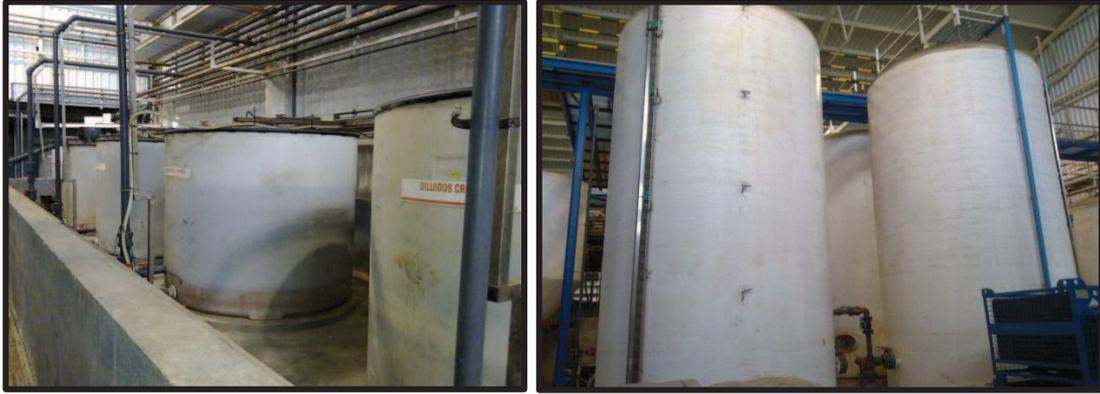
Figura 11. Depósitos pulmón de 5 m<sup>3</sup> y 40 m<sup>3</sup>
