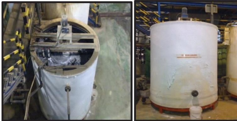
Figura 12. Depósito de oxidación de cianuros
