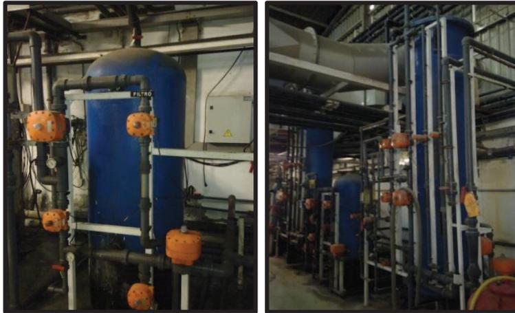
Figura 21. Filtro Carbón activo (izquierda) y desmineralizador (derecha)
