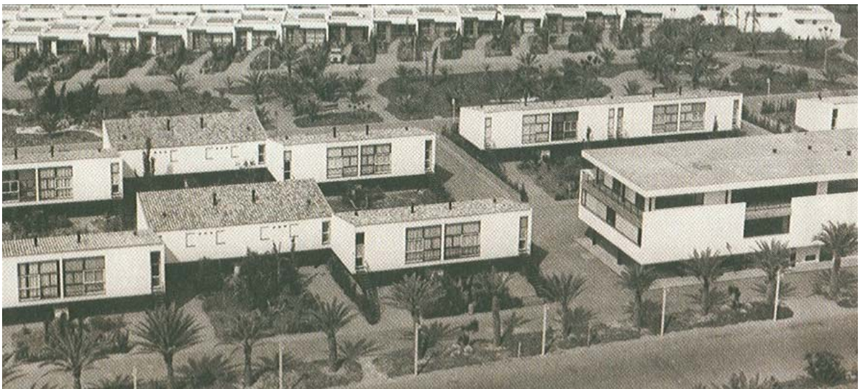
Fig 5.22 Apartamentos Malaret (1965). Fuente: Roig i Sala (1999)
