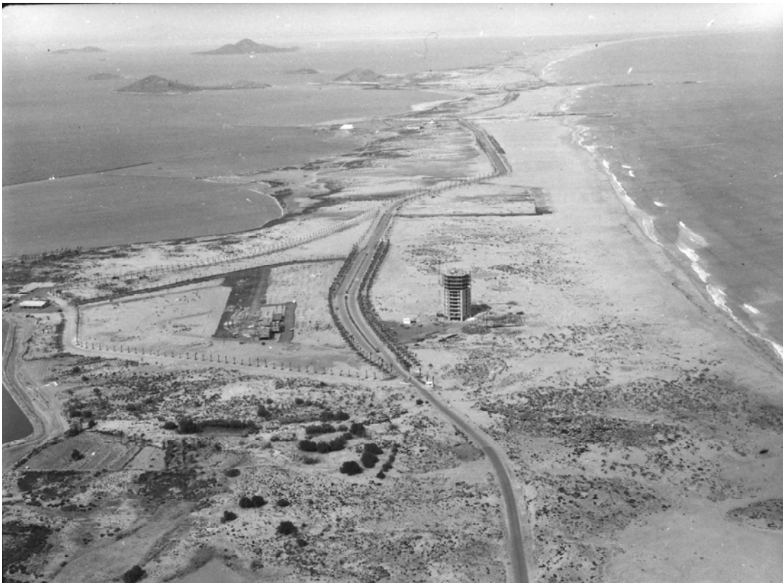
Fig 4.17 Inicio de las obras en La Manga a finales de 1963 previo a la declaración de centro de interés turístico. Proceso inicial de urbanización (arriba) y estado de las obras en 1964 (abajo).
