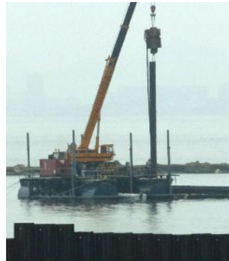
Fig. 8.59 Dragado de Puerto Mayor. Fuente: Diario La Verdad (2005).
