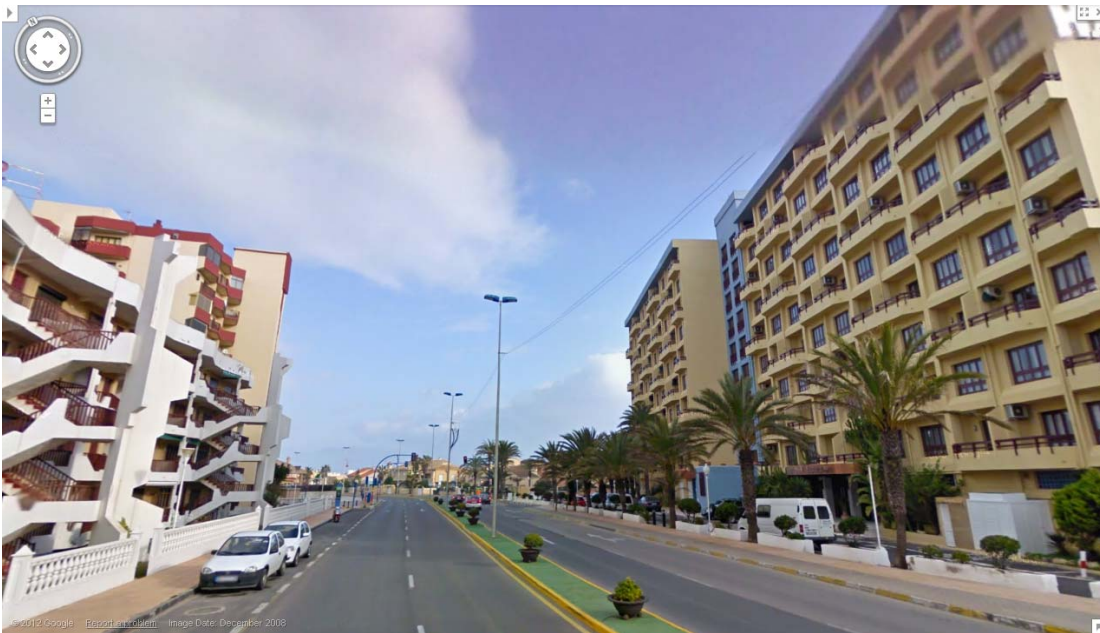
Fig. 8.39 Situación en el viario central de las pantallas de hormigón que configuran los edificios. Fuente: Google maps.
