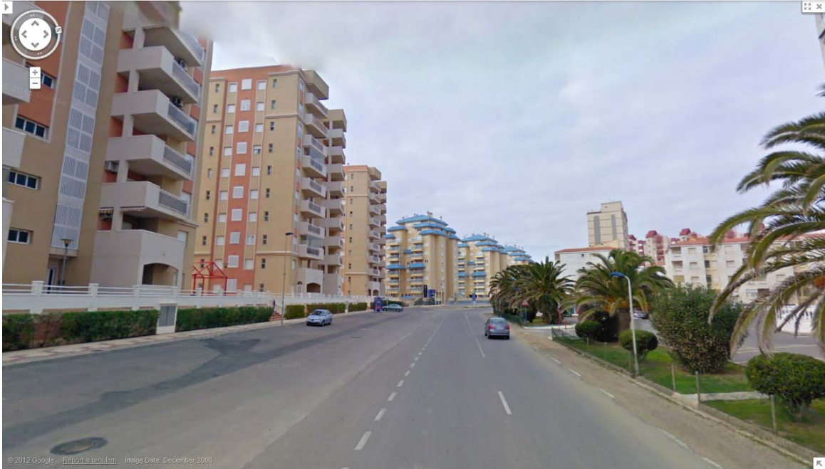
Fig. 8.50 Edificios del entorno del Estacio, construidos entre 1995 y 2007 y hoy deshabitados en su mayoría. Fuente: Google maps.
