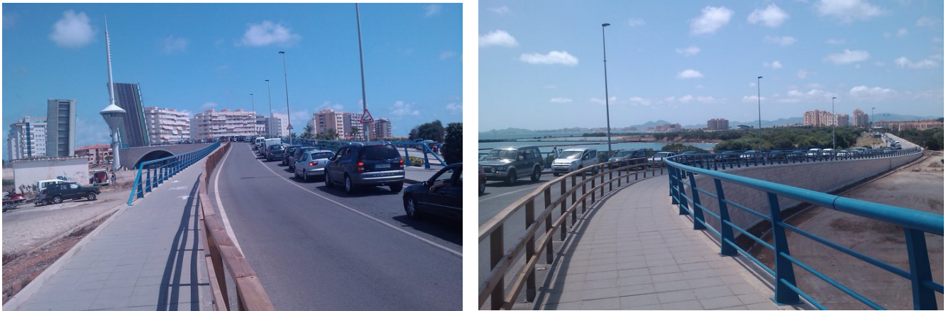
Fig. 8.69 Situación de colapso actual causado por la masificación conjugada con una infraestructura débil como el puente levadizo del canal del Estacio. Fuente: propia.
