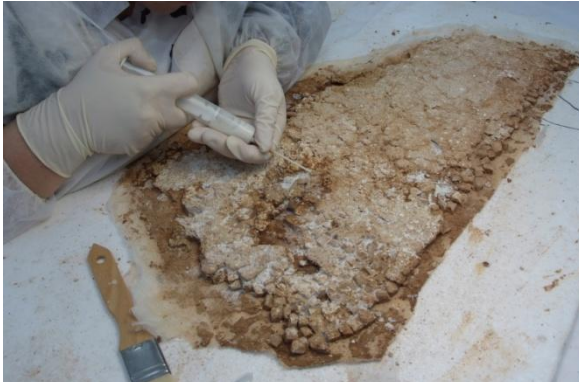
Inyección de mortero en las grietas.
