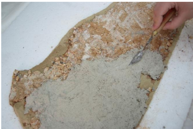
Aplicación del estrato de intervención.
