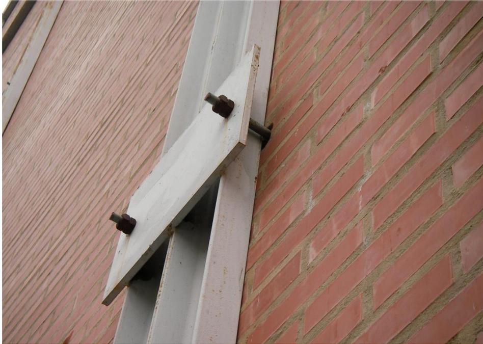
Foto A.54. Detalle del anclaje a la estructura portante.
