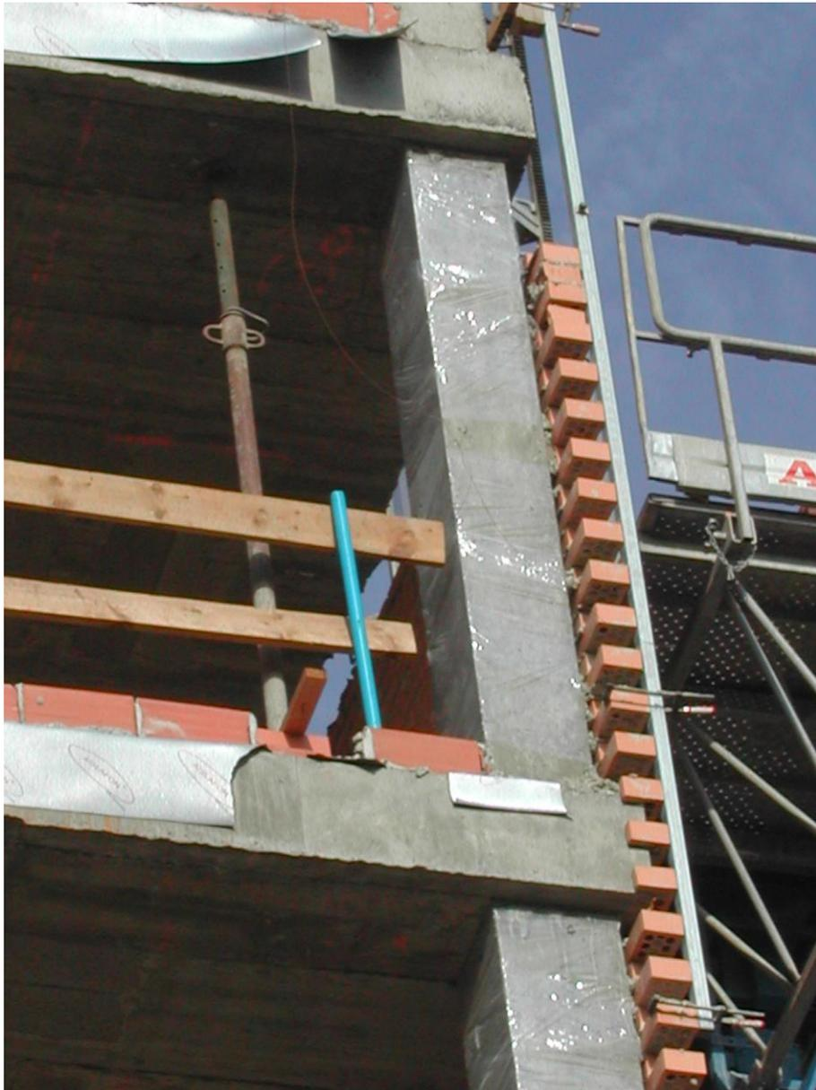
Foto A.13. Pilar retranqueado respecto del forjado para el apoyo del cerramiento.
