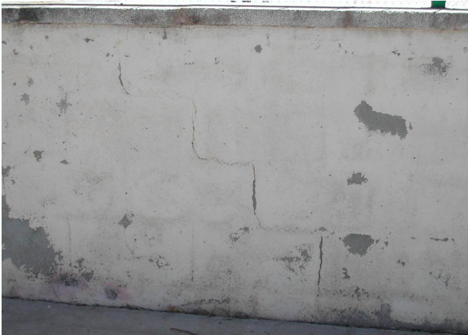
Foto A.36. Fallo en la trabazón, los ladrillos no llegan a fisurarse.
