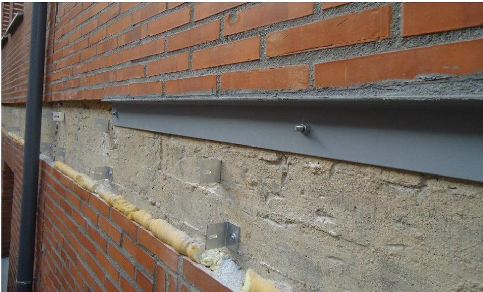
Foto A.50. Eliminación de plaquetas, colocación perfil discontinuo y forrado con paneles (ITE Asturias, 2012).
