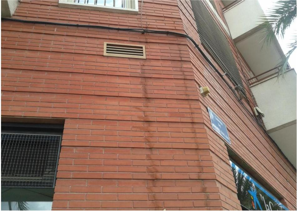
Foto A.14. Fisuras en el entorno del pilar de esquina
