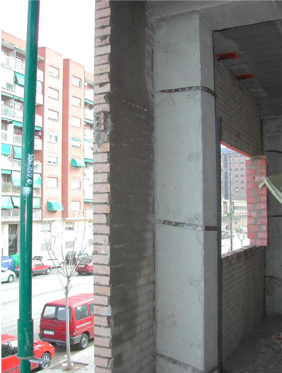
Foto A.19. Cerramiento con piezas de menor espesor forrando el pilar. Se dispone una armadura que garantiza la estabilidad de estas piezas.
