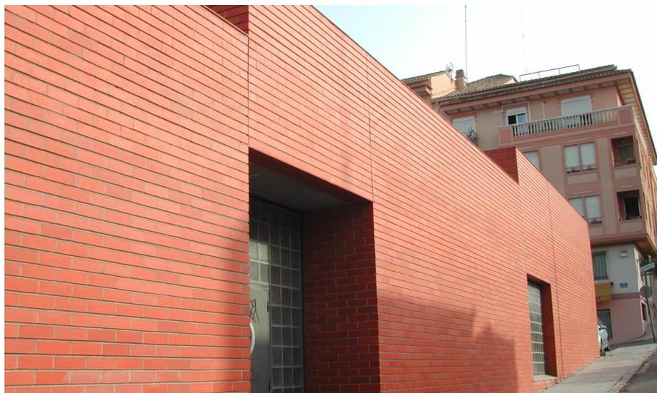
Foto A.31. Junta de deformaciones en la parte superior del hueco
