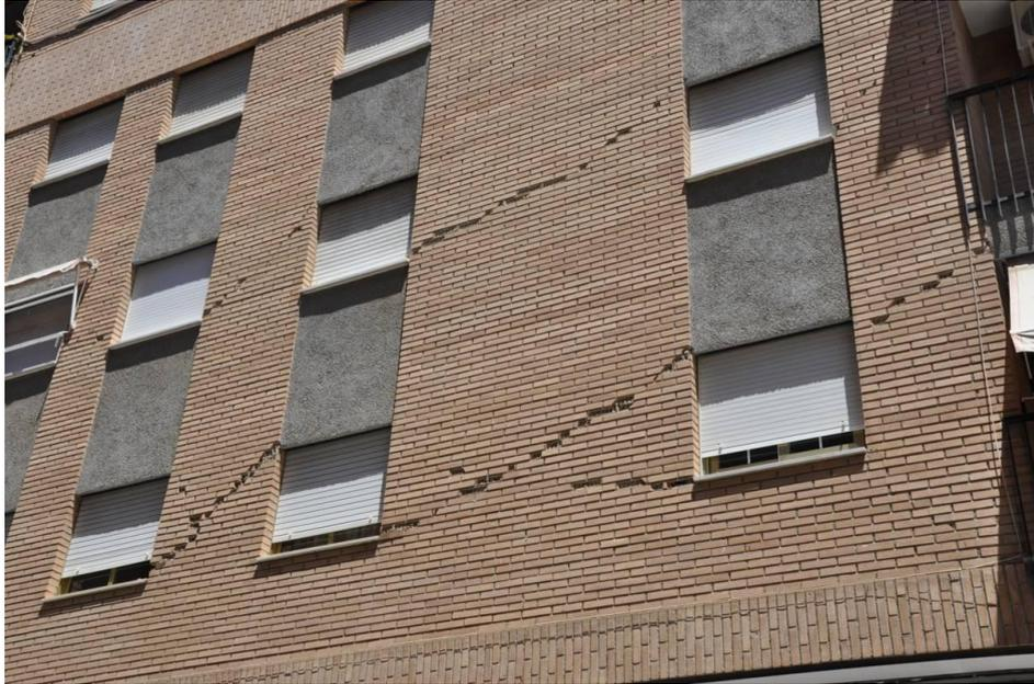
Foto A.16. Estado de cerramiento de ladrillo tras el terremoto de Lorca de 2011 (Lerma, 2011)
