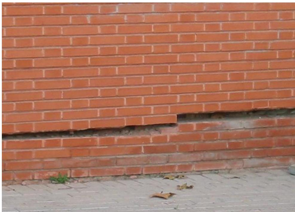
Foto A.6 Fisura provocada por el descenso de la cimentación. Detalle.
