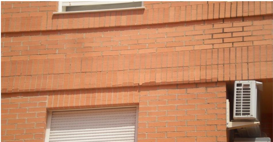
Foto 4.1. Fisuración en frente de forjado.
