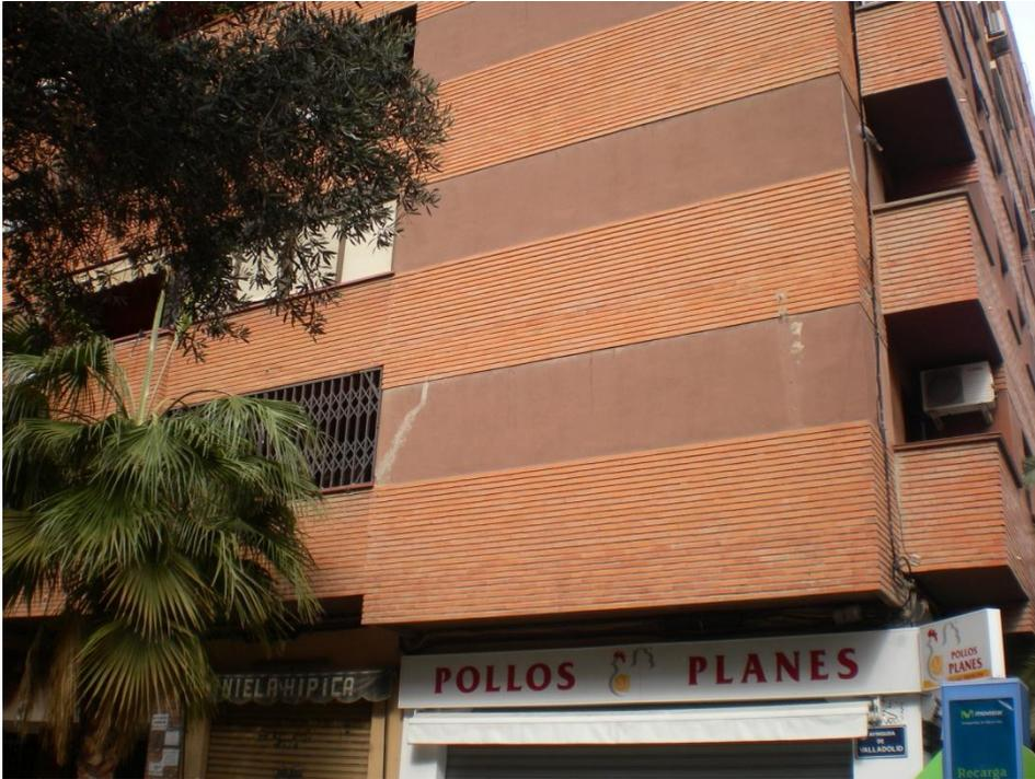
Foto A.1. Fisuras en cerramiento por incompatibilidad de deformaciones.
