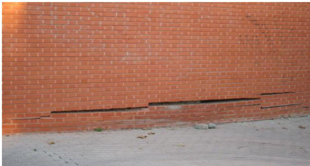
Foto A.5 Fisura provocada por el descenso de la cimentación.
