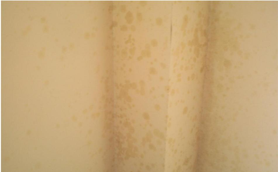
Foto 1.14. Humedades por falta de aislamiento térmico.
