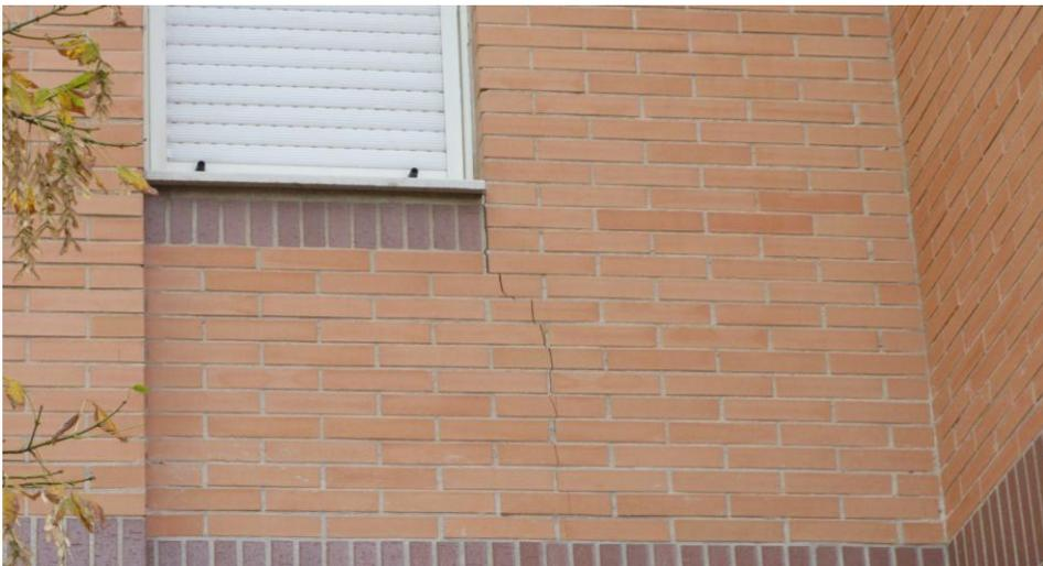
Foto 4.4. Fisuras en cerramiento de ladrillo con huecos.
