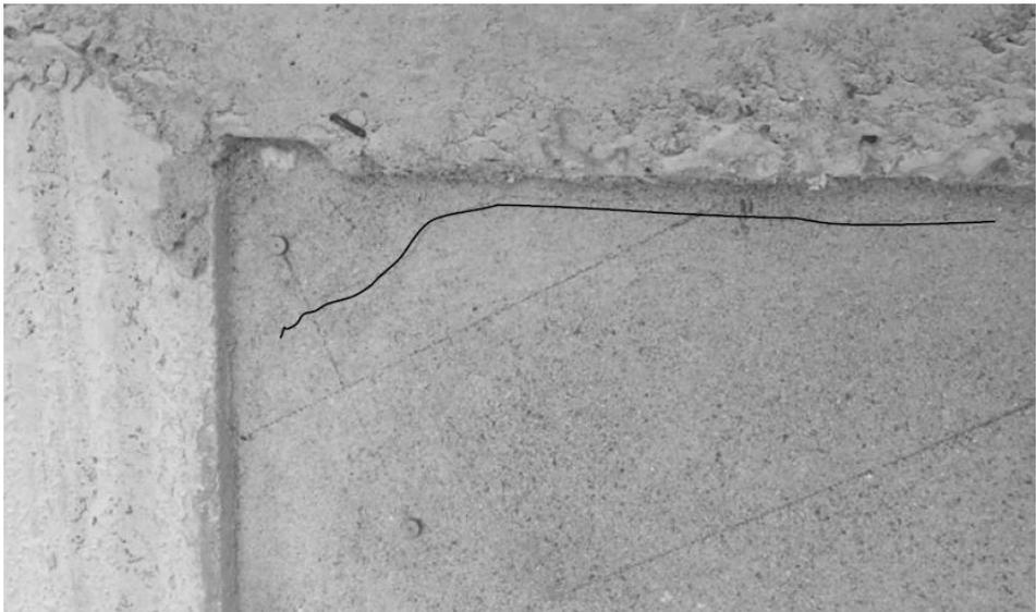
Foto 4.5. Fisura debida a movimientos térmicos (Dilrukshi, 2010).
