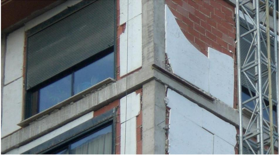
Foto A.59. Detalle del edificio sin hoja exterior.
