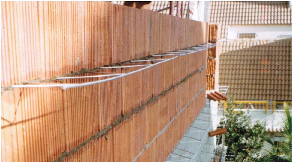
Foto 6.2. Llave de unión formada por armadura en celosía. (Mas, A. 2005)
