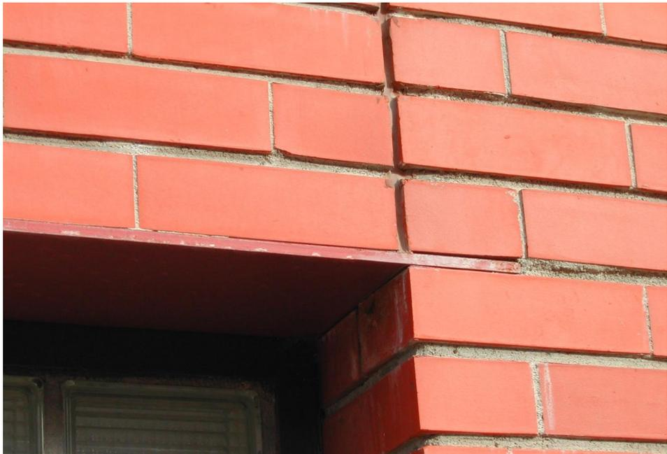
Foto A.29. Junta en hueco. Junta coincidiendo con hueco (Más, 2005).
