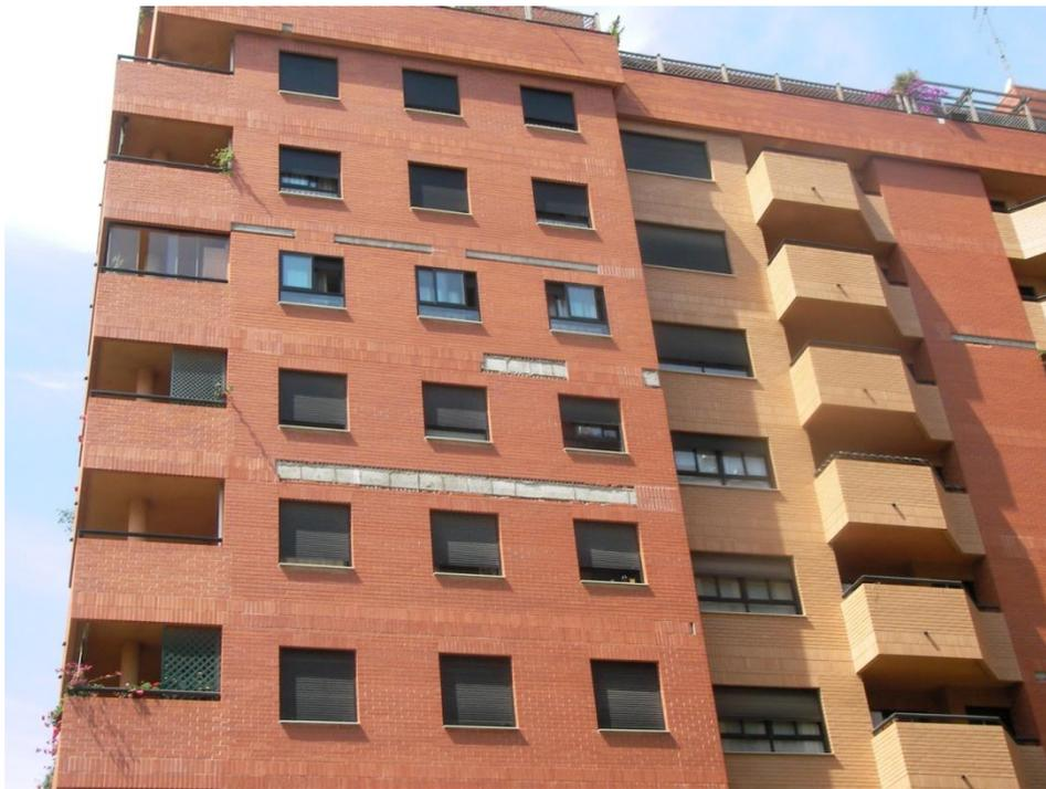
Foto A.10. Edificio con las plaquetas del frente de forjado desprendidas
