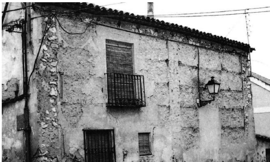
Foto 1.6. Muro de carga de tapial (Maldonado, 1997)
