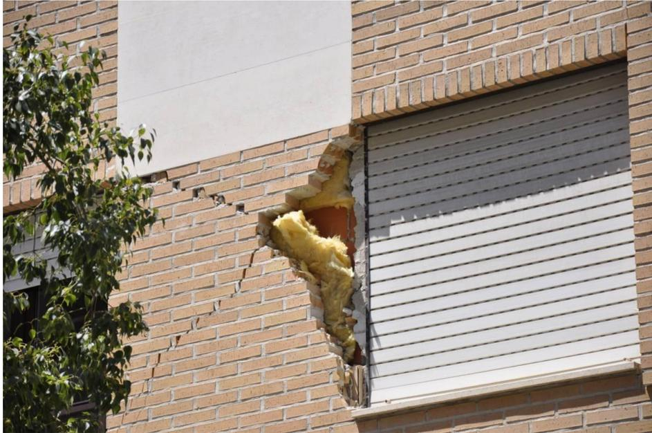
Foto A.17. Estado de cerramiento de ladrillo tras el terremoto de Lorca de 2011 (Lerma, 2011)
