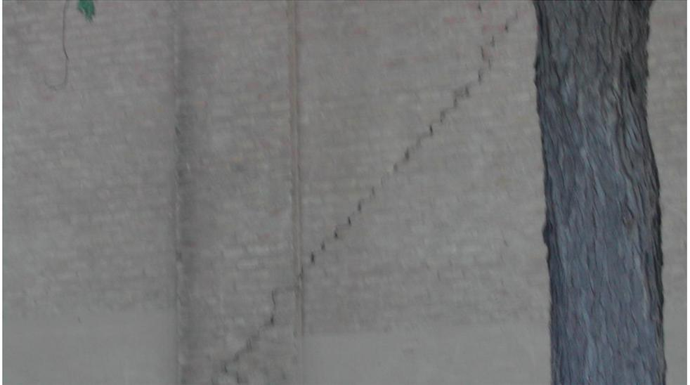
Figura A.0.8. Fisura provocada por el descenso del apoyo del cerramiento.
