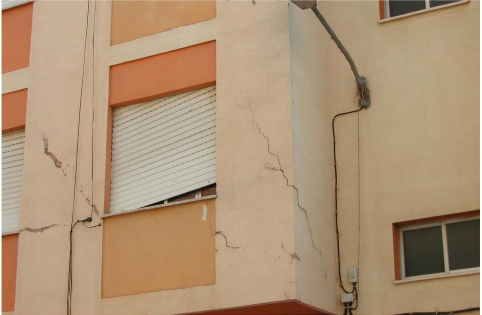
Foto A.7. Fisura debida a voladizo en cerramiento con revestimiento continuo.
