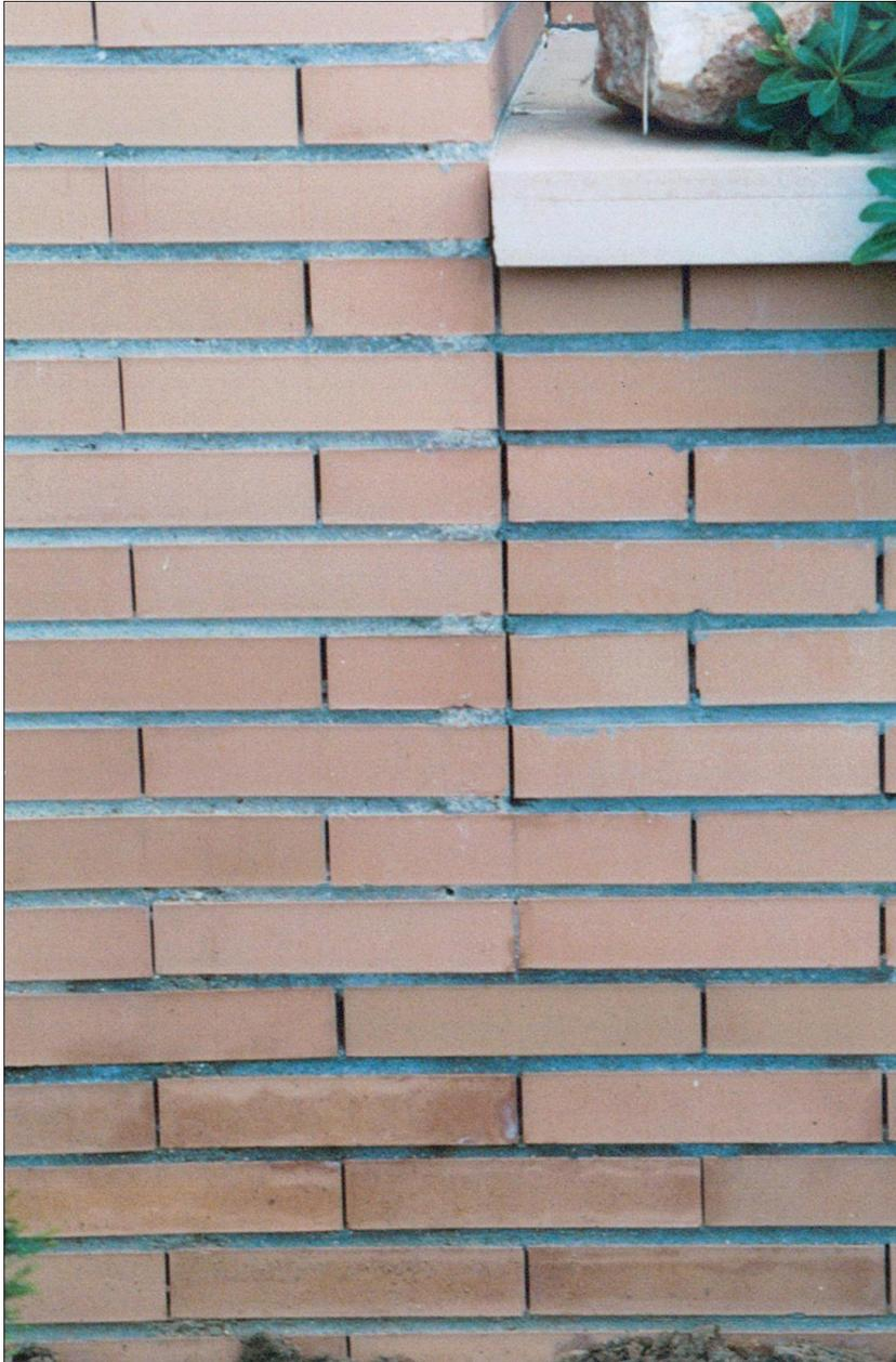
Foto A.32. Junta de deformaciones en la parte inferior del hueco.
