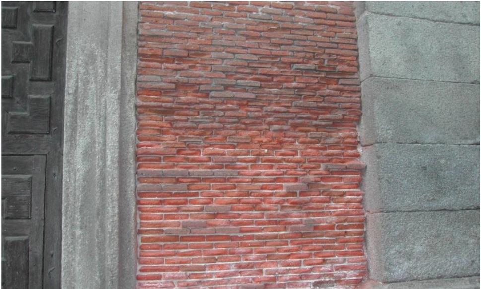
Foto A.4. Erosión del paramento.
