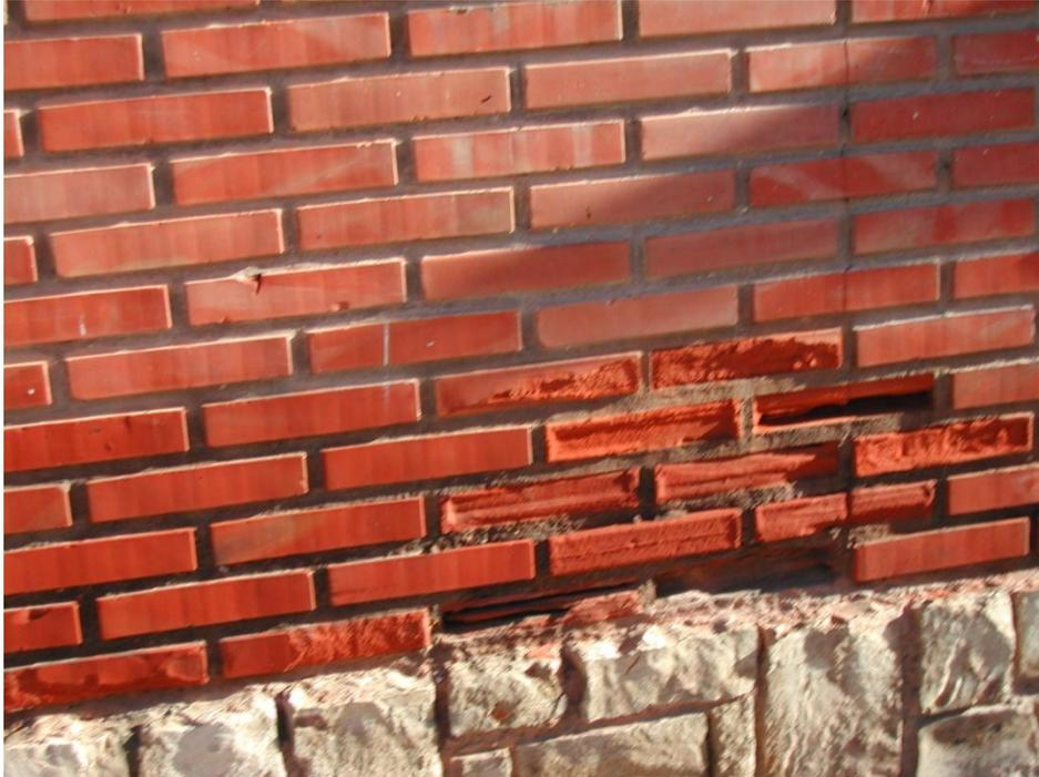
Foto A.2. Desprendimientos en muro de ladrillo.
