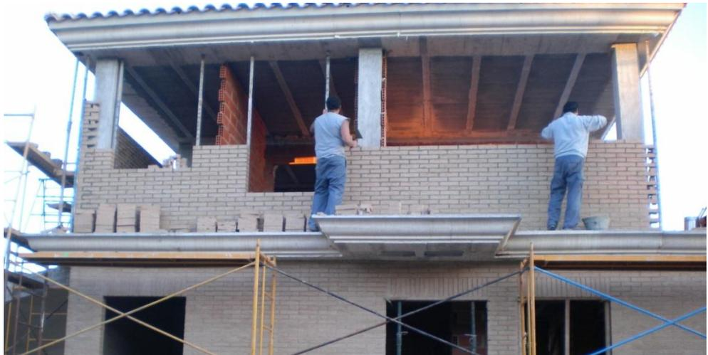
Foto 1.2. Puesta en obra del ladrillo en una fachada cara vista.
