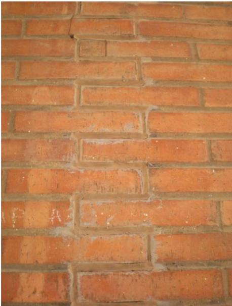
Foto A.38. Junta quebrada en fábrica de ladrillo
