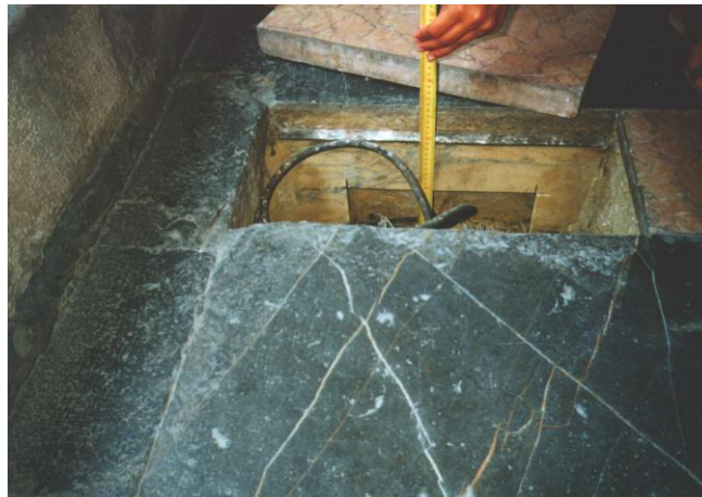
Fotografías que muestran pavimento actual, así como la posición del original, medida a través de uno de los registros para la canalización eléctrica.
