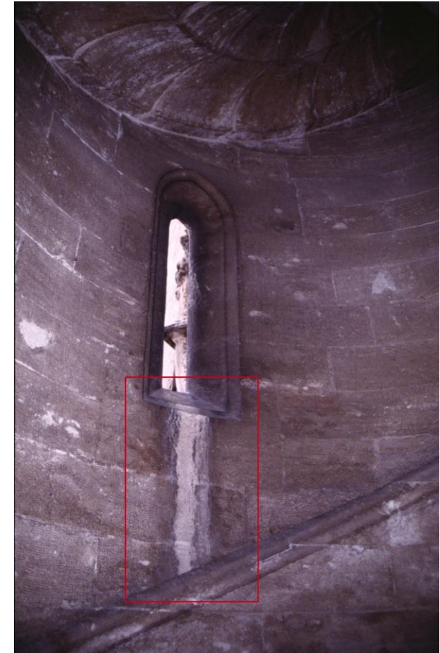
Adjunto fotografías del detalle en el que se encuentran las hojas abatibles de cerramiento de las ventanas de la escalera, así como las troneras (sin cierre alguno) con las lesiones que está causando la ausencia de un buen sistema de cierre.
