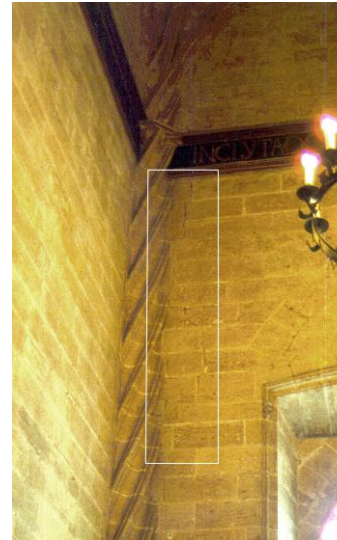
Fotografía de la grieta de la esquina sudoeste del salón columnario (derecha). En la parte superior, fotografía que denota la existencia de humedades en el Salón columnario, concretamente en la base de una de las semicolumnas pertenecientes al muro sur.
