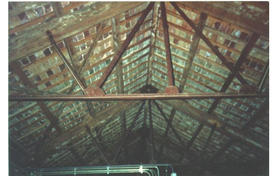
Planos de planta cenital, con la situación anterior y posterior a la intervención. Adjunto fotografías que muestran la naturaleza de la cercha Polonceau, así como las vigas roblonadas que servían de apoyo para sendas limatesas de la actual cubierta.
