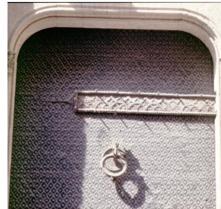
Fotografía actual de la puerta emplanchada, perteneciente a la portada Oeste del Salón Columnario. Sobre ella destaco el brazo del friso que supongo fue objeto de restauración, basándome en la intervención que haría el arquitecto D. Emilio Rieta en el año 1985. Al respecto, adjunto unas fotografías cedidas por gentileza de dicho arquitecto.
