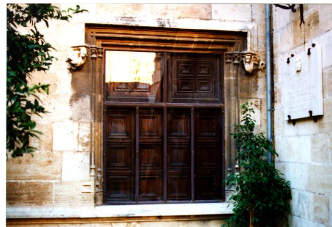
Fotografías que muestran la ventana izquierda de la planta baja del Consulado, cegada, y la situada en su parte derecha (que fuere transformada en puerta), ya repristinada.
