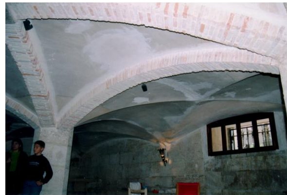
Fotografía del semisótano, en donde se pueden observar los refuerzos con rosca de fábrica de ladrillo macizo que fueron construidas en sus puntos más débiles: las intersecciones de los lunetos de las escarzas bóvedas por arista. Junto e ella, acompaña una sección constructiva de las bóvedas, con la hipótesis de la naturaleza de los materiales que fueron empleadas en su relleno.
