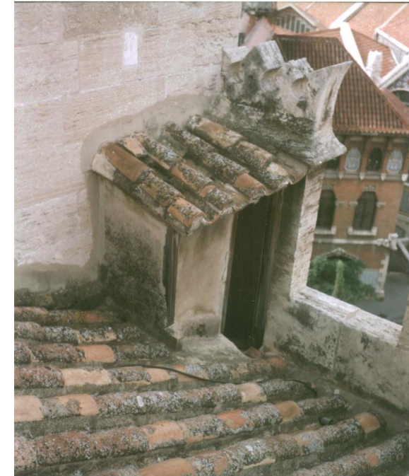
A la izquierda, fotografía de la escala de acceso a la cubierta del Consulado. Arriba el correspondiente casetón de dicha escala.
