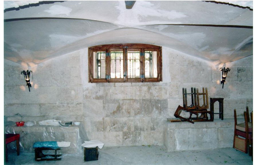
Fotografía actual, en la que se observa la ventana en el mismo lugar que antiguamente se encontraba ubicada la puerta de acceso a la plaza del Mercado. Obsérvese también las juntas y la diferente pátina de la piedra que delata la preexistente puerta.
