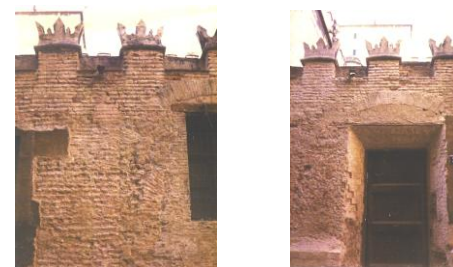
Fotografías del muro de cierre Este del Huerto de los Naranjos cuando sufrió una restauración a cargo del arquitecto D. Emilio Rieta. El carácter rudimentario y heterogéneo de la obra de fábrica que le asigna Cortina es evidente, pero se trata de obra original, aunque deteriorada por la falta de mantenimiento.
