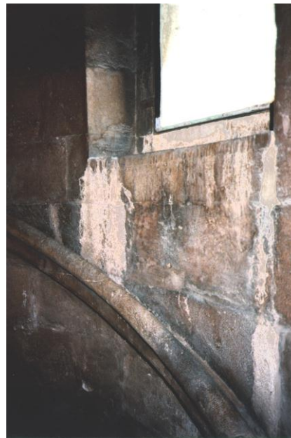
Fotografías de los ventanales a los que hago referencia, así como los efectos que un mal ajuste viene ocasionando en los muros, peldaños y bóvedas de la escalera de caracol.
