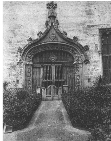
Puerta de orientación Norte. Fotografía del siglo pasado donde aparece una puerta de madera que podría tratarse de la original
