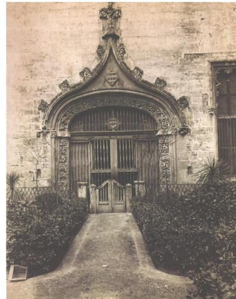
Fotografía que muestra el estado del Huerto de los Naranjos, en torno al año 1885, obsérvese la existencia de rejas de hierro en las ventanas del Columnario, a juzgar por la que aparece colocada en la ventana derecha; así como daños de importancia en los elementos ornamentales de la portada. A la derecha dibujo un plano de planta del Huerto, con la distribución que debía tener por aquellas fechas.
