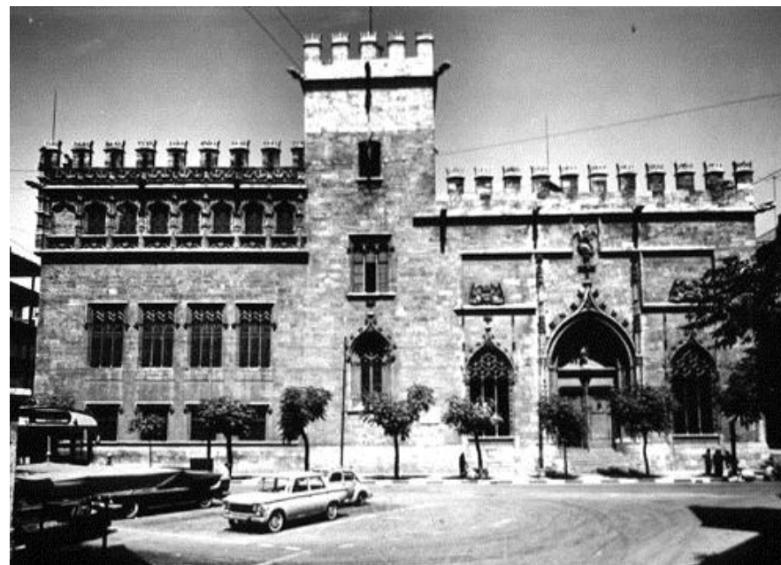
Fachada Oeste de la Lonja
