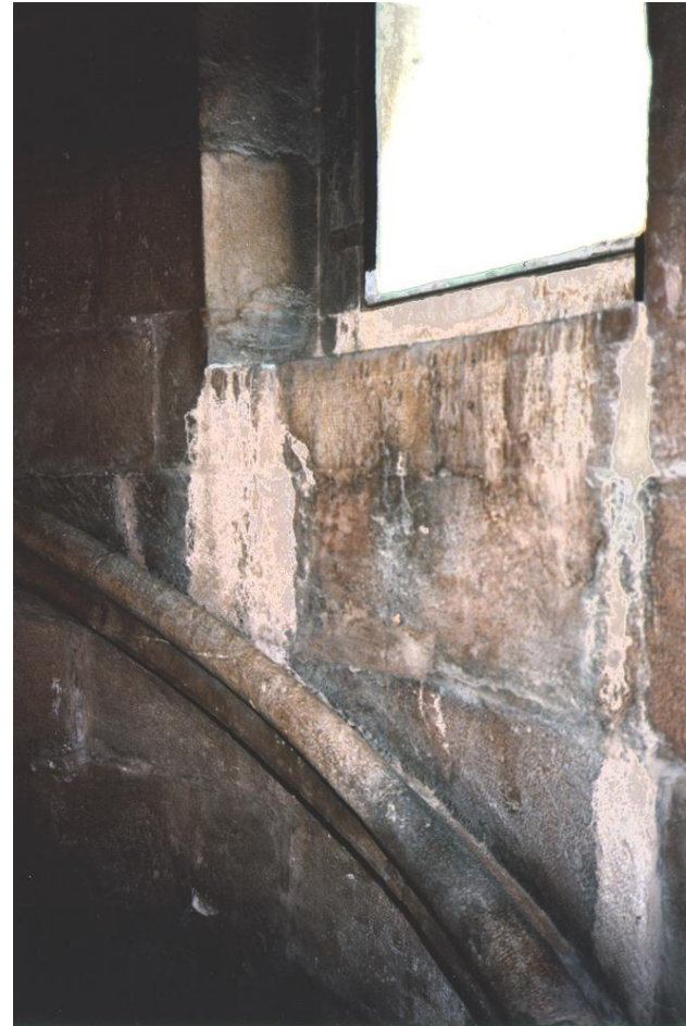
Adjunto fotografías del detalle en el que se encuentran las hojas abatibles de cerramiento de las ventanas de la escalera, así como las troneras (sin cierre alguno) con las lesiones que está causando la ausencia de un buen sistema de cierre.
