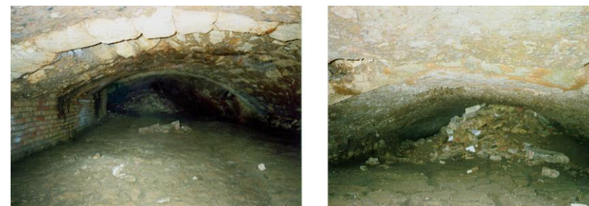
Fotografías que pude realizar en el interior del Valladar en la excavación realizada por el Arqueólogo Josep Burriel, entre las calles de Mantas y Ercilla, mostrando el estado y tipología de su construcción.
