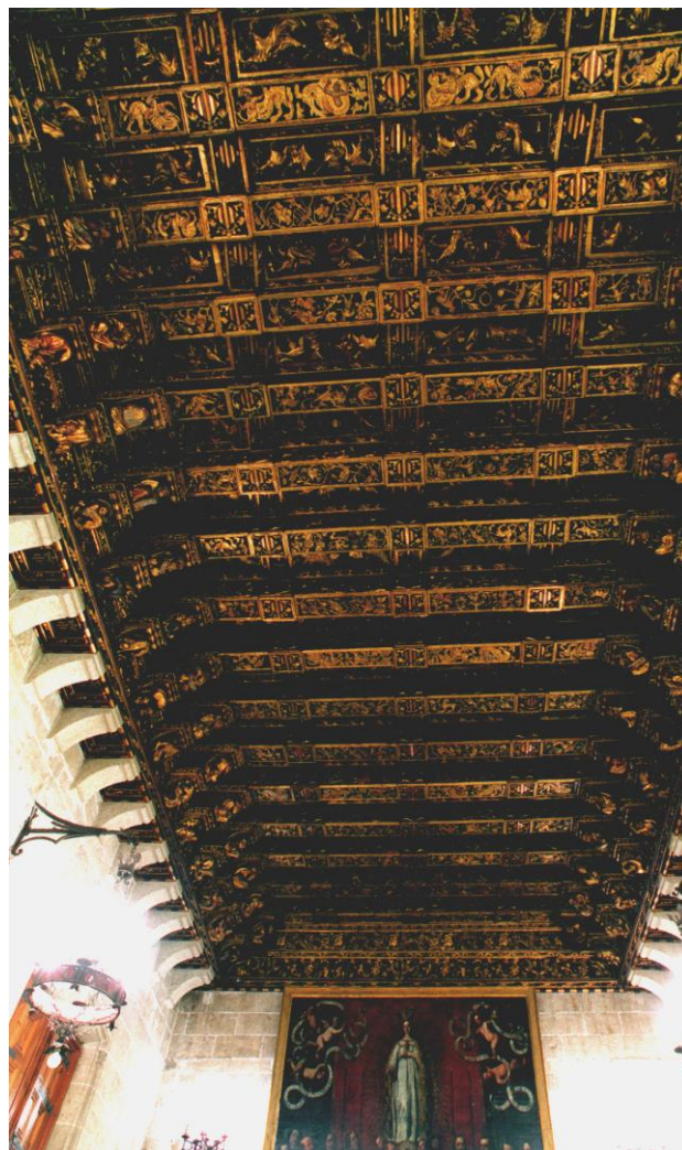
Fotografías del artesanado con el aspecto actual. Véase un nuevo artificio que hubo de hacerse en el muro Norte, con el fin de absorber la falsa escuadra que tenía la planta primera del consulado durante su construcción.
