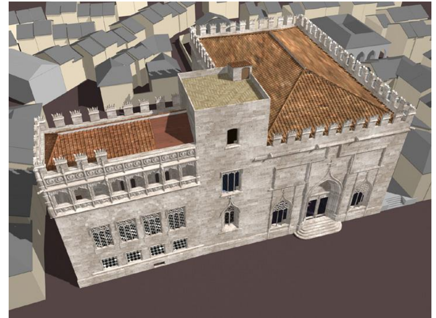
Perspectiva que muestra la solución de la cubierta inclinada del Consulado y el estado de las obras en el mes de julio del año 1534.
