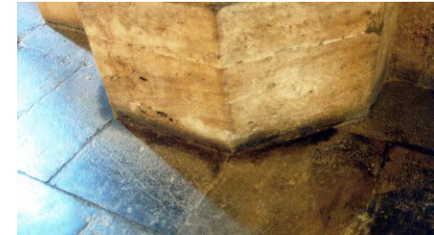
Fotografía de la grieta de la esquina sudoeste del salón columnario (derecha). En la parte superior, fotografía que denota la existencia de humedades en el Salón columnario, concretamente en la base de una de las semicolumnas pertenecientes al muro sur.
