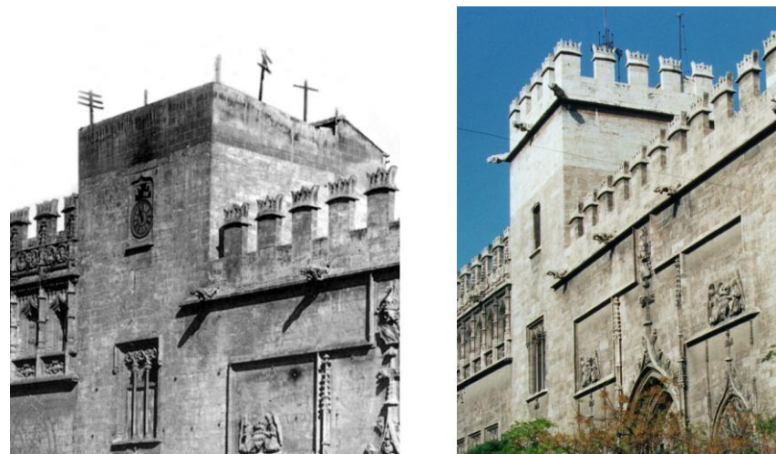
Detalle de fachada con el remate de la Torre de la Lonja, antes y después de la intervención del arquitecto Antonio Ferrer y el Escultor José Aixa.
