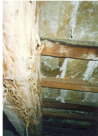
Otra fotografía, pertenecientes al reportaje que hice en el año 1995, sobre el ataque de xilófagos en el conjunto monumental de la Lonja. Sobre un plano de sección longitudinal, por el Consulado, destaco las zonas más afectadas por el ataque de termitas.
