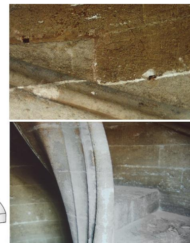
Detalle de peldaño y fotografías donde se aprecia la cualidad y multiplicidad funcional del peldañado. Un pasamanos metálico fue colocado en un momento determinado, del que, en la fotografía adjunta, destaco restos de los anclajes.
