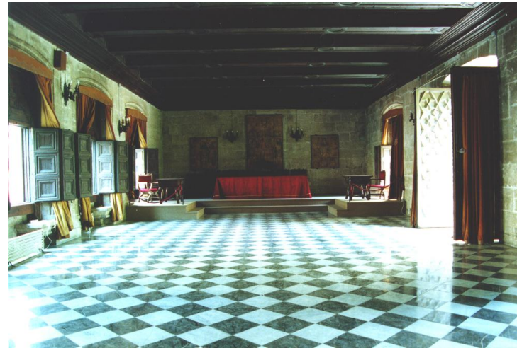
Fotografías del estado en el que se encuentra actualmente el pavimento, ya repriminado.
