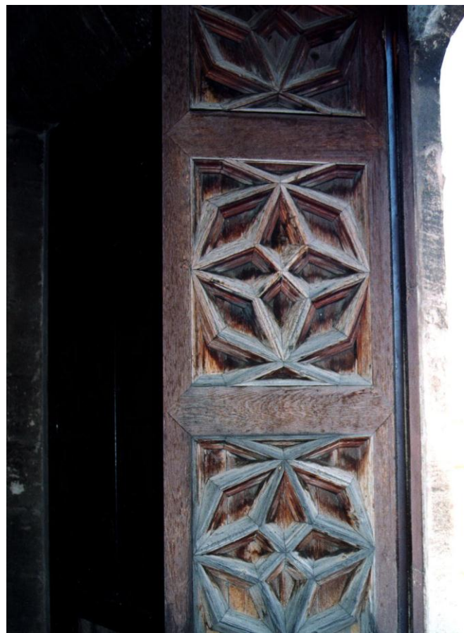
Fotografía que muestra, en detalle, las fraileras de la loggia del Consulado tal y como se encuentran hoy; en ellas se puede apreciar la laboriosidad del trabajo de los carpinteros y el diseño de Aixa.
