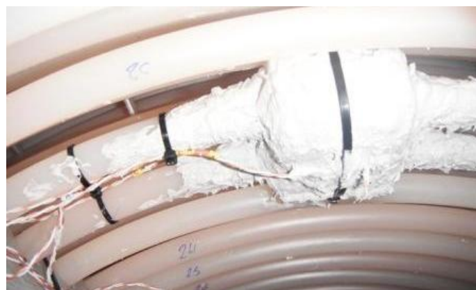
Figura 60. Detalle impermeabilización triada superior
