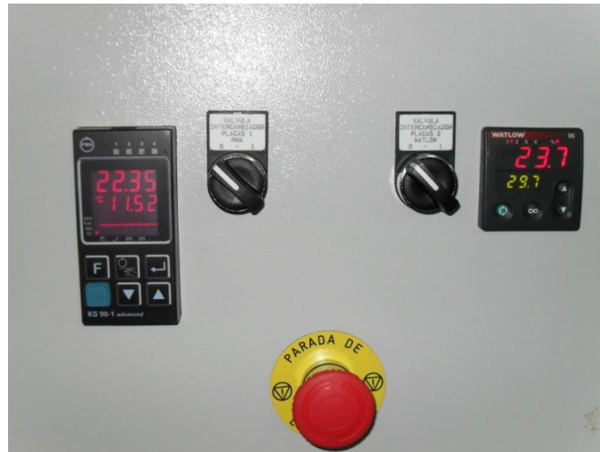
Figura 55. PIDs del cuadro eléctrico principal
