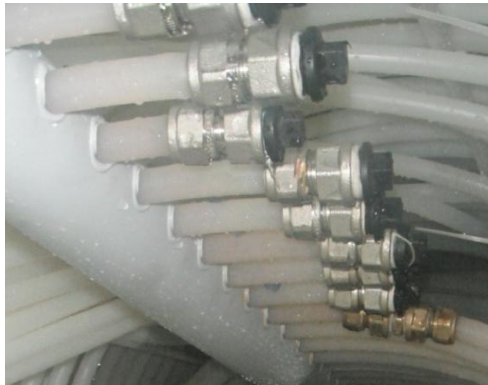
Figura 42. Detalle de uno de los colectores modificados
