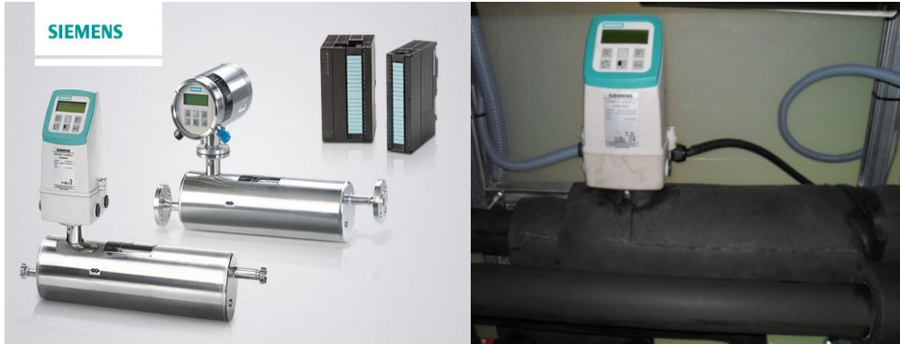
Figura 35. Coriolis de SIEMENS en la instalación
