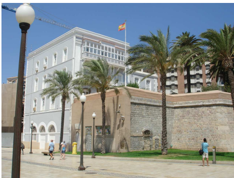
Fig. 160. Detalle del corte producido en las Murallas del Mar entre el Gobierno Militar y la Darsena de Botes, facilitando la conexión entre la Plaza del Ayuntamiento y el Puerto (Tras la intervención de Torres Nadal). GGI.
