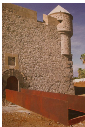
Figs. 48, 49. NIETO y SOBEJANO. Museo del Mar en el Castillo de la Luz, de Puerto de la Luz, Las Palmas de Gran Canaria (AA.VV. Spain Architects. Rehabilitation 1 . Manuel Padura. Barcelona pp. 15, 18.).
