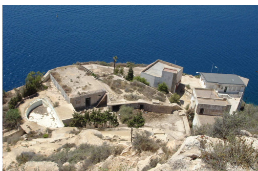
Fig. 168. (izq.). Batería de Trincabotijas Baja. Esta batería, una de las baterías exteriores de la bocana, más antigua de Cartagena, se moderniza de acuerdo con el proyecto aprobado por R.O. de 28 de Junio de 1898, dotándola de dos cañones de acero Krupp de 30,5 Cms. de calibre, modelo de 1887, de giro central, que fueron montados en Agosto de 1898, sobre una cota de 50,315 m. y un alcance de 12.000 m. (Fuente: Plan Director de Fortificaciones de Cartagena)
