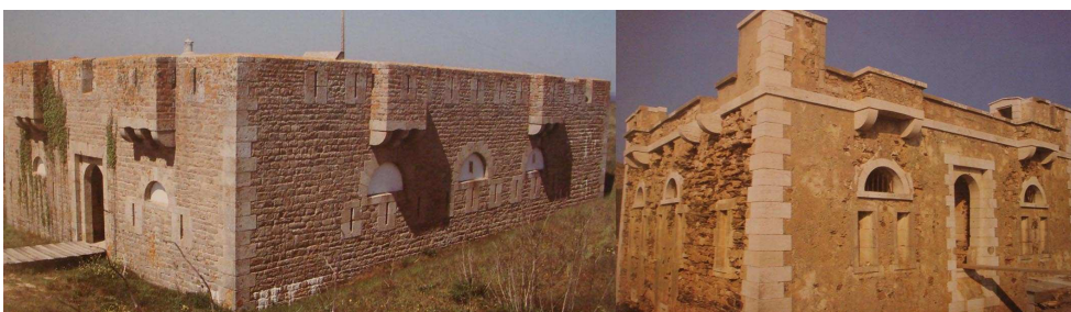
Fig. 234. Izq. Batería d'En Tal (Ile d'Houat). Cuerpo de Guardia defensivo ejecutado en 1857 que responde al tipo nº 1 propuesto por la Comisión Técnica Francesa de 1846. Dcha. Batería Sur de la Rade d'Hyères, en Ile de Bagaud. Protipo de torre amatacanada respondiendo al prototipo nº 2 de la Comisión de 1846 (TRUTTMANN, Op. cit. p. 161).
