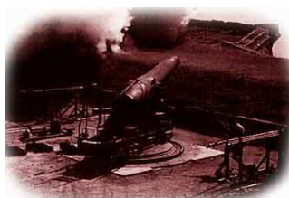
Fig. 175. (izq.). Obús de hierro sunchado Ordóñez, 24 cm. (PD).
