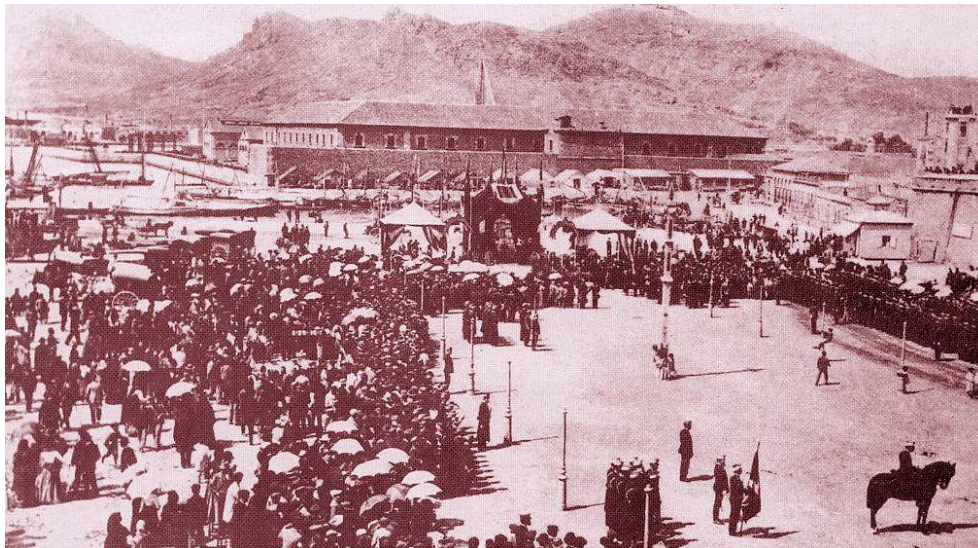
Fig. 137. Las puertas del Muelle y el tramo de muralla del Cuartel de Presidarios, como últimos elementos de la fortificación urbana del siglo XVIII junto al puerto (en GÓMEZ VIZCAINO; MUNUERA, La fortificación del siglo XVIII . p. 217.).
