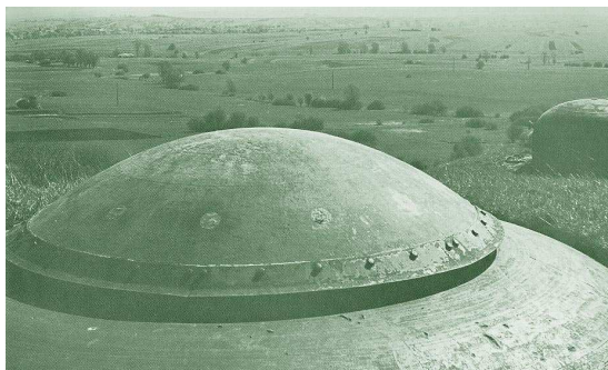
Fig. 116. Dos tipos de cúpula empleados en la Línea Maginot . La izquierda, destinada a artillería, era retráctil mientras que la derecha era fija y estaba destinada como puesto de observación. (MALLORY, p.101)
