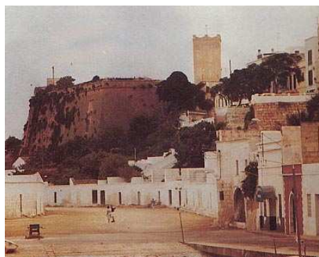
Figs. 20, 21. Aspecto exterior del Baluarte de Sa Font en Ciutadella antes y después de la intervención. «El tratamiento del exterior comprende trabajos de consolidación y reparación de coronación y cubiertas, así como la recuperación de la fábrica original, demoliendo los adosamientos realizados a principios del siglo actual...» (ICRBC, p. 328)
