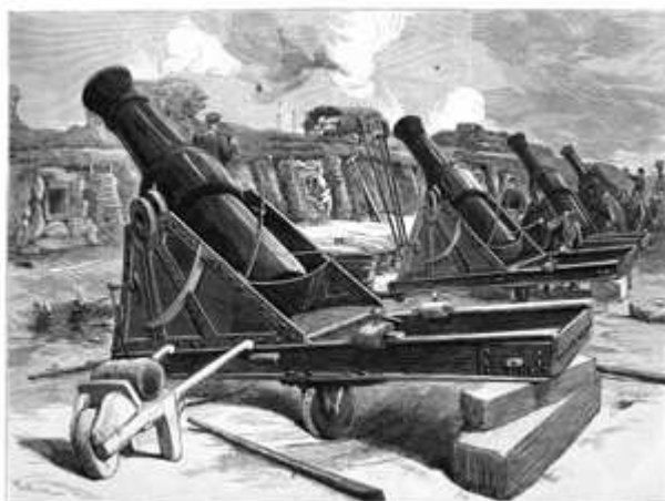
Fig. 163. Batería centralista núm. 2. 1873. xilografía 23x32. La ilustración Española y Americana. La batería está constituida por Obuses de hierro sunchado de ánima rayada de 21 cm. modelo 1872.
