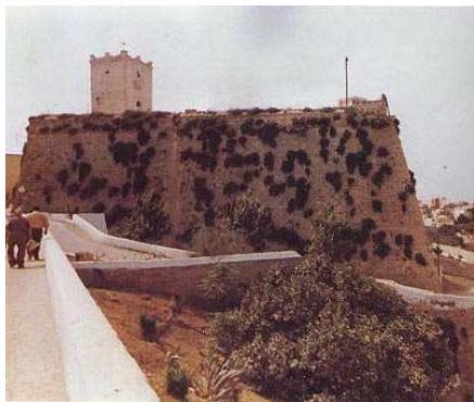
Figs. 20, 21. Aspecto exterior del Baluarte de Sa Font en Ciutadella antes y después de la intervención. «El tratamiento del exterior comprende trabajos de consolidación y reparación de coronación y cubiertas, así como la recuperación de la fábrica original, demoliendo los adosamientos realizados a principios del siglo actual...» (ICRBC, p. 328)
