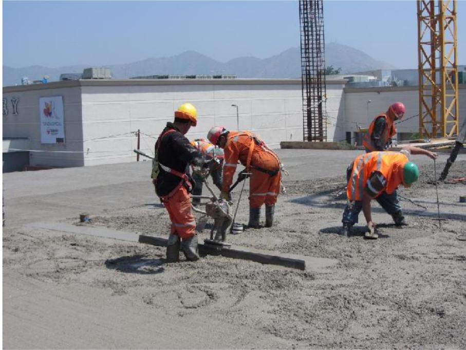
Fotografía 37. Operario pasando la cercha para obtener espesor adecuado.
