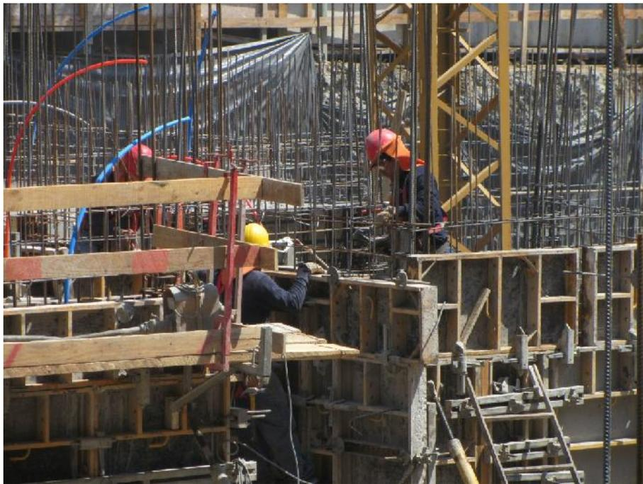
Fotografía 30 Fijación de moldaje. Fuente: elaboración propia
