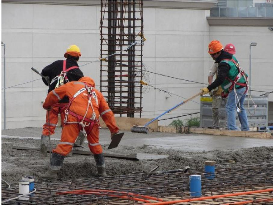
Fotografía 35. Operario ajustando espesor de hormigón. Fuente: Elaboración propia
