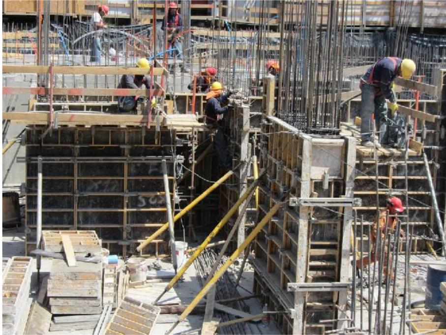
Fotografía 29. Fijación de moldaje. Fuente: elaboración propia
