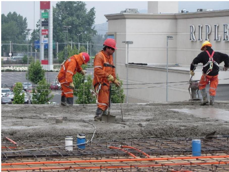
Fotografía 36. Operario ajustando espesor de hormigón. Fuente: Elaboración propia
