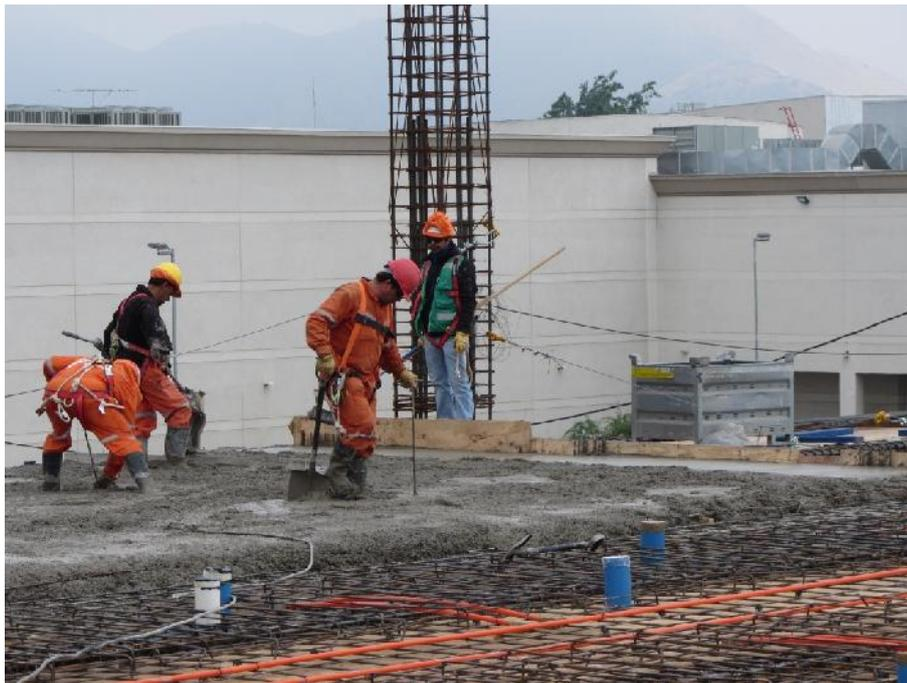
Fotografía 34. Operario midiendo espesor losa. Fuente: Elaboración propia
