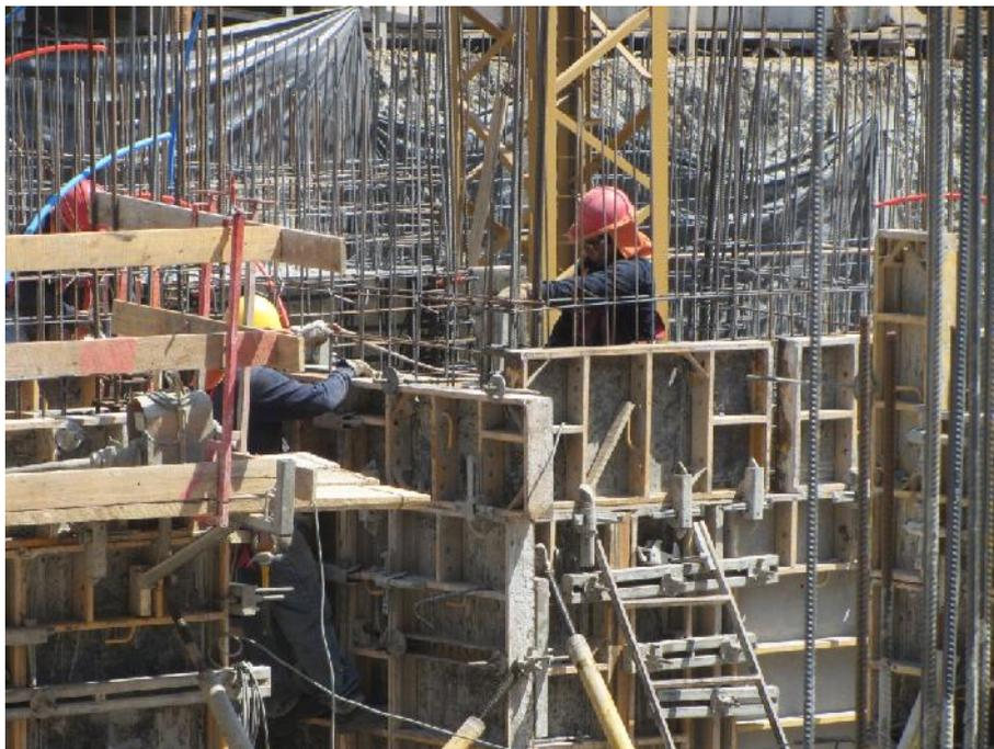
Fotografía 32. Fijación de moldaje. Fuente: elaboración propia
