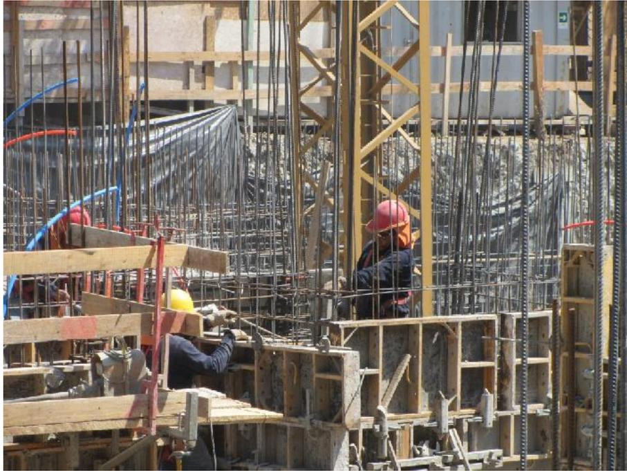
Fotografía 31 Fijación de moldaje. Fuente: elaboración propia
