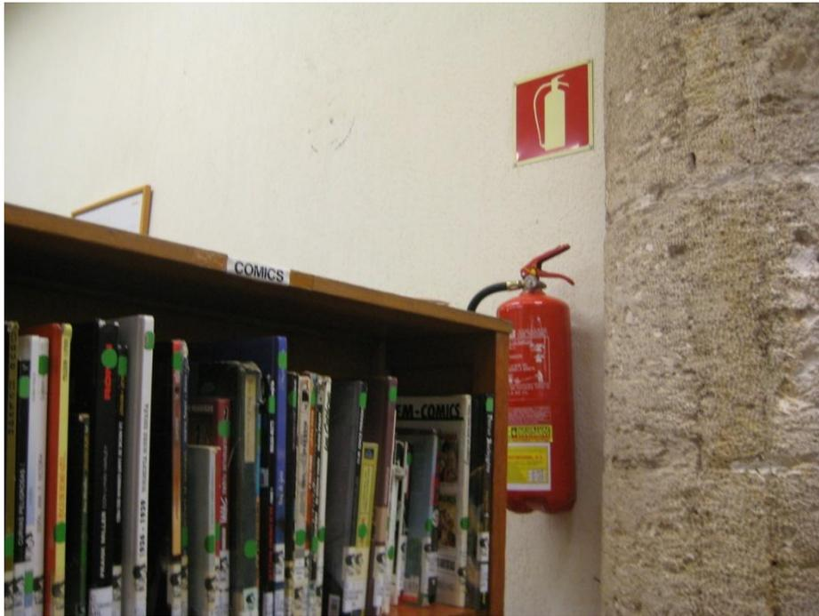
Fig.1: Detalle de la colocación inadecuada del extintor en la 1ª Planta de difícil visualización
