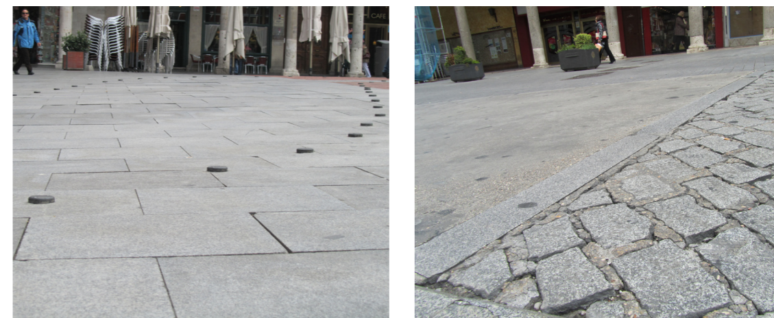
Fig.138 y 139. Resaltos del parking de la Plaza Mayor y banzo en dicha plaza
