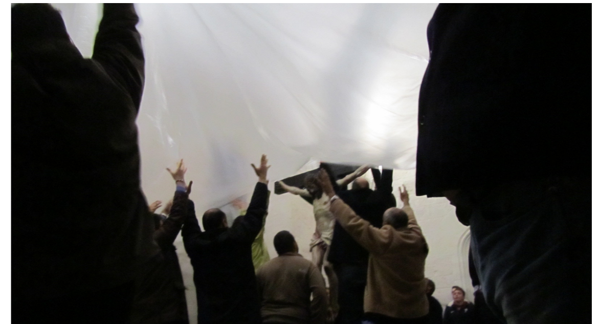
Fig. 134. Retirada del plástico del Cristo de la Luz . Una buena coordinación es imprescindible para evitar incidentes
