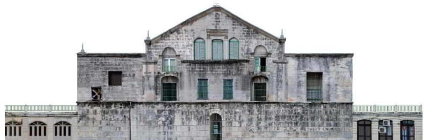
Figura 20.2. Fachada Sur/Posterior. Fuente: Atlas.
