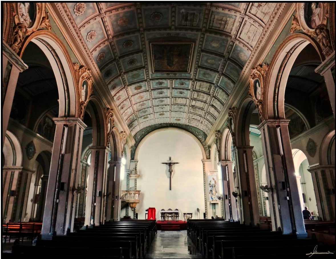
Figura 22.2. Interior de la Catedral. Cúpulas interiores y bóvedas de cañón junto a pilastras de albañilería. Fuente: Propia. Manuel Villanueva Rodríguez.
