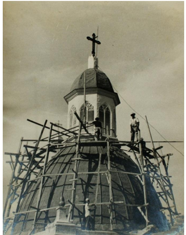
Figura 20.2. Trabajos en la Cúpula Mayor.
