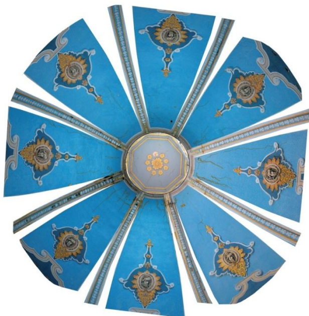
Figura 34.2. Fisuramiento en el recubrimiento de la cúpula. Fuente: Atlas
