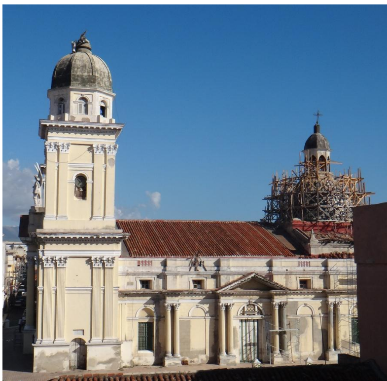
Fig. 28. Sustitución de tejas. Fuente: Propia, M. Villanueva
