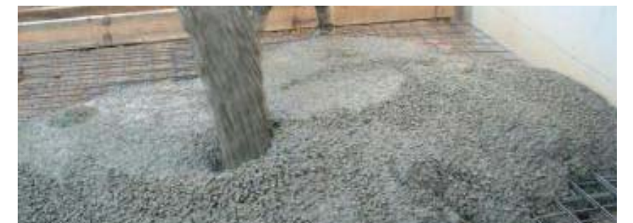
Ilustración 5.3. Vertido de hormigón en masa sobre un emparrillado.
