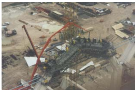
Ilustración 6.29. Ejecución de las piezas nº 4.
