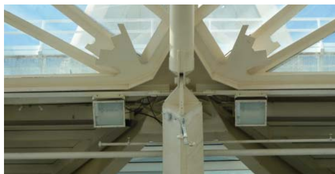
Ilustración 6.57. Fotografía de la articulación de la pieza 6.
