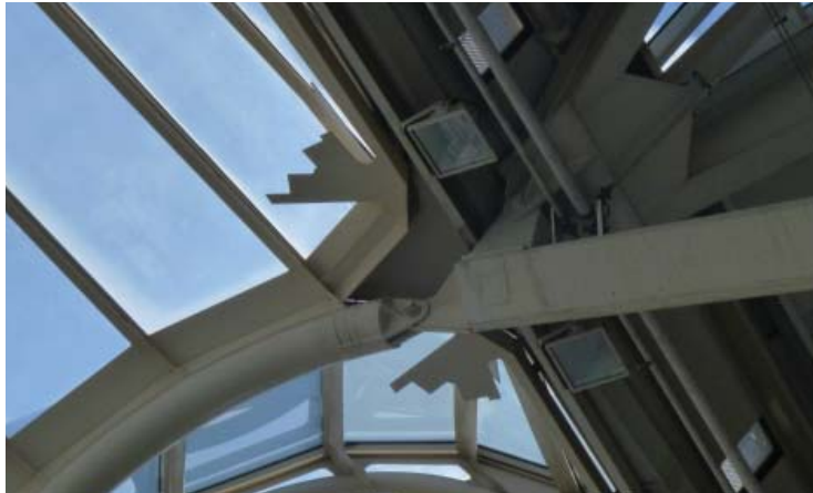
Ilustración 6.48. Fotografía de las dos articulaciones de la pieza 7.
