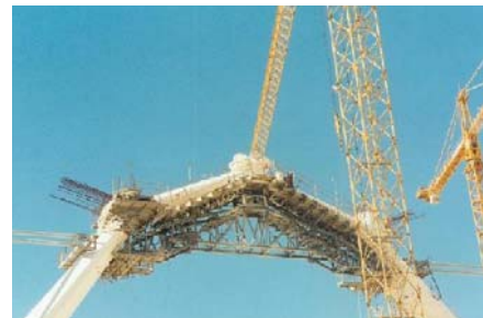
Ilustración 6.27. Ejecución de las piezas nº 4.
