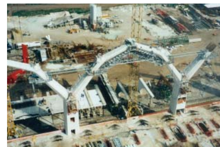
Ilustración 6.31. Ejecución de las piezas nº 4.
