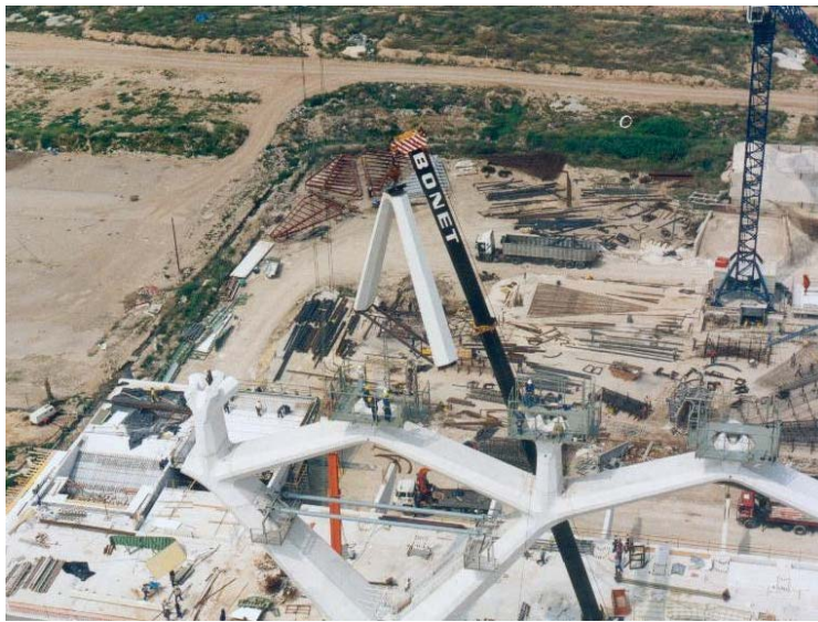
Ilustración 6.38. Colocación de la pieza nº 8 mediante grúa telescópica.
