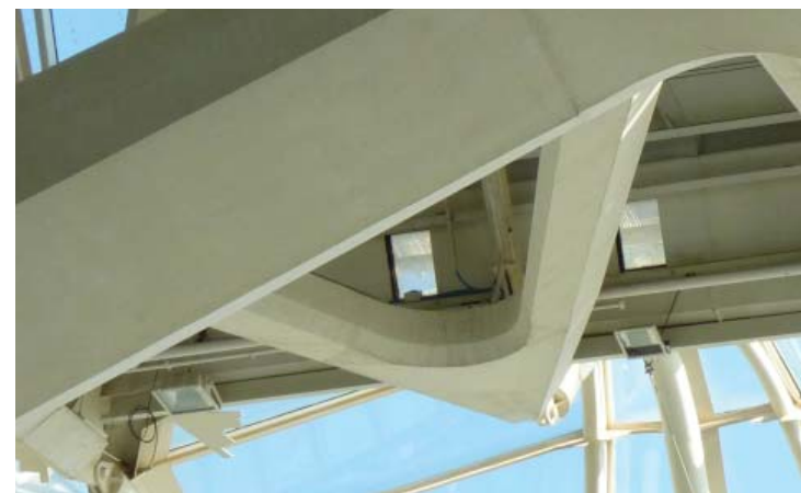
Ilustración 6.51. Fotografía de la articulación del árbol con la cubierta.
