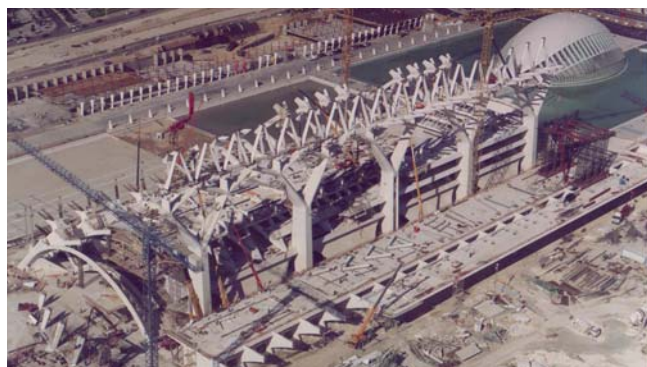
Ilustración 6.44. Fotografía 1 aérea de la ejecución de las piezas nº 6 y 7.
