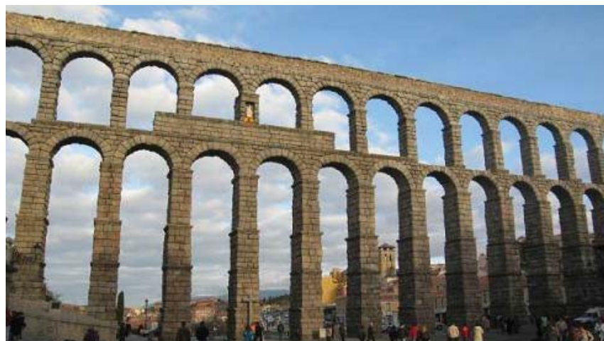
Ilustración 5.1. Fotografía del acueducto de Segovia.
