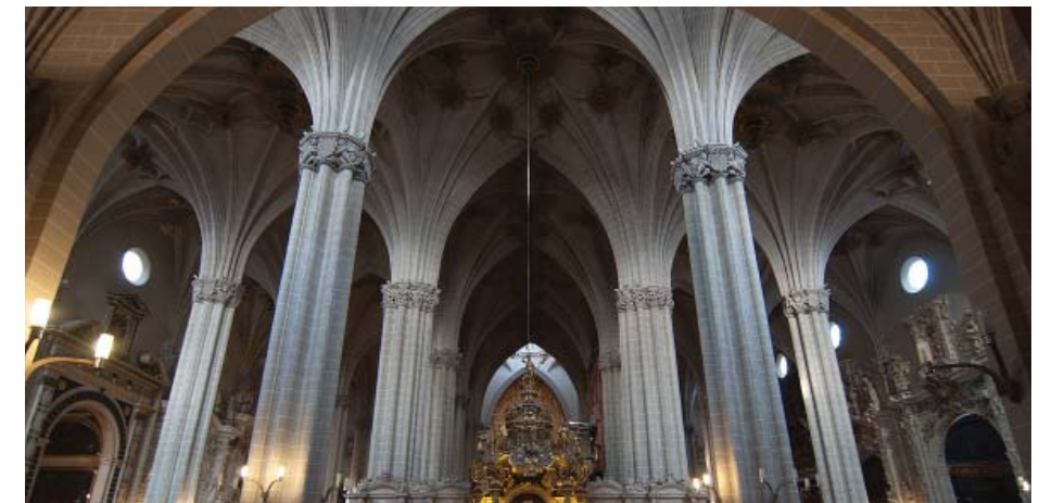
Ilustración 3.13. Fotografía interior de la Seo de Zaragoza.
