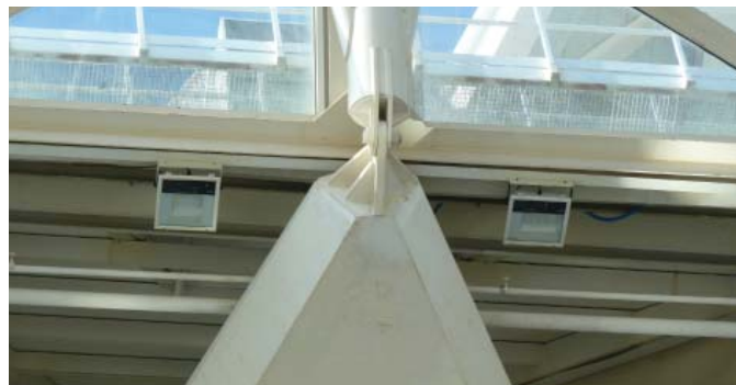
Ilustración 6.55. Fotografía de la articulación de la pieza 7.
