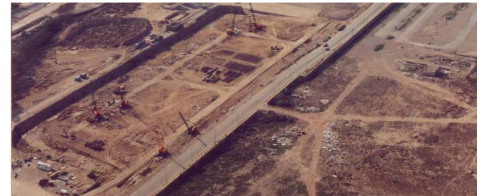
Ilustración 6.2. Cimentación por pilotes. (Septiembre 1995)
