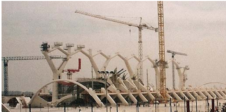
Ilustración 6.34. Vista de la ejecución de las piezas nº 3.
