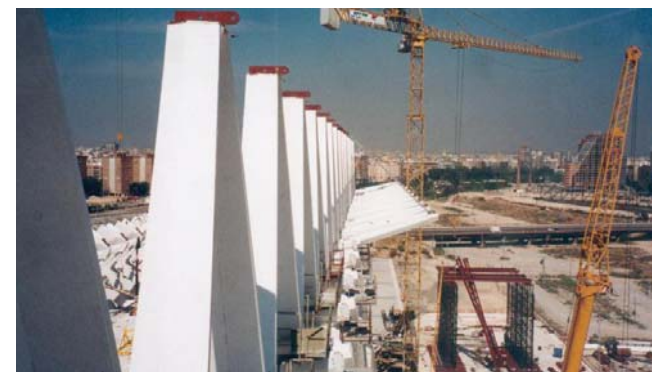
Ilustración 6.47. Colocación de la pieza nº 6 y 7 mediante grúa telescópica.
