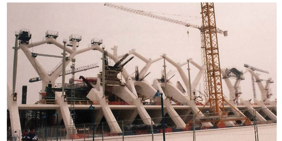
Ilustración 6.21. Vista de la zona de trabajo del Museo desde la fachada sur.
