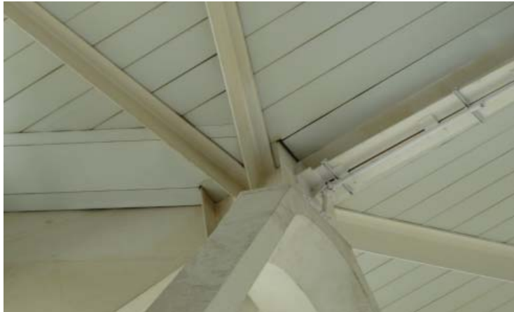
Ilustración 6.52. Fotografía del apoyo del árbol con la cubierta.
