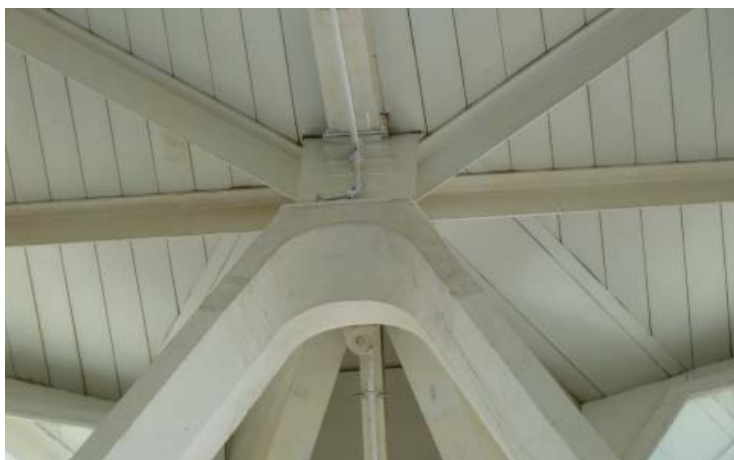
Ilustración 6.53. Fotografía del apoyo del árbol con la cubierta.
