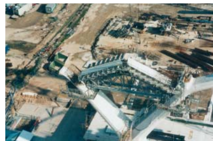
Ilustración 6.30. Ejecución de las piezas nº 5.
