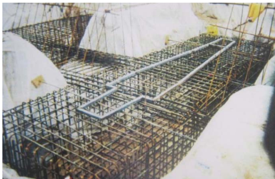
Ilustración 6.3. Armado del encepado.
