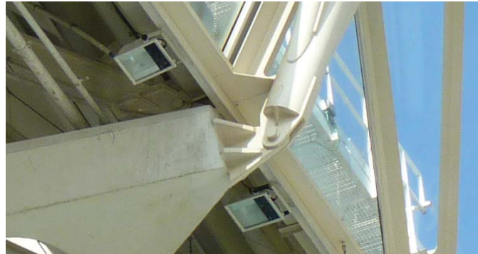
Ilustración 6.54. Fotografía de la articulación de la pieza 7.
