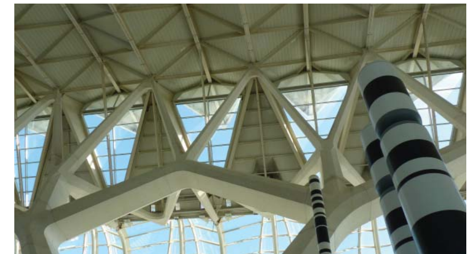
Ilustración 6.40. Fotografía de las piezas nº 8 ya ejecutadas.
