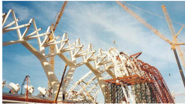
Ilustración 6.43. Colocación de la fachada sobre las piezas nº 6 y 7.
