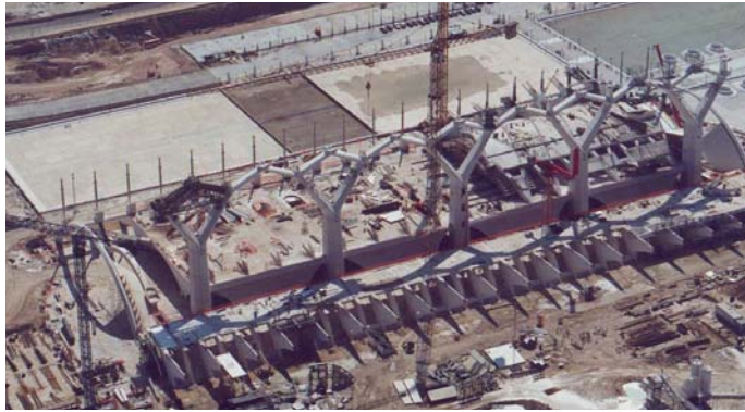
Ilustración 6.25. Vista aérea de la ejecución del último arco.
