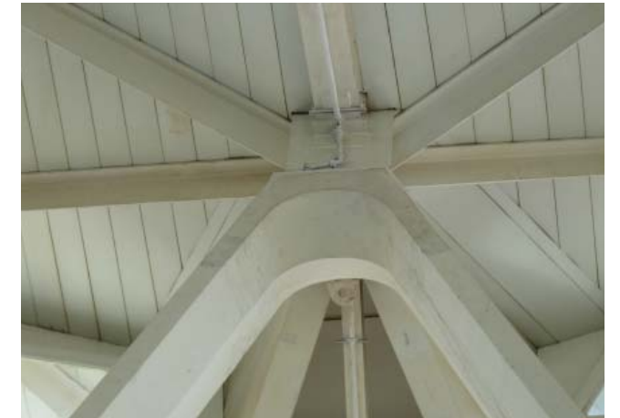
Ilustración 6.39. Nudo articulado de la cubierta.
