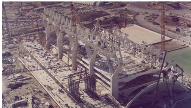
Ilustración 6.45. Fotografía 2 aérea de la ejecución de las piezas nº 6 y 7.
