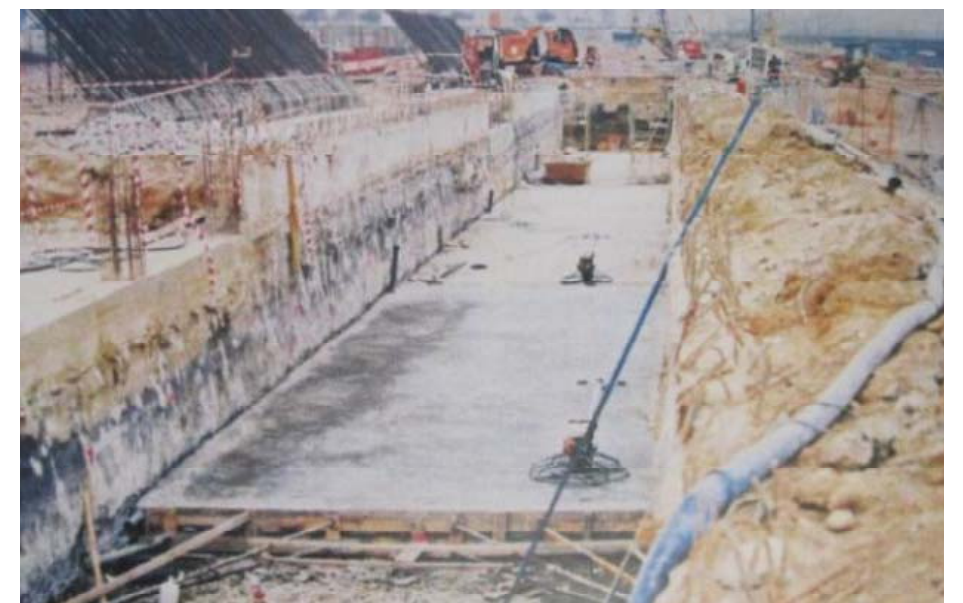
Ilustración 6.5. Solera de hormigón.
