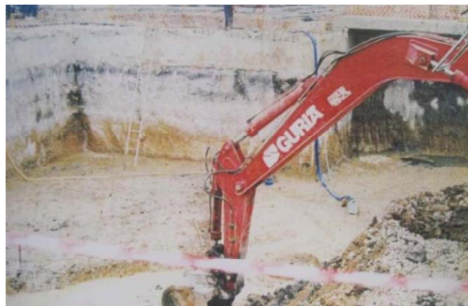
Ilustración 6.4. Excavación y agotamiento de agua.
