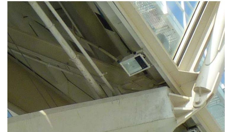
Ilustración 6.50. Fotografía de las dos articulaciones de la pieza 6.
