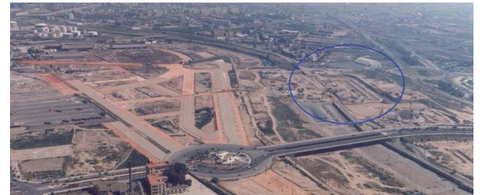
Ilustración 6.1. Fase inicial de las obras. Explanación. (Mayo 1995)
