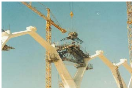
Ilustración 6.26. Ejecución de las piezas nº 5.
