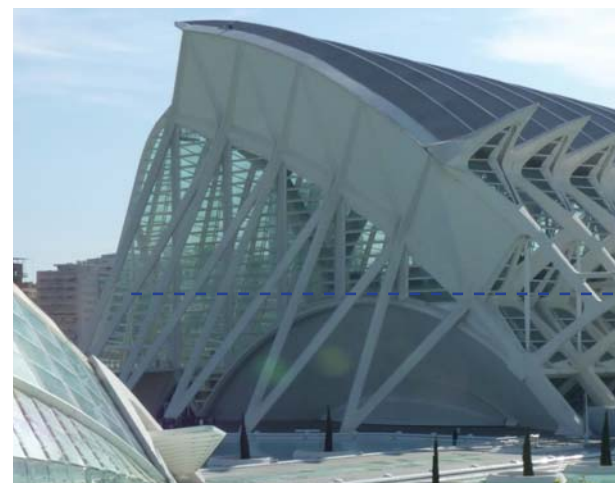
Ilustración 5.2. Contrafuertes del Museo.
