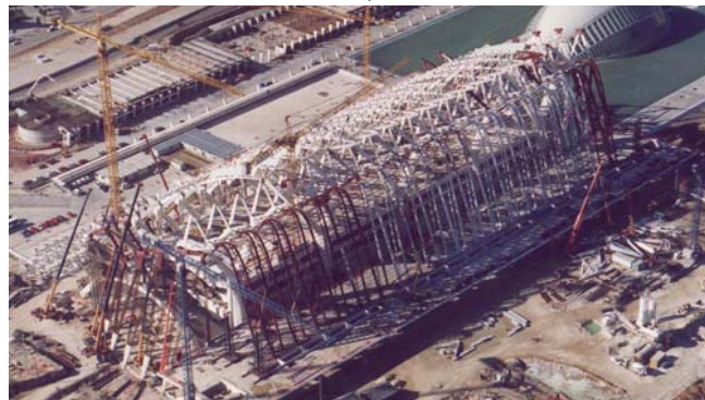
Ilustración 6.46. Fotografía aérea de la ejecución de la fachada norte del Museo.
