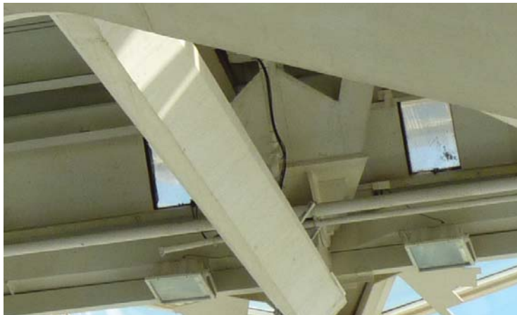
Ilustración 6.49. Fotografía de la articulación del árbol con la cubierta.
