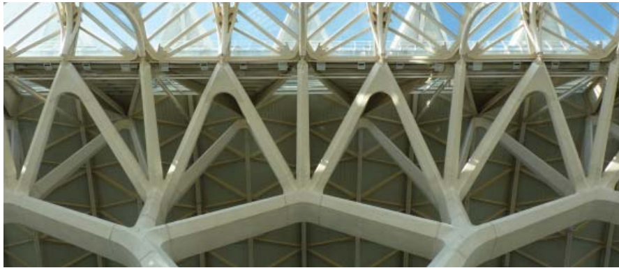
Ilustración 6.42. Fotografía de las piezas nº 6 y 7 ya ejecutadas.
