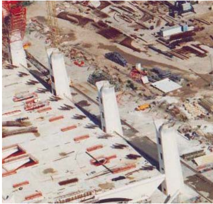
Ejecución de los nudos nº 1.
