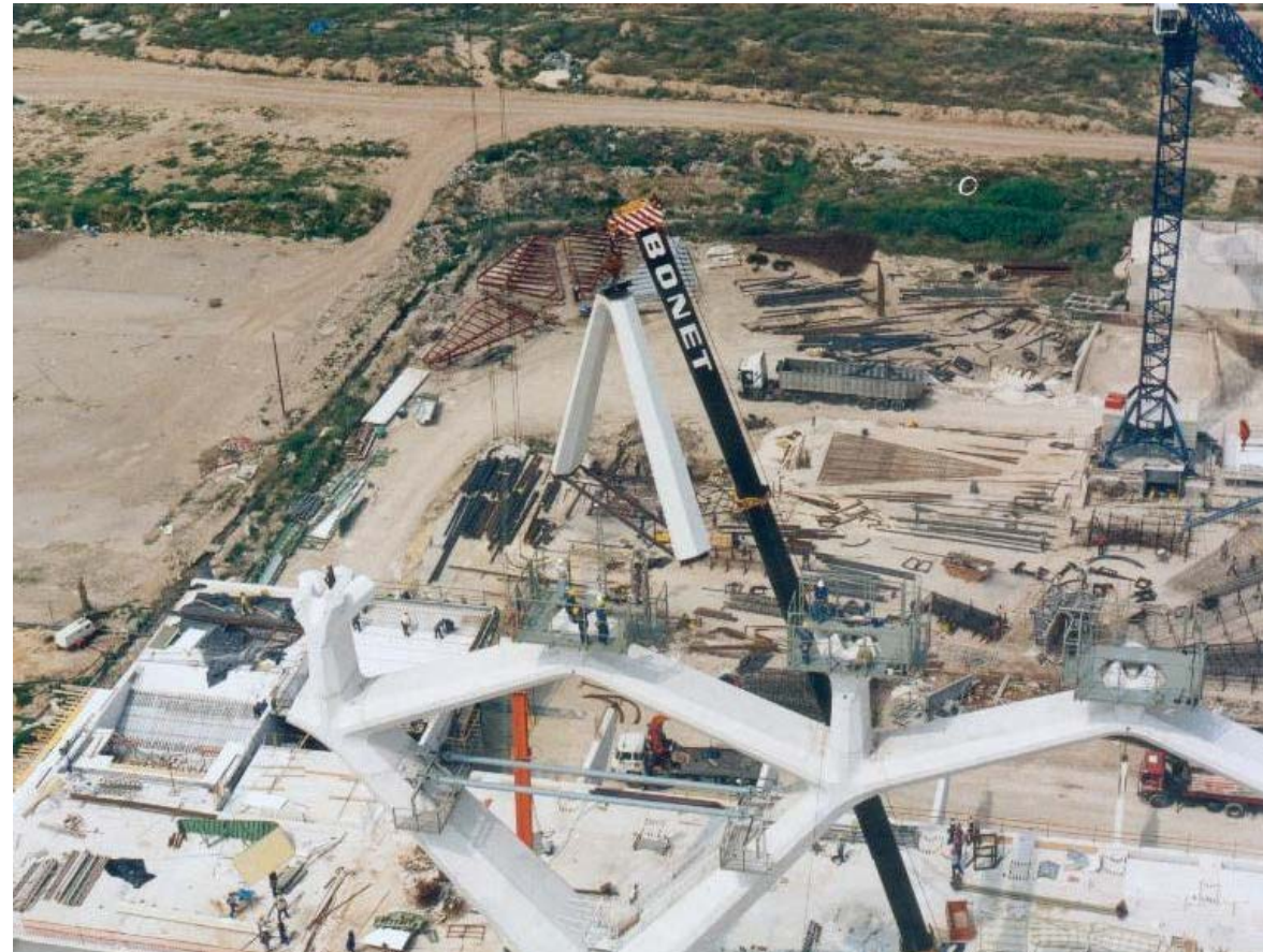
Ejecución de las piezas 8.
