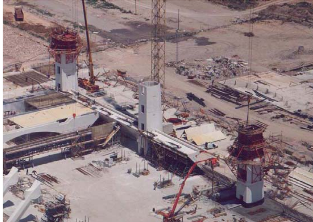
Ejecución de los fustes de los pilares.
