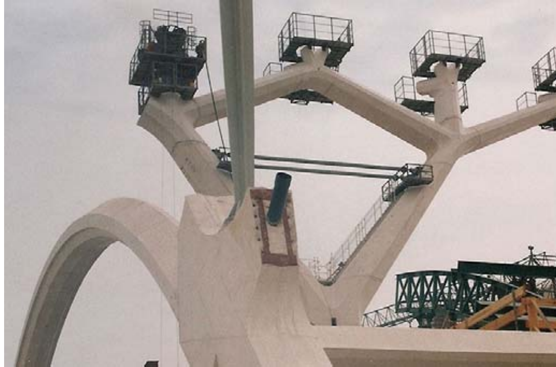
Ejecución de las pieza 3 y el nudo 3.
