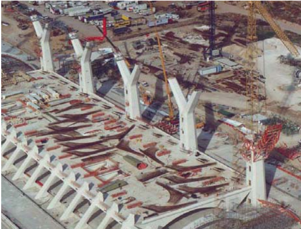
Ejecución de las piezas nº 2.
