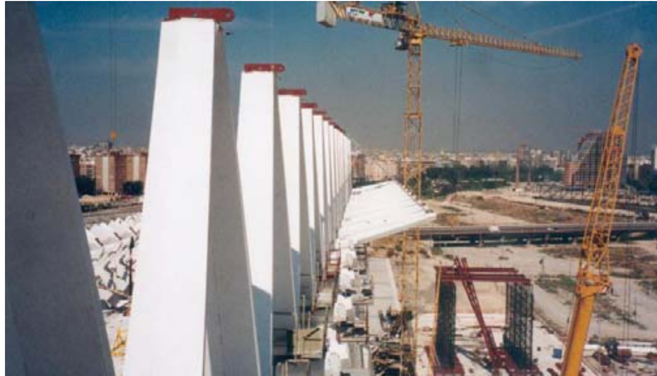
Ejecución de las piezas 6 y 7.
