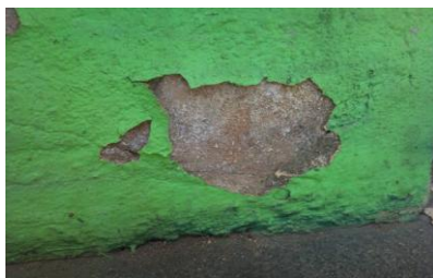
Fig. 24. Laguna producida en el muro.
