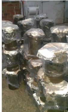
Fig. 1.4. Conservación de probetas en obra.
