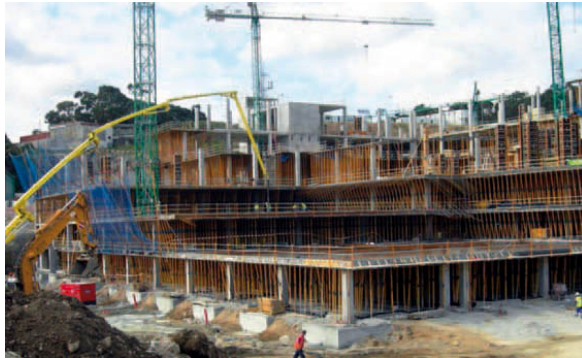
Fig. 2.21. Proceso de cimbrado y descimbrado. Centro comercial Marienda, A Coruña.
