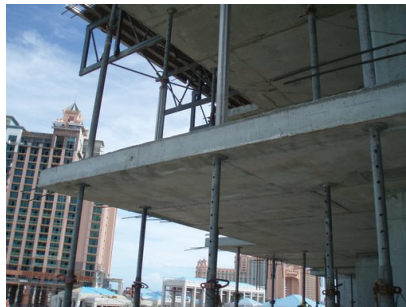
Fig. 2.22. Proceso de cimbrado recimbrado y descimbrado.
