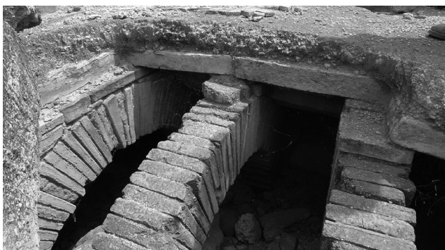
Figura 5. Vista de los arcos de ladrillo del hypocaustum, y de la configuración del suelo flotante
