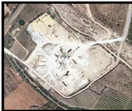
Fotografía 14.-Clase: Otros (movimientos de tierra)
