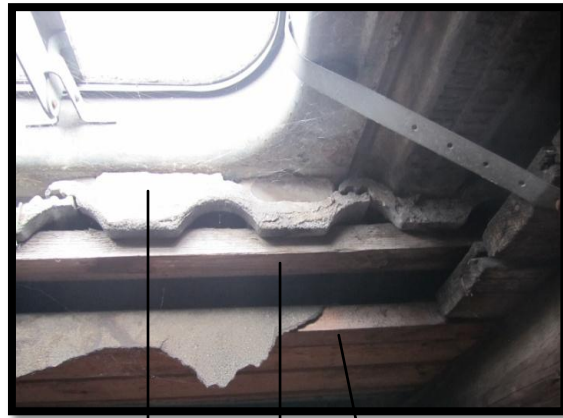
Sparren Verkleidung Dachpfannen Dachplatte Unterspannbahn Dachplatte
