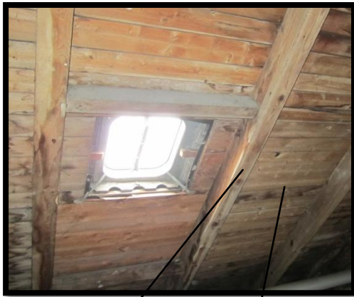
Sparren Verkleidung Dachpfannen Dachplatte Unterspannbahn Dachplatte
