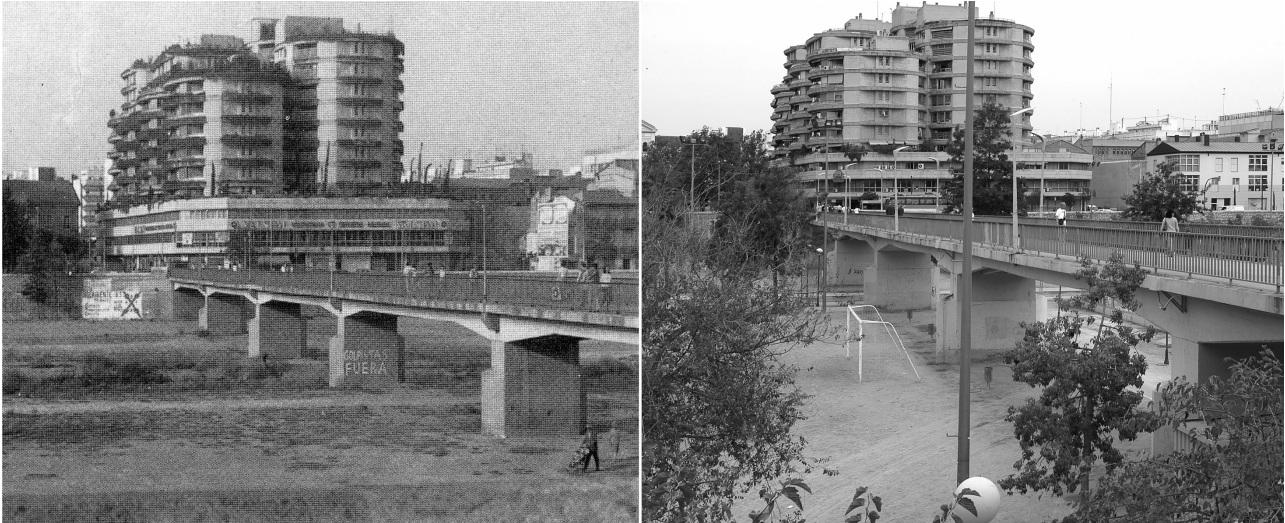
Figura 4. Comparativa del estado de la pasarela en el año 1982 y en la actualidad. (Archivo Valenciano)
