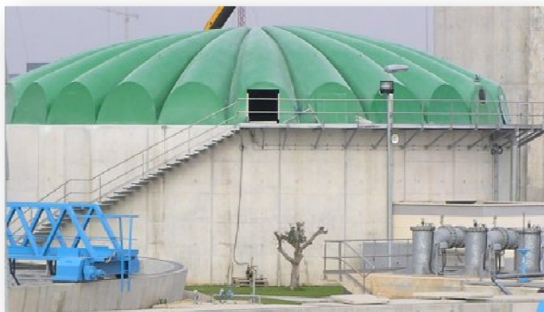
Figura 1. Espesador de la EDAR de Pinedo (Valencia)
