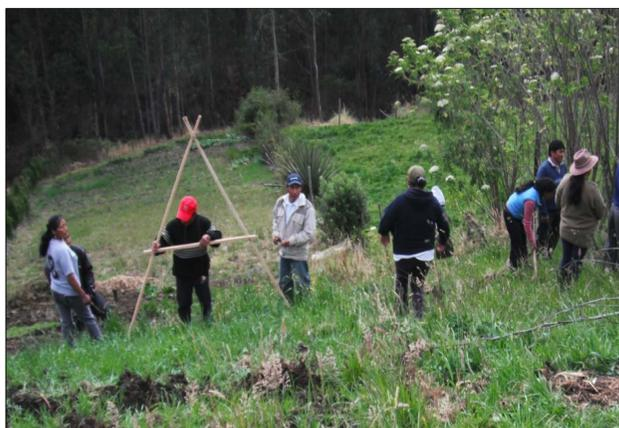
Presta-manos para la construcción de terrazas contra la erosión utilizando el nivel en A
