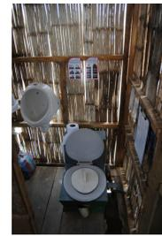
Water seco instalado en vivienda prototipo
