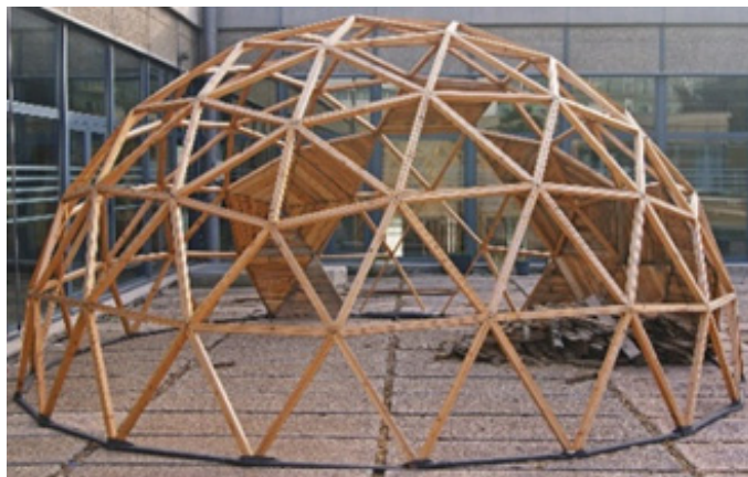
Imagen 5. Cúpula Geodésica 4v, instalada en la ETSIE
