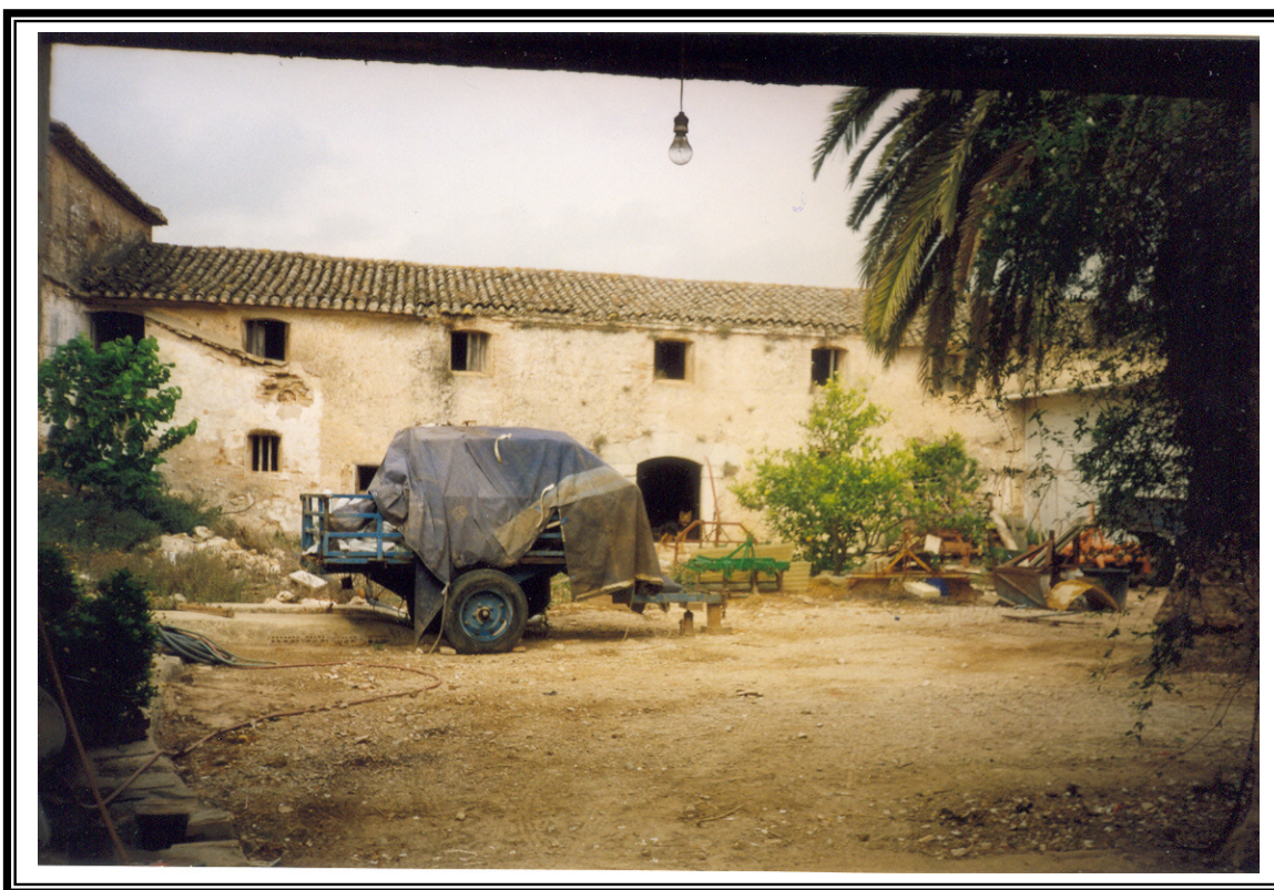
FOTO 12: Ala oest vista des de la porta principal de l'edificació.
