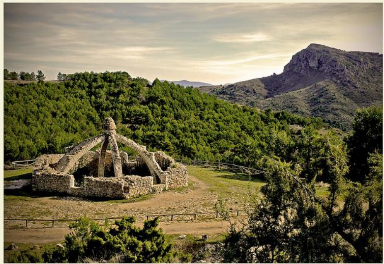
Figura 2. Cava arquejada de Muro
