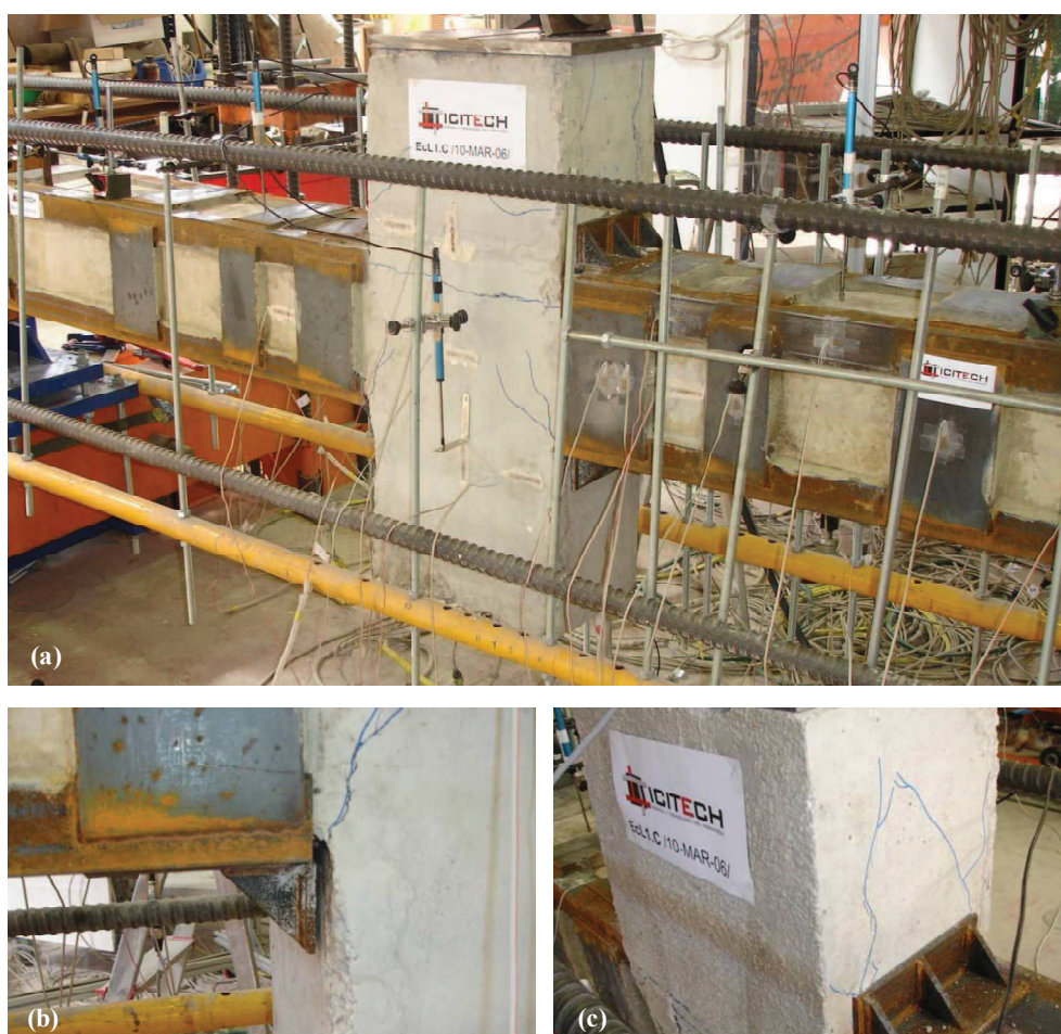
Fig. 3.21. Rotura de las probetas C-1000; (a) Vista general; (b) Fisuración aparecida en el entronque del soporte con el nudo viga-soporte y despegue del capitel; (c) Zona en compresión, capitel aplastando el hormigón del nudo.
