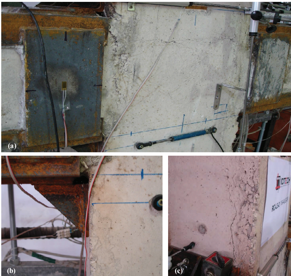
Fig. 3.24. Rotura de las probetas A-1200; (a) Vista general; (b) Zona en tracción, fisura aparecida en el entronque del soporte con el nudo viga-soporte; (c) Zona en compresión, capitel aplastando el hormigón del nudo.
