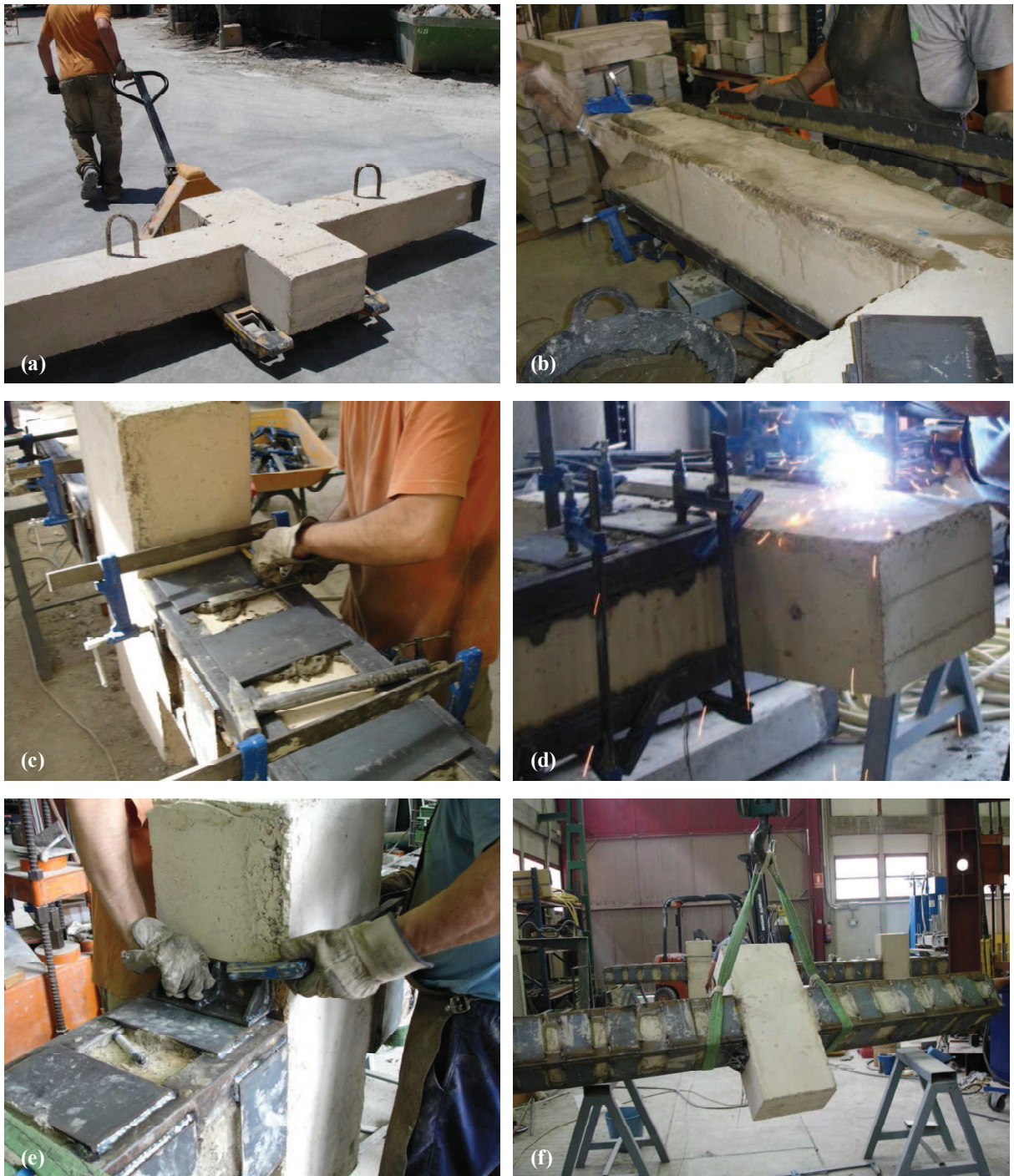
Fig. 3.11. Ejecución del refuerzo metálico: (a) Traslado de las probetas para el refuerzo; (b) Colocación de los angulares; (c) Colocación de las presillas; (d) Soldado de los angulares y presillas; (e) Colocación de los capiteles; (f) Probeta terminada, traslado para su acopio y ensayo posterior.
