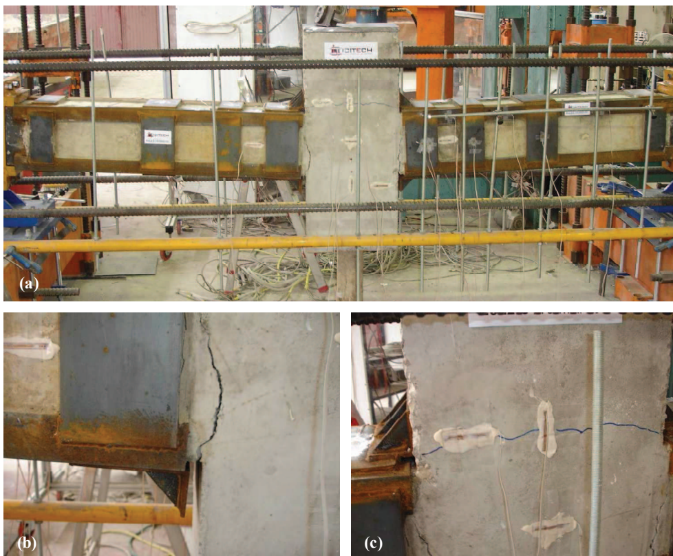
Fig. 3.20. Rotura de las probetas C-300; (a) Vista general; (b) Fisuración aparecida en el entronque del soporte con el nudo viga-soporte y despegue del capitel; (c) Zona en compresión, capitel aplastando el hormigón del nudo.
