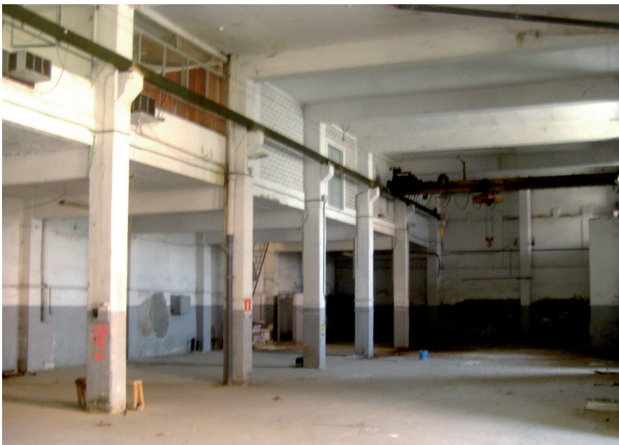
Vistas del interior de la Calderería
