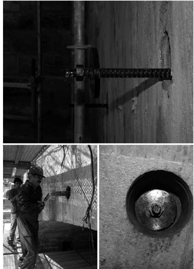
Figura 10. Proceso de colocación y tesado de las barras de acero de 11m.
