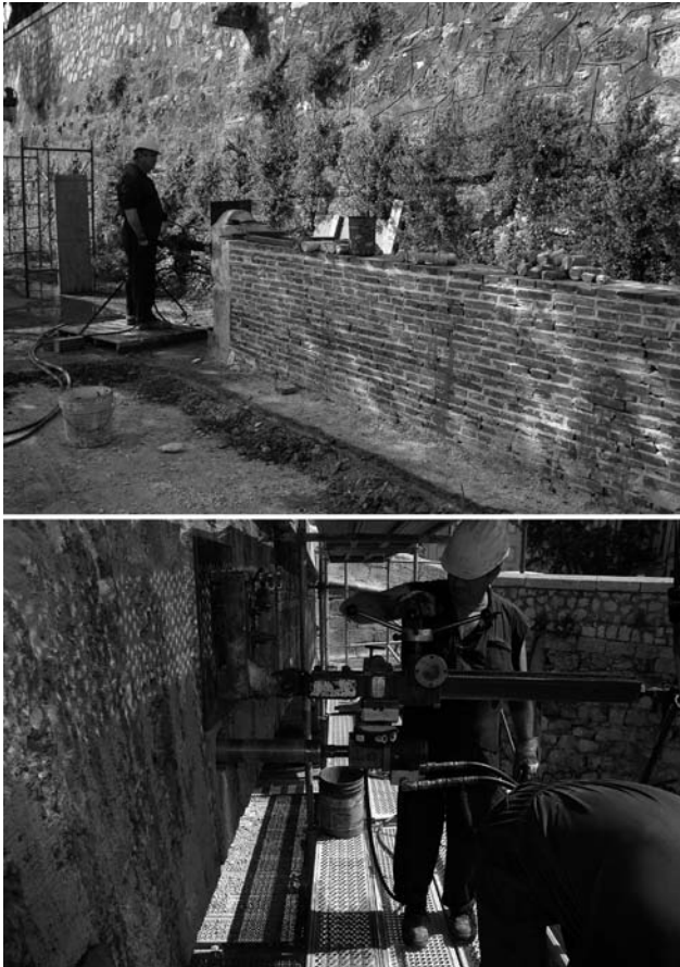
Figura 9. Ensayo de perforaciones de 11m, su ejecución en el puente.
