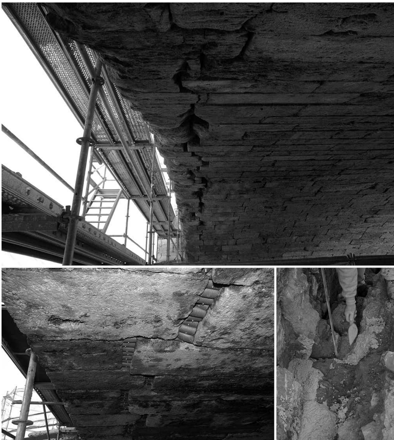
Figura 4. Proceso de sellado y relleno de las grietas.
