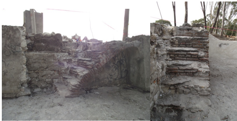
Figura 3.2.60. Escalera estado inicial.
