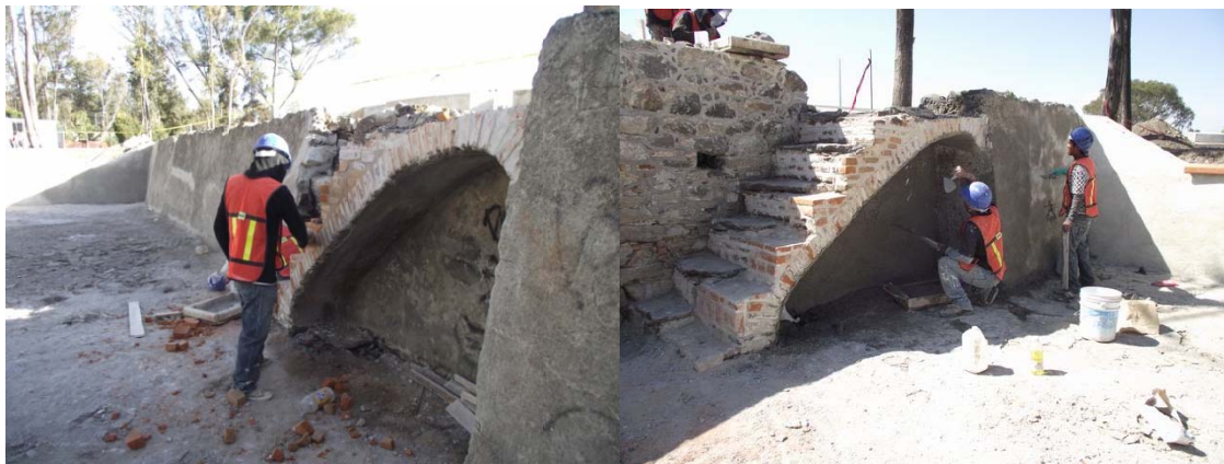
Figura 3.2.69. - Figura 3.2.70. Albañilería y remates finales.
