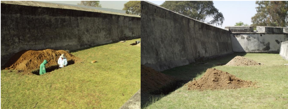
Figura 3.1.24-3.1.25. Operarios realizando los trabajos de excavación de las calas C1 y C2 de manera manual.
