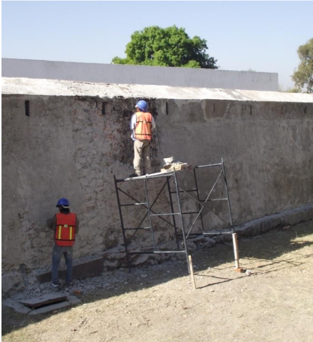
Figura 3.1.38. - Figura 3.1.39. (Izquierda y abajo). Operarios ejecutando el retiro de mortero de manera manual empleando un módulo de andamio
