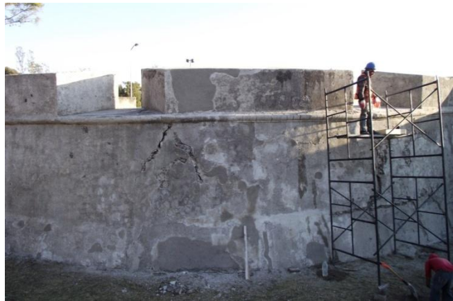
Figura 3.1.48. Ejecución de tratamiento en el fuerte
