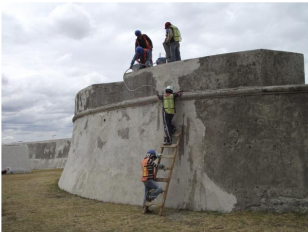
Figura 3.1.49. Inyección de grietas en bastión.
