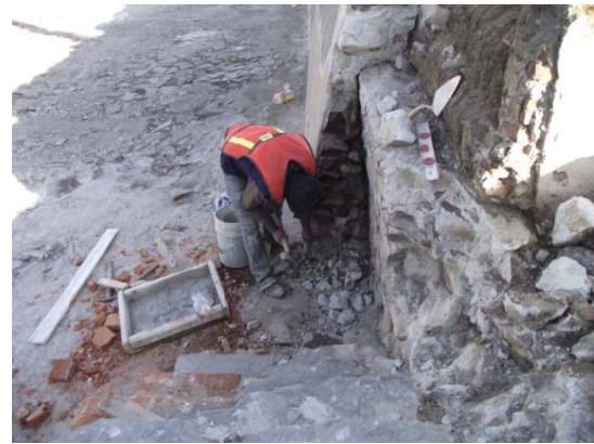
Figura 3.2.68. Retiro de muro de manera manual.
