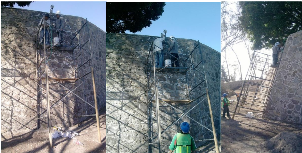
Figura 3.4.54. Manguera y la colocación de esta para poder iniciar la inyección de grietas.
