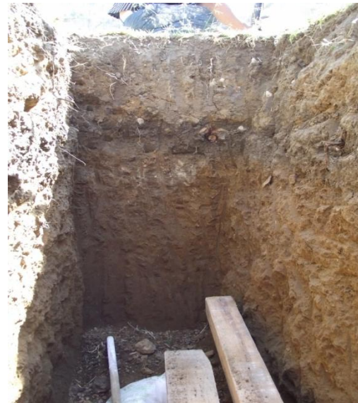
Figura 3.1.29. Cala C2 una vez excavada.
