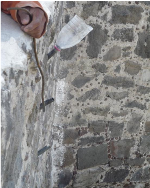
Figura 3.4.53. Tubo inyectado y la cabeza de botella utilizada como embudo
