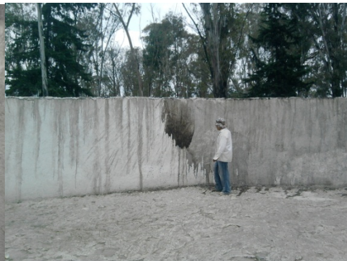
Figura 3.2.46. Pintado de superficie para homogeneizar los muros.
