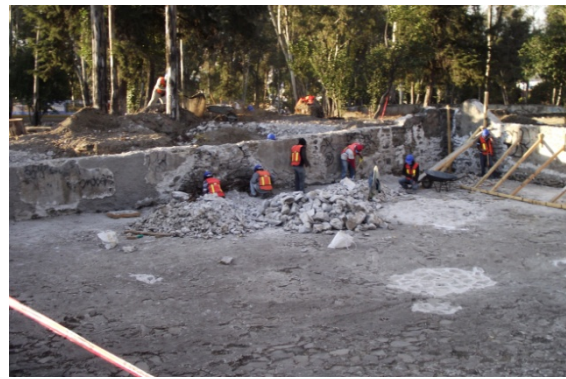
Figura 3.2.43. Figura 3.2.44. Ejecución de unión de secciones de muros.
