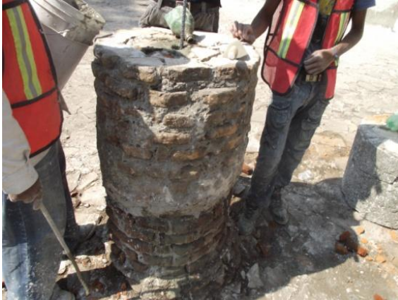
Figura 3.3.38.- Figura 3.3.39. Detalle progresión montaje de pilar.
