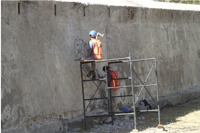
Figura 3.1.50. Retiro de anterior enfoscado de manera manual.
