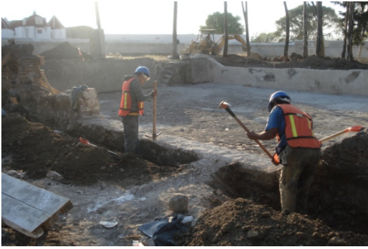
Figura 3.2.47. Renivelación de terreno, parte manual.
