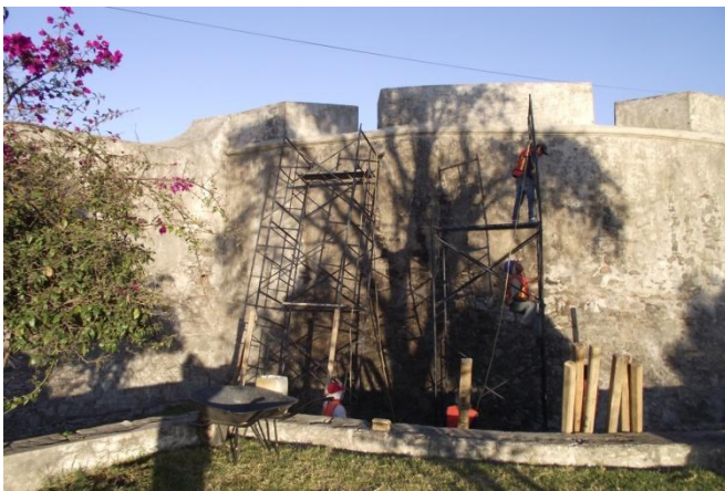
Figura 3.1.33. Desinfección de aljibe San Antonio.
