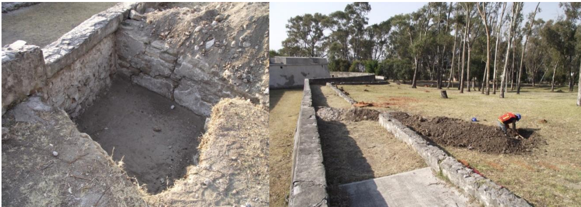
Figura 3.1.41. - Figura 3.1.42. Inicio de la excavación de la cala, y su posterior alargamiento para mostrar todo el sendero.
