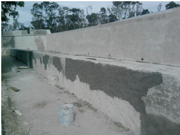
Figura 3.1.66.- Figura 3.1.67.- Figura 3.1.68. Ejecución del nuevo aplanado.
