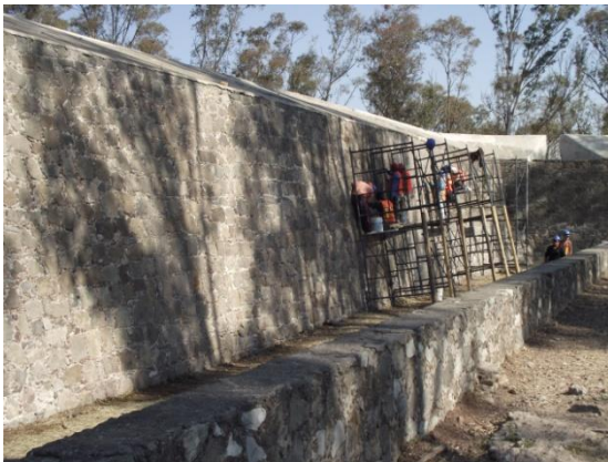
Figura 3.4.27. Limpieza manual en seco a lo largo de las escarpas.
