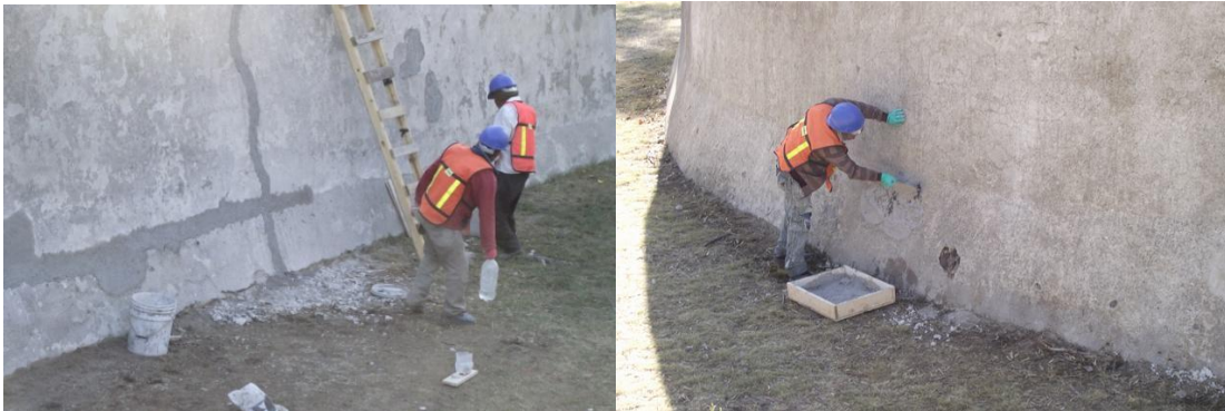
Figura 3.1.51. - Figura 3.1.52. Trabajos albañilería. Relleno de huecos y grietas.
