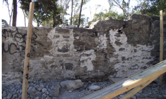
Figura 3.2.42. Unión de secciones de muros.
