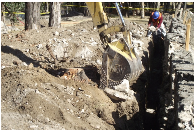
Figura 3.2.35. Eliminación de los tocones del perímetro del aljibe.
