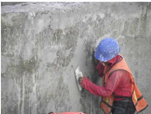
Figura 3.2.45. Enfoscado y aplanado de la superficie.
