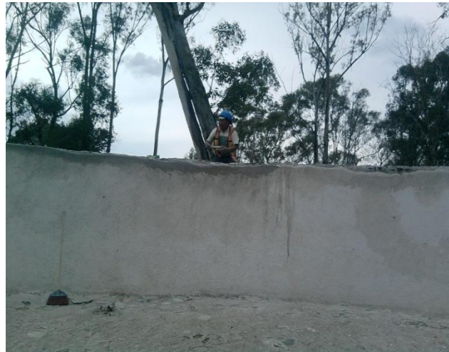
Figura 3.3.14. - Figura 3.3.15. Homogenización del intradós del muro.
