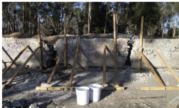
Figura 3.2. 41. Aplomado de muros.
