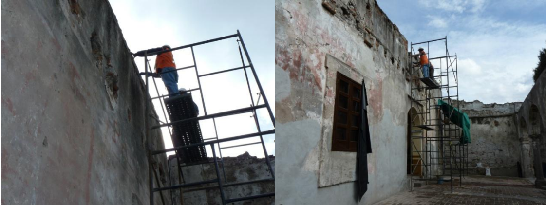
Figura 3.5.19. Operarios ejecutando los tratamientos en la zona superior de la fachada.
