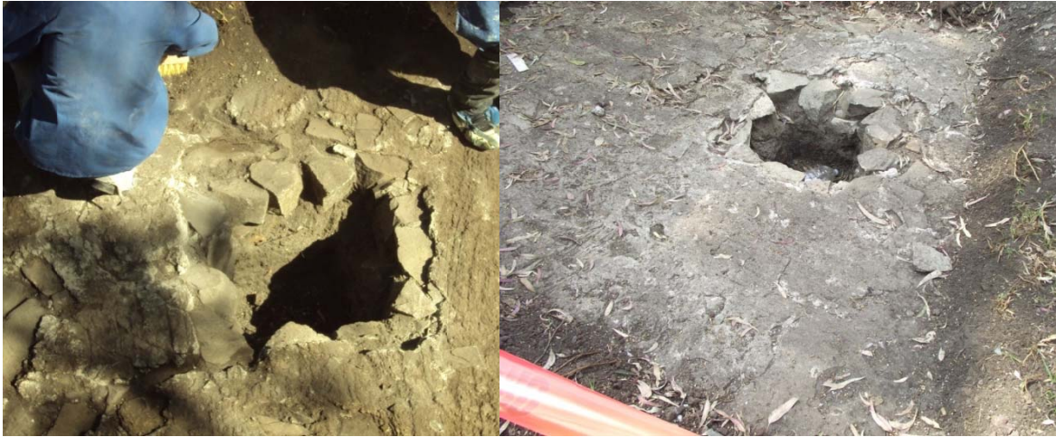
Figura 3.2.7. - Figura 3.2.8. Ejecución de la cala.
