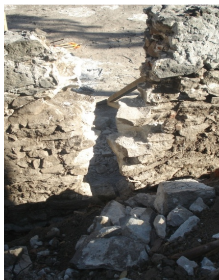
Figura 3.2. 40. Limpieza de secciones de muros.
