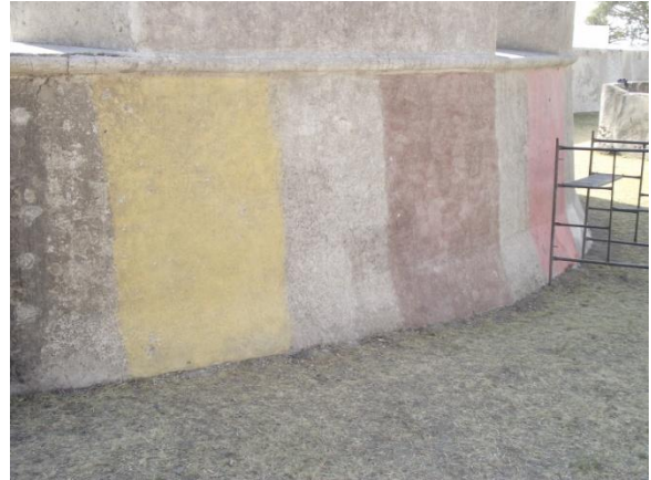
Figura 3.1.60. - Figura 3.1.61. Muestras de pintura en bastión.
