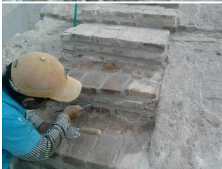
Figura 3.3.27.(arriba) Figura 3.3.28. (abajo). Ejecución de albañilería y rejunteo de grietas.
