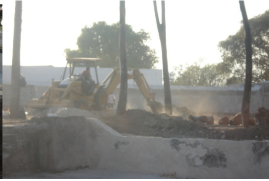
Figura 3.2.48. Renivelación de terreno, parte mecánica.
