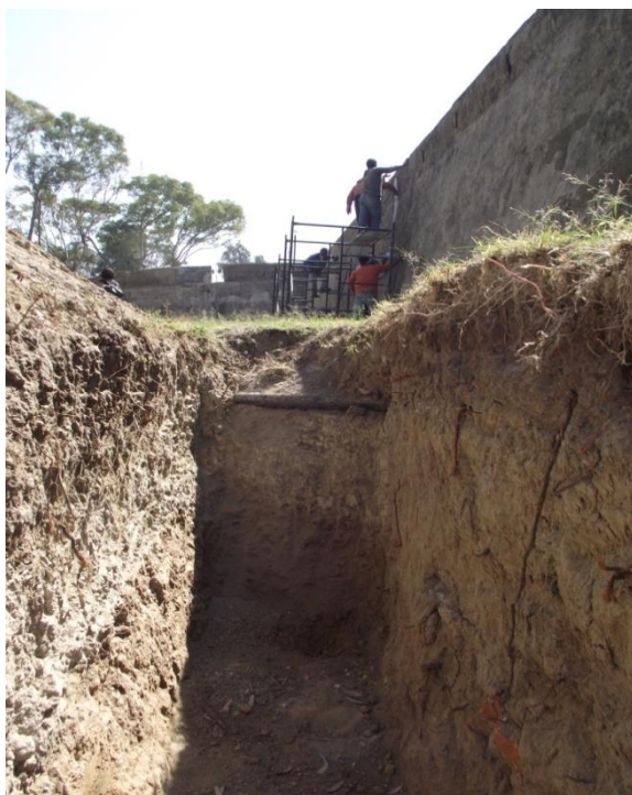
Figura 3.1.26. Cala C1 una vez excavada. En la zona superior se puede observar la tubería.
