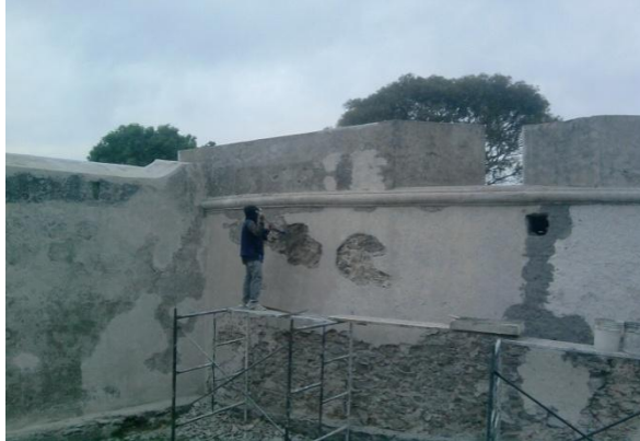
Figura 3.1.63.- Figura 3.1.64.- Figura 3.1.65. Retiro de aplanado de manera manual.
