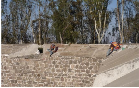
Figura 3.4.60. Operarios ejecutando el inicio del tratamiento.
