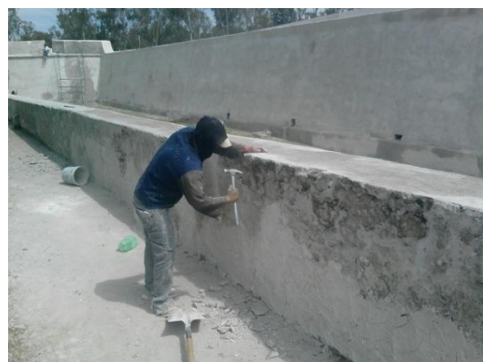
Figura 3.1.62. Retiro de aplanado de manera manual.
